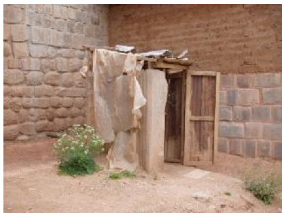
VISTAS DEL FRENTE OESTE DONDE SE UBICAN LA CAPILLA DEL SAN CRISTOBAL, LA CAPILLA SR FORTALEZA Y EL BAPTISTERIO EN PROCESO DE RESTAURACION
