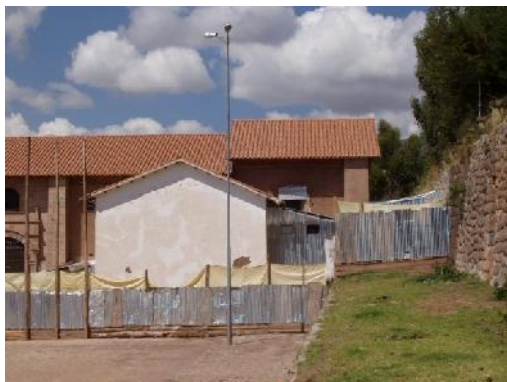
VISTA DE LA CAPILLA DEL SR DE LA CAIDA CUYA ESTRUCTURA FALTA INTERVENIR
