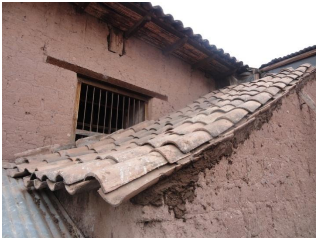
Vista 53.- Retejado de cubierta del ambiente donde se encuentra la escalera de acceso al pulpito de la capilla, se cambie el mortero y se colocan nuevamente las unidades de teja.
