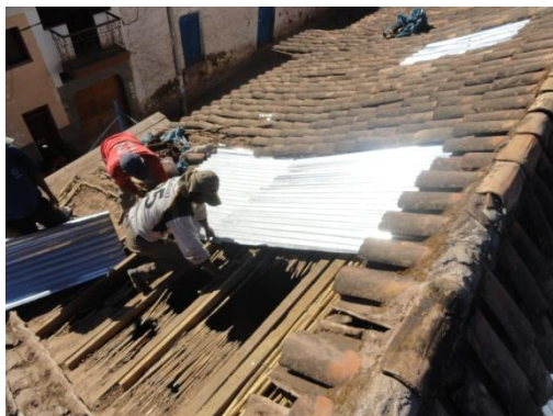
Vista 66, 67, 68, 69.- Cubierta de protección con planchas de calamina en la nave de la Capilla a la altura del Presbiterio, previamente se verificó el estado del techo.
