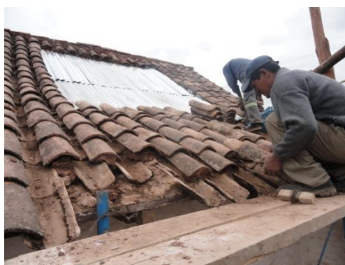
Vista 66, 67, 68, 69.- Cubierta de protección con planchas de calamina en la nave de la Capilla a la altura del Presbiterio, previamente se verificó el estado del techo.
