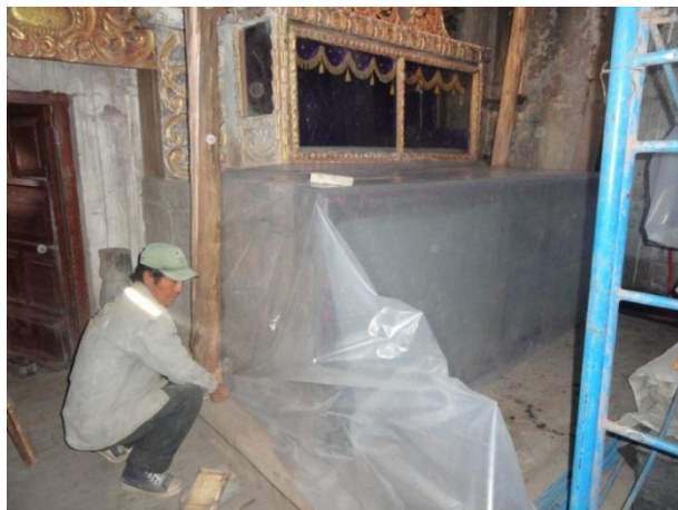
Vista 46.-Proteccion de mesa de altar en la nave de la capilla con madera y plástico transparente.
