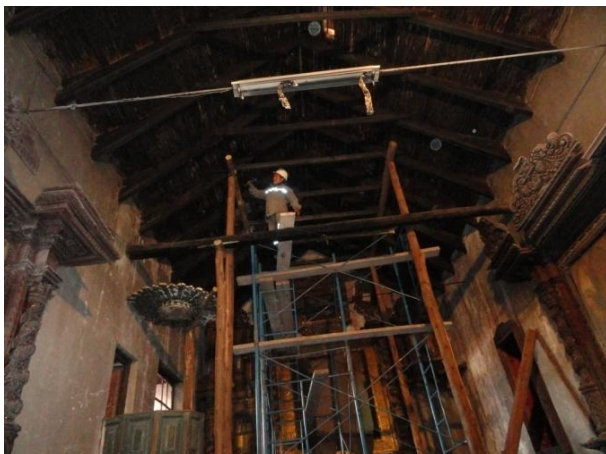
Vista 49.- Apuntalamiento de estructura par y nudillo en nave de capilla con madera rolliza de 6\" a 8\".
