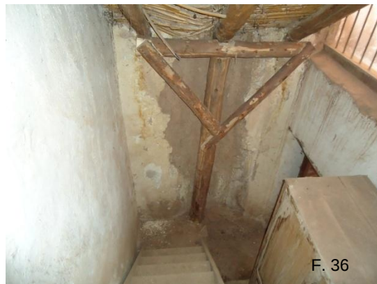
F. 35, 36.- Vista de los trabajos de apuntalamiento de muros de adobe al interior y exterior del espacio donde se encuentra la caja de escaleras que va al pulpito.
