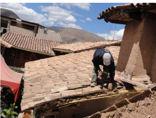
Vista 70, 71, 72, 73.- Retejado de techo con el cambio de mortero y piezas fracturadas de tejas, en la Nave de la Capilla, Presbiterio, sacristía.
