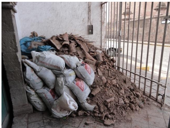
Vista 64.- Eliminación de material excedente producto de las liberaciones, remociones y desechos de la cubierta que fueron reunidos en el atrio de la Capilla.
