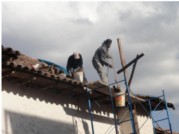
Vista 63.- Traslado vertical de materiales como: tejas, mortero de tierra, planchas de calamina entre otros.
