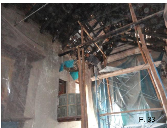
F. 33, 34.- Apuntalamiento de estructura de madera pare y nudillo en techo a la altura del presbiterio.
