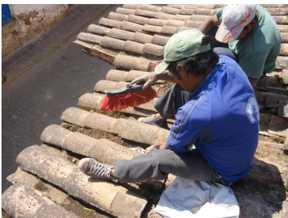
Vista 65.- Limpieza permanente de la cubierta de tejas de la Nave de la Capilla, limpieza de las unidades cubiertas por tierra.
