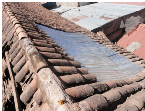
Vista 66, 67, 68, 69.- Cubierta de protección con planchas de calamina en la nave de la Capilla a la altura del Presbiterio, previamente se verificó el estado del techo.
