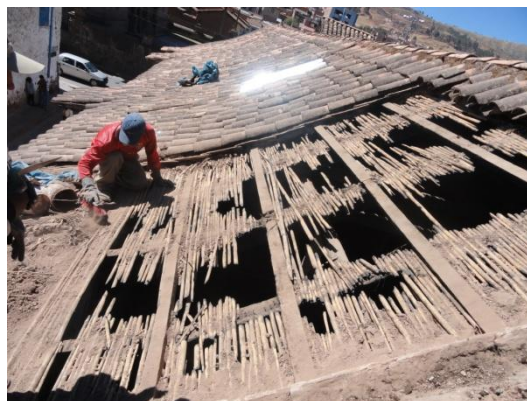
Vistas 56, 57, 58, 59.- Liberación de cubierta de teja en la nave de la Capilla, liberación de tejas fracturadas, torta de barro, y encarrizado quemado, y verificación del estado de la estructura de madera del techo.
