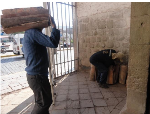
Vista 62.- Acarreo de materiales tejas para el retejado de cubierta de la nave de la Canilla
