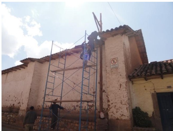
Vista 60.- Instalación de polea de 2 Tn a la altura del Presbiterio hacia el lado del muro de la Epístola para el traslado vertical de materiales.
