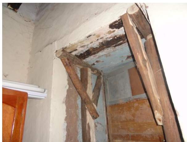
Vista 51.- Apuntalamiento de dintel en vano de acceso a la sacristía de la canilla
