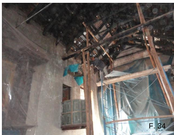
F. 33, 34.- Apuntalamiento de estructura de madera pare y nudillo en techo a la altura del presbiterio.
