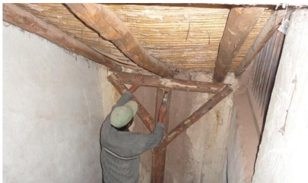
Vista 50.- apuntalamiento de techo de ambiente de acceso – escalera hacia el pulpito.
