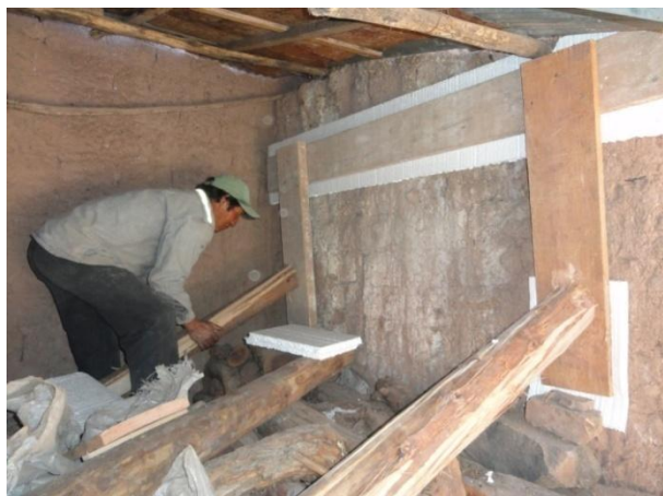
Vista 47.- Apuntalamiento de muro de adobe exterior del ambiente de acceso – escaleras hacia el pulpito de la capilla.
