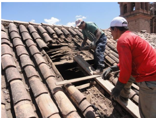
Vistas 56, 57, 58, 59.- Liberación de cubierta de teja en la nave de la Capilla, liberación de tejas fracturadas, torta de barro, y encarrizado quemado, y verificación del estado de la estructura de madera del techo.
