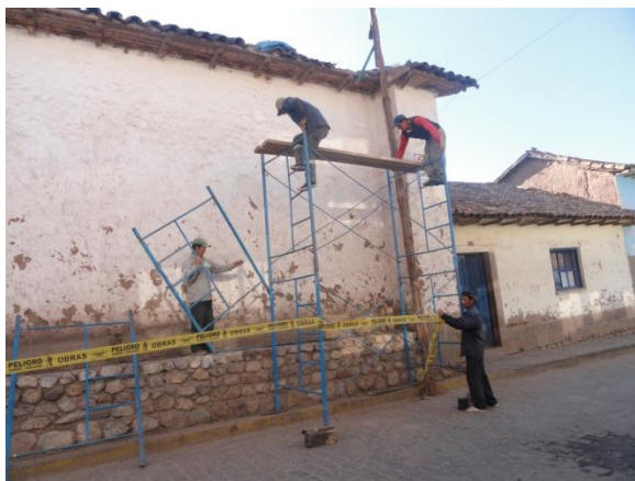
Vista 61.- Instalación de andamio metálico para los trabajos en cubierta.
