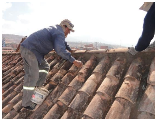
Vista 70, 71, 72, 73.- Retejado de techo con el cambio de mortero y piezas fracturadas de tejas, en la Nave de la Capilla, Presbiterio, sacristía.
