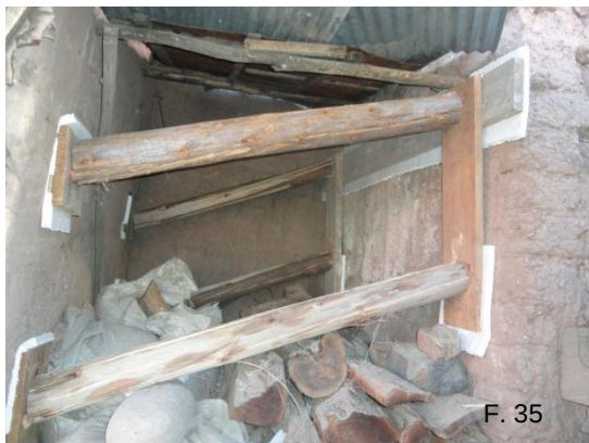
F. 35, 36.- Vista de los trabajos de apuntalamiento de muros de adobe al interior y exterior del espacio donde se encuentra la caja de escaleras que va al pulpito.
