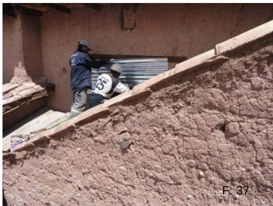
F. 37, 38.- Vista de los trabajos de tapiado en ventanas desde la parte exterior para evitar el ingreso de aguas pluviales.
