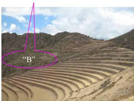
Hacia el Oeste del área de intervención, Compuesto por muros de contención, construido con rocas andesitas, canteadas unidas con mortero de barro, de una altura de 0.90 a 1.30 m de mampostería simple, concertado y fino, y 02 murallas que circundan el área, una de las murallas se proyecta desde la portada de K'allaqasa que da acceso hacia la parte urbana y el túnel, la muralla está construido con bloques de piedra
