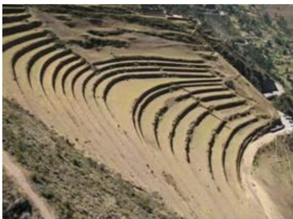
una sucesión de 23 andenes agrícolas y 01 muro de contención. Edificados de acuerdo a la pendiente del terreno, con piedras canteadas y semi labradas, unido con mortero de barro de mampostería simple y concertado, asimismo la configuración de los muros en la parte media simula en forma de media luna y en los extremos son ligeramente rectas, igualmente en cuanto a la altura varía desde 1.28m hasta 5.50 m y de longitud varía desde
