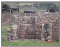
hasta una profundidad de 10 a 15 cm. limpiando las piedras para luego lavarlas con un cepillo, y restituir el emboquillado con un mortero mejorado compuesto por una mezcla de cal y arena, en una dosificación de 1:3.
