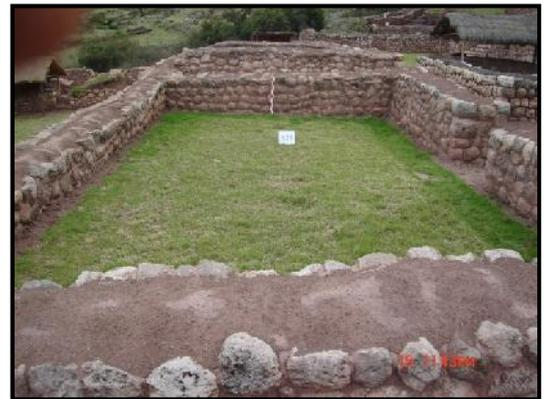
**Restauración del recinto Nº 30** Restaurar el muro del recinto del Sector III A, del Conjunto Arqueológico de Maukallaqta, se realizaron labores específicos de consolidación, recomposición, restitución con material propio y solo para garantizar la estabilidad del muro de contención y nivel de piso se realizaron restitución con material nuevo, que tiene las siguientes dimensiones:
