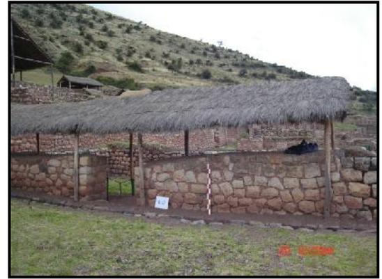
**Restauración del recinto Nº 26** se restauró el muro del recinto del Sector III A, del Conjunto Arqueológico de Maukallaqta, previa Investigación Arqueológica, se realizaron labores específicas de consolidación, recomposición, restitución con material propio y solo para garantizar la estabilidad del muro de contención y nivel de piso se realizaron restitución con material propio; tiene las siguientes dimensiones:
