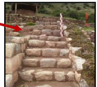
**Restauración del “canal y escalinata”;** se desarrollo la intervención en la fuente de agua que se ubica en el sub sector III A, tomando en consideración la mínima intervención, se realizaron labores específicas de consolidación, recomposición y restitución con material propio.
