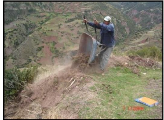
**Métodos de ejecución.-** Todo el material de desecho que queda después del zarandeo del material extraído en las excavaciones arqueológicas, excavaciones masivas, los rehechos de los trabajos de restitución, recomposición y la construcción del muro, su traslado será en boogües a un lugar alejado y fuera del sitio arqueológico; después de su respectivo zarandeado, para no poner en peligro el medio ambiente.
