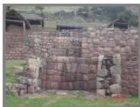
realizaron labores específicos de consolidación, recomposición, restitución con material propio , emboquillado y cubertinas, para garantizar la estabilidad de los muros laterales de contención y nivel de piso.
