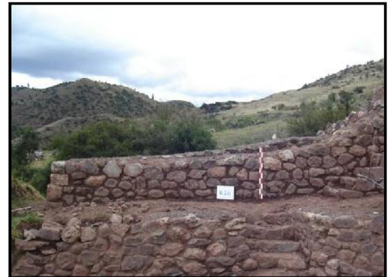
**Restauración del recinto Nº 27** Se restauró el muro del recinto del Sector III A, del Conjunto Arqueológico de Maukallaqta, se realizaron labores específicas de consolidación, recomposición, restitución con material propio y solo para garantizar la estabilidad del muro de contención y nivel de piso se realizaron restitución con material propio.
