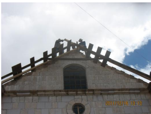
VISTA DEL COLOCADO DE LOS PARES EN EL MURO DE PIES DEL TEMPLO
