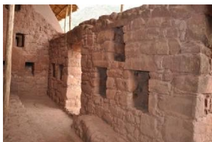
F.29.- (R3-b): Vista interior del muro oeste con la distribución de homacinas y vano de acceso posterior al proceso de intervención.
