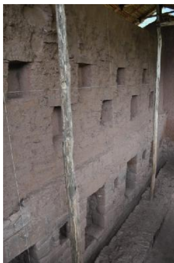
F.26.- (R3-b): Vista interior muro este con la distribución de hornacinas y nichos en muro de piedra y adobe.
