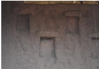
F 16.- (R3-a): Distribución de nichos en muro de adobe de manera escalonada.
