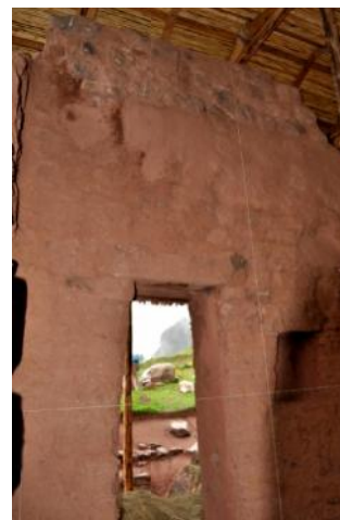
F.25.- (R3-b): Véase en la parte superior aparejo de piedra sobre muro de adobe.
