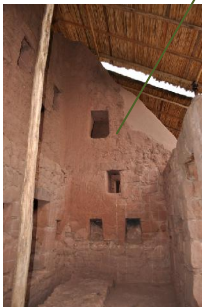
F.35.- (R3-b): Vista interior del muro sur primer nivel con aparejo de piedra y segundo nivel muestra parte de hastial en adobe, sobre este se observa la distribución de vanos y nichos.
