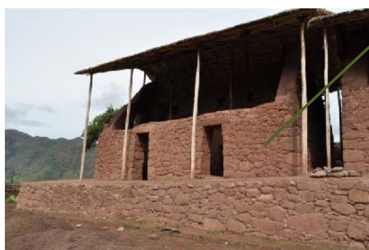
F.34.- (R3-b): Muro oeste con vanos de acceso, aparejo de piedra labrada se observan cuñas entre las juntas de las piedras diferenciándose de los demás muros de la Zona Arqueológica.
