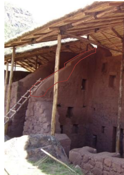
F 13.- (R3a): muro sur intervenido con la consolidación de muros de piedra y adobe mediante la restitución de unidades de adobe devolviendo la forma del hastial.
