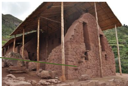
F.20.- (R3-a): Vista del muro norte hastial del Recinto R3 con elementos arquitectónicos como escalinatas vanos en muro de piedra canteada y adobe después del proceso de intervención.
