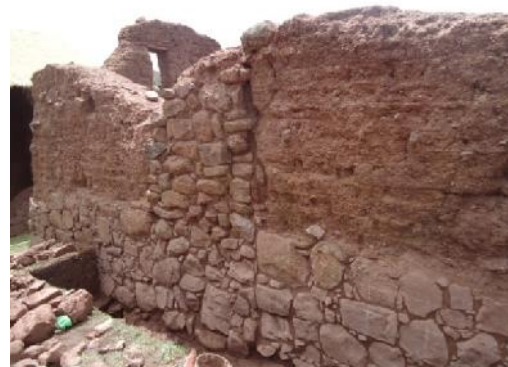
F.44.- (R4-b): Vista muro sur exterior con la consolidación de cimientos, sobrecimientos y muros de piedra.
