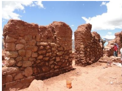
F.41.- (R4-b): Vista muro norte se realizaron los trabajos de consolidación en sobrecimientos y muro de piedra.
