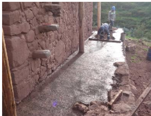
F. 50.- (EA4): Tratamiento de piso en la parte norte con mortero de tierra, arcilla, cemento, arena y gravilla.
