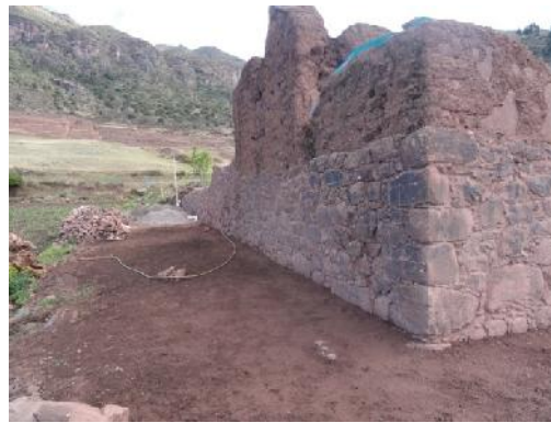
F.39.- (R4-a): Muro sur vista interior donde se realizaron los trabajos de consolidación a nivel de sobrecimiento y muros de amarre de piedra
