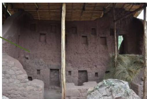
F.21.- (R3-a): Vista del muro oeste del Recinto R3a, véase la composición de nichos y homacinas en superficie inferior en piedra y en la superior en adobe, posterior al proceso de intervención.
