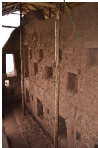
F.36.- (R3-b): Muro este primer nivel en mampostería de piedra y segundo nivel en adobe, sobre éste nicho y hornacinas distribuidas de manera lineal y escalonada.
