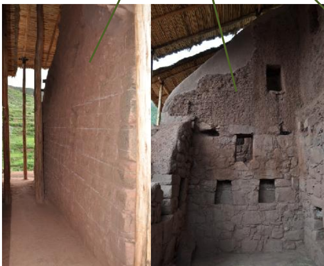
F.23, 24.- (R3-a): Vista exterior e interior de muro sur del Recinto R3a, en la parte interior la disposición de nichos en mampostería de piedra y en muro de adobe, en la parte superior la restitución de unidades de adobe devolviendo la forma del hastial. Al exterior se nota el aparejo de piedra canteada y cuñas entre las juntas como muestra de un aparejo distinto del sector a comparación de lo hallado en la Zona Arqueológica.
