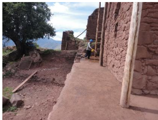
F. 56.- Tratamiento de piso con mortero cemento-arena y gravilla del Espacio abierto 4 lado norte.
