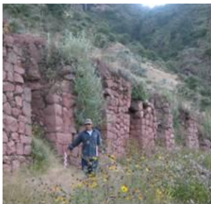
02.- Estructuras Inka inicial en el sub sector B, se nota la pérdida de dinteles en las homacinas, los que según la Arqta. Maritza Rosa, eran de aliso
