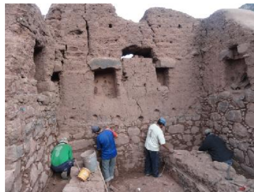
F.42.- (R4-b): Vista muro este se realizaron los trabajos de consolidación en sobrecimientos y muro de piedra.
