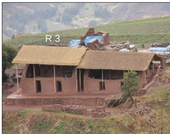
F8.- (R3a): Vista del Recinto 3 desde el lado Oeste de la zona Arqueológica después de la intervención.
