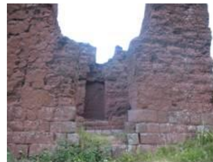
04.- Edificación para fines religiosos, con mampostería de estilo engastado
