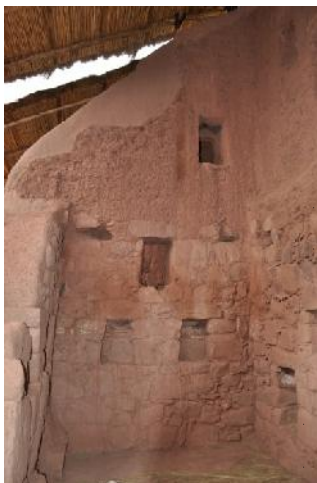
F 14.- (R3a): Vista interior con la distribución de vanos y nichos sobre el muro hastial.
