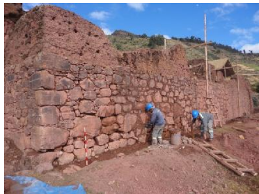
F.37.- (R4-a): Muro norte vista exterior donde se realizaron los trabajos de consolidación y recomposición.
