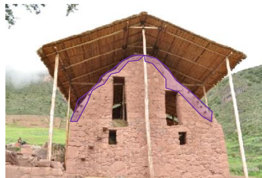
F. 53.- Restitución de unidades de adobe devolviendo el lenguaje formal del hastial en recinto.
