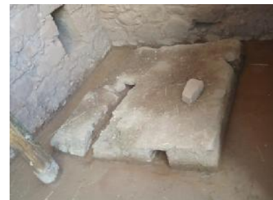
F 18.- (R3-a): Estructura cuadrangular ubicada en la parte norte del recinto.
