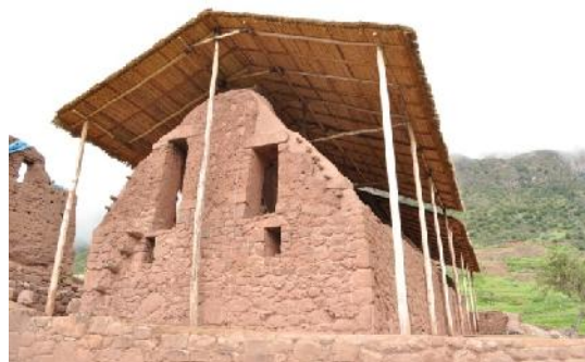
F. 54.- Cubierta de protección recinto R3.
