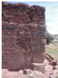
F.39.- (R4-a): Muro sur vista interior donde se realizaron los trabajos de consolidación a nivel de sobrecimiento y muros de amarre de piedra
