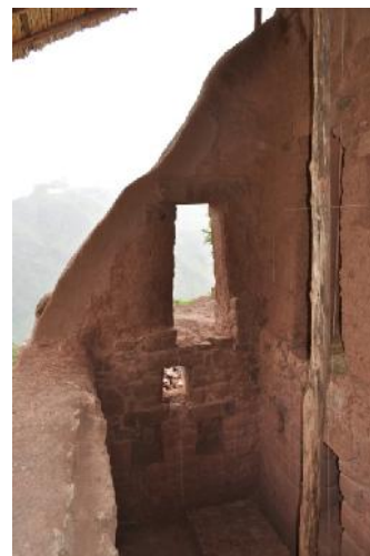
F.30.- (R3-b): Vista interior del muro norte con vanos y homacinas e en muro de piedra y adobe.
