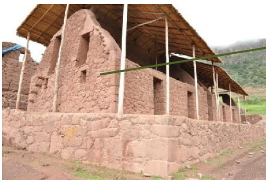
F.33.- (R3-b): Vista exterior del muro norte con aparejo de piedra v en la parte superior hastial en adobe.
