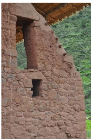
F.31.- (R3-b): Muro norte vista exterior con los vanos sobre muro de piedra y adobe.
