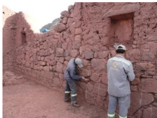
F.43.- (R4-b): Vista muro sur con la consolidación de sobrecimientos y muros de piedra.
