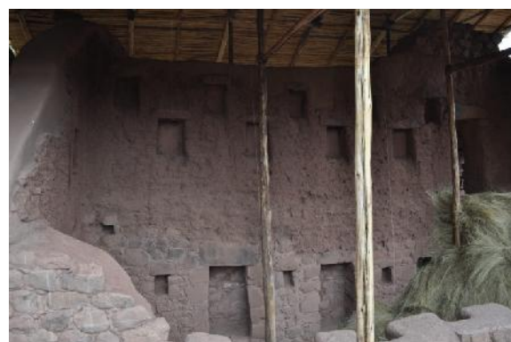
F 15.- (R3-a): Muro oeste de piedra canteada simple y tallada con homacinas, nichos en el primer nivel, hacia el segundo nivel muro de adobe con la distribución de nichos se realizaron trabajos de consolidación y tratamiento de forados
