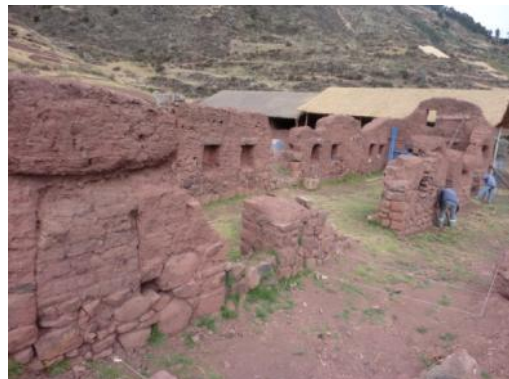
F.38.- (R4-a): Muro sur vista interior donde se realizaron los trabajos de consolidación a nivel de sobrecimiento y muros de anarain de piedra
