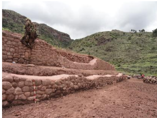
F. 51.- Recuperación de la estabilidad de estructuras, muros de contención en los andenes 01 y 02.
