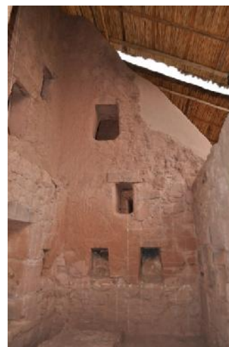
F.27.- (R3-b): Vista interior muro sur hastial nótese la distribución de homacinas y nichos en muro de piedra y adobe.
