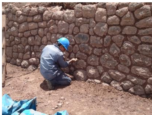
F. 52.- Consolidación en muros recuperación de material ligante (mortero).
