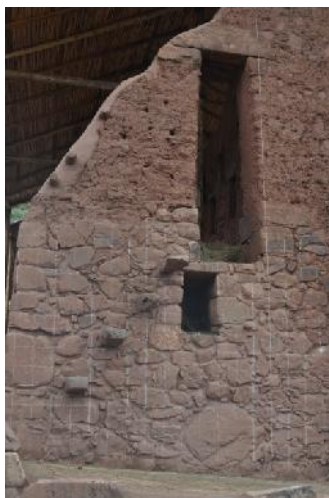
F 10.- (R3a): Muro norte con vanos de acceso y tipo ventana, escalinatas de piedra hacia un segundo nivel.
