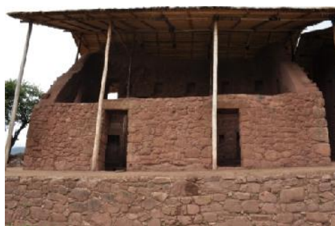
F.28.- (R3-b): Muro oeste vista exterior después del proceso de consolidación y restitución.
