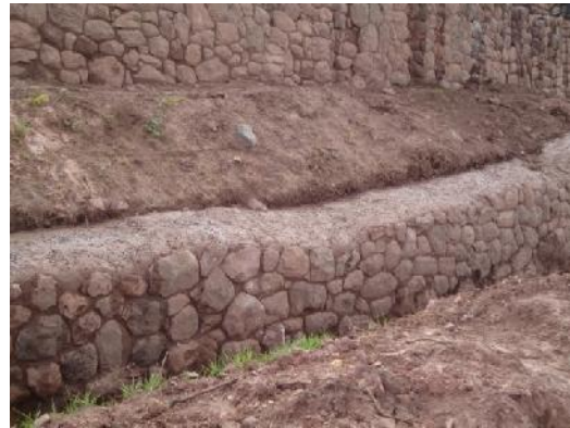
F.46.- (AN 01): Vista del Anden 01 posterior a los trabajos de intervención con la restitución, recomposición y cubertinas de protección.
