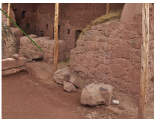
F.22.- (R3-a): Vista exterior del muro este del Recinto R3a, encontrando parte del muro de piedra canteada después de la restauración.
