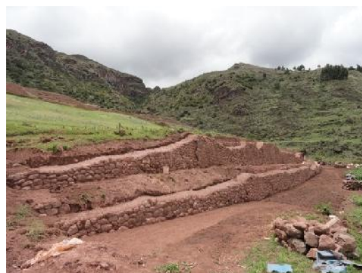
F.48.- (AN 01): Vista panorámica de los andenes 01 y 02 desde Este posteriormente al proceso de intervención.
