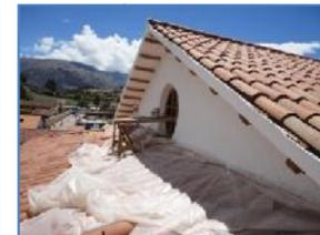
**Foto (394-395-396-397-398-399-400-401)** Vista de los trabajos de armado de andamios metálicos para trabajos de pintura en muros exteriores, trabajos consistentes en masillado y lijado, imprimado y posterior pintados de aleros y muros, dichos trabajos se realizaron en el imafronte así como en el muro de la epístola parte externa; se utilizaron lijar y brochas de diferentes dimensiones
