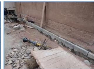
**Foto (305-306-307-308)** Vista de los trabajos de asentado de sardinel de piedra para gradas perimetrales al largo del muro del evangelio.
