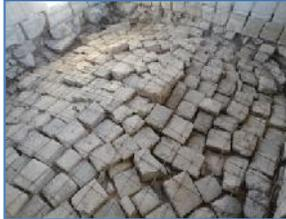
**Foto (200-201-202-203)** Vista de los trabajos de liberado de relleno en el entrespiso del segundo cuerpo de la torre así como el colocado de malla de temperatura con fierro de 3/8" @ 0.20 mt para su posterior vaciado con puzolana y piedra pómez.
