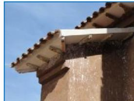
**Foto (174-175-176)** Vista de los trabajos de entucido de aleros y embarre de muros en contrafuerte de la capilla del baptisterio.
