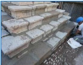
**Foto (177-178-179-180-181-182-183-184-185-186-187)** Vista de los trabajos de recomposición de cruz de piedra, trabajos que consistieron en calzaduras restitución de piezas, recomposición y
