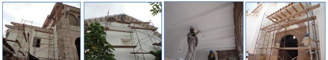
**Foto (429-430-431-432-433)** Vista de los trabajos de pintura en exteriores (01 marfil por 05 blancos) y cielo rasos (blanco) dichos trabajos se realizo previo al proceso de imprimado y sellado de muros y
