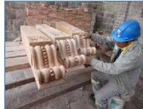
**Foto (390-391-392-393)** Vista de los trabajos de tallado de ménsulas y sobre ménsulas decorativas, dicho trabajo se realiza en madera cedro los cuales serán restituidos en muros del
