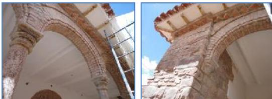
Foto (83-84-85-86-87-88-89) Vista de los trabajo de liberado de juntas ladrillo pastelero para su posterior consolidación (emboquillado) con mortero de cal: arena más cemento en relación de 1: 4
