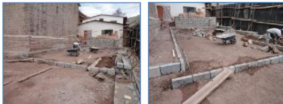
**Foto (241-242)** Vista de los trabajos de asentado de sardinell de h 0.20mt para gradas perimetrales en la torre así como de demarcaciones de cambios de nivel; dichos trabajos se realizaron en el atrio lado nor oeste del templo.
