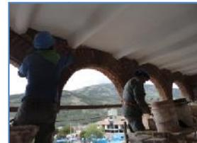
**Foto (42-43-44-45)** Vista de los trabajos de liberado de juntas de ladrillo pastelero en los arcos de la logia para su posterior emboquillado con mortero de cal: arena: cemento.
