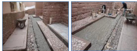
**Foto (423-424-425-426-427-428)** Vista de los trabajos de restitución de sardinel, canto rodado y canales de piedra, fraguado de pisos, dichos trabajos se ejecutaron en el sector del muro testero y lado del evangelio.
