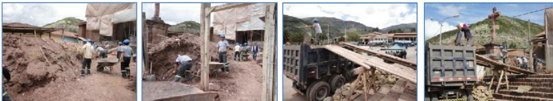
**Foto (60-61-62-63)** Vista de los trabajos de eliminación de desmonte mediante la utilización de herramientas manuales, bugües y volquete por parte de la DRC-C para su traslado respectivo.
