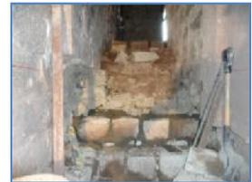
**Foto (34-35-36-37)** Vista de los trabajos de desmontaje previa codificación de las piezas líticas y su posterior recomposición de gradas de accesos al segundo cuerpo de la torre.
