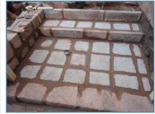
**Foto (298-299-300-301)** Vista de los trabajos de restitución de pisos de laja en accesos laterales de la puerta ubicada al muro del evangelio así como el acceso lateral por la avenida Belaunde Terry como su posterior fraguado para la fijación de las piedras con mortero de cal : arena mas cemento en proporción de 1 de cemento nor 3 de mortero.
