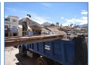
**Foto (294-295-296-297)** Vista de los trabajos de eliminación de desmonte en volquete de la DRC-C de los diferentes sectores de trabajo generado por la instalación de tubería cribada.
