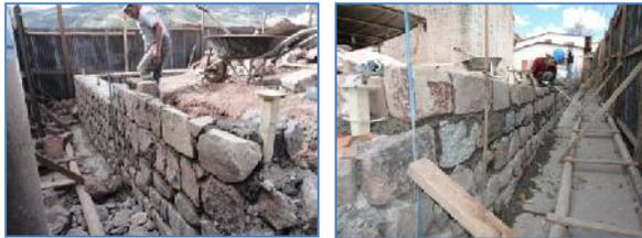
**Foto (218-219-220-221-222-223)** Vista de los trabajos de recomposición de sobre cimientos en el lado nor oeste del templo así como el colocado de anclajes metálicos para rejas de seguridad.
