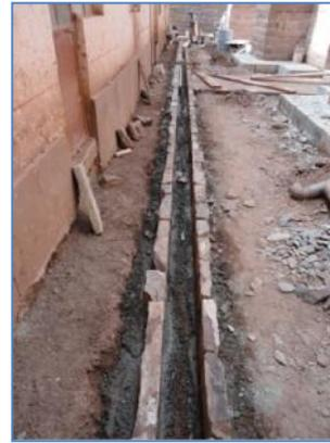
**Foto (302-303-304)** Vista de los trabajos de asentado de canales colectores de aguas pluviales con piedra canteado de río ubicado a lo largo del muro de la epístola sector de la puerta lateral.
