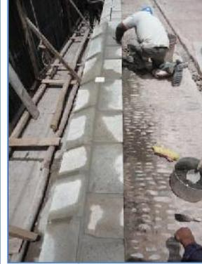
**Foto (386-387-388-389)** Vista de los trabajos de liberación de juntas para su posterior emboquillado (mortero de cal: arena mas cemento) en sobrecimientos perimetrales del atrio.
