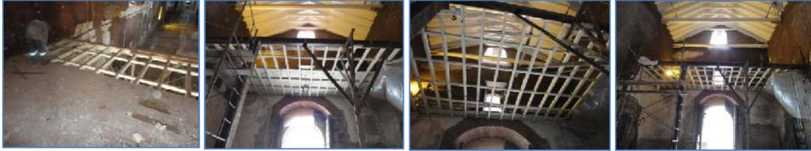
**Foto (135-136-136-137)** Vista de los trabajos de liberado de piso de madera y desmontaje de vigas de entrepiso del sotocoro, piezas dañadas (presencia de xilófagos) y debilitadas por el paso del tiempo.
