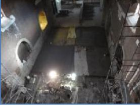
**Foto (48-49-50-51-52)** Vista de los trabajos de nivelado y apisonado manual para su posterior empedrado con piedra mediana de 6" y vaciado de falso piso (C° 140 fc/cm²) así como el curado respectivo, dichos trabajos se realizaron en pisos de la nave.
