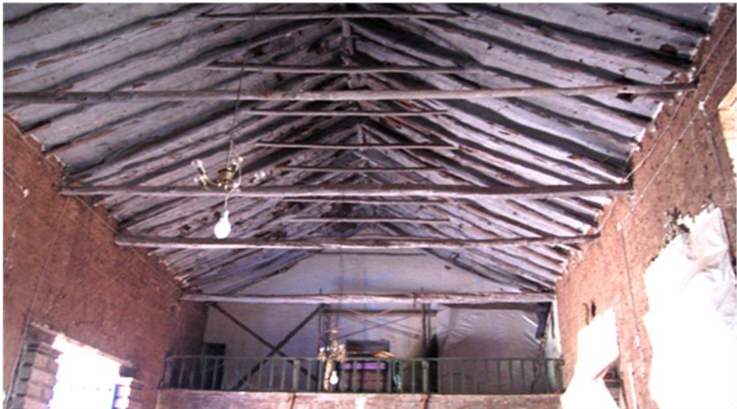
Liberación de revestimientos de barro
