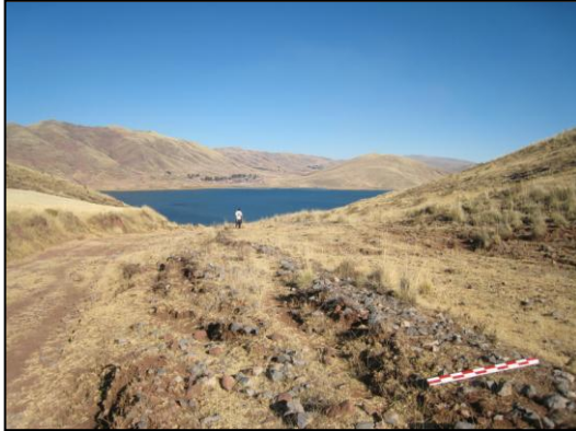
Calzada empedrada deteriorada cerca al sector de Chuqchukalla.
