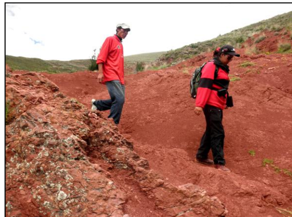
Erosión de antigua calzada debido a pronunciada pendiente topográfica y desgaste debido a precipitaciones pluviales. Sector Abra Casacunca.
