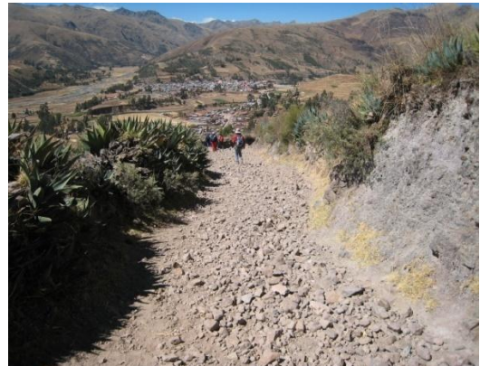
Elementos líticos diseminados sobre la calzada. Sector bajada de NingrincanCHA.
