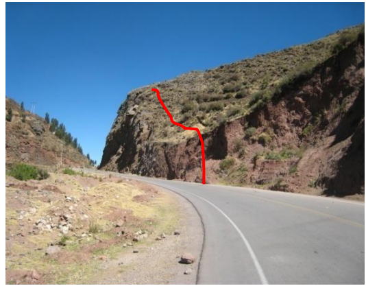
Vía asfaltada Combapata – Yanaoca, camino superpuesto, vía asfaltado sector de Pampachacra
