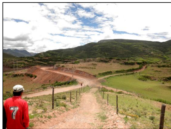
Construcción de carretera sobre el trazo del camino. Sector Cayacunca Ccasa.
