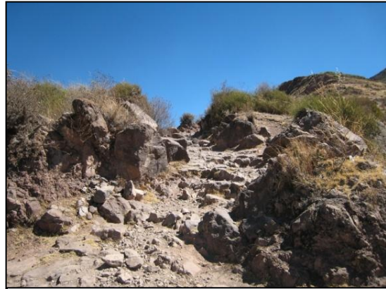
Calzada erosionada en el sector de Ningrincancho
