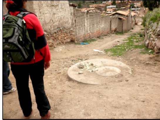
Dstrucción de antigua calzada empedrada por alcantarilla de desagüe en el centro poblado de Mosocllacta
