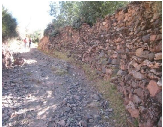
Muros de piedra laterales de aparejo simple, cercanos al poblado de Chosecani.
