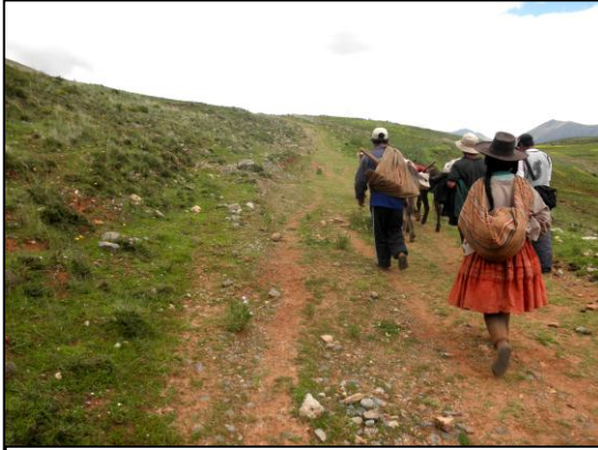
Calzada erosionada por actividad de pastoreo. Sector Llamachaqui.
