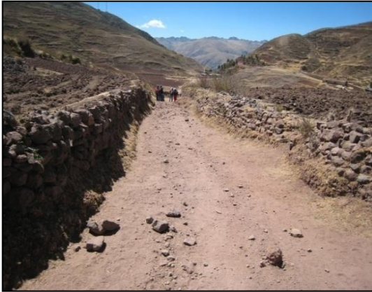
Muros laterales reutilizados en el cerco de las parcelas. Sector de Cancha Canchapata.
