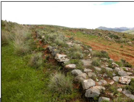
Crecimiento de maleza sobre calzada empujada. Sector Llamachaqui.
