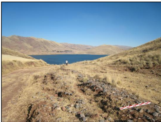
Foto N° 04: Escalinatas deterioradas en la subida de Chuqchukalla
