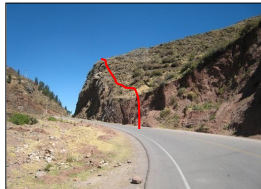
Foto N° 15: Vía asphaltada Combapata – Yanaoca, camino superpuesta vía asphaltado sector de Pampachacra
