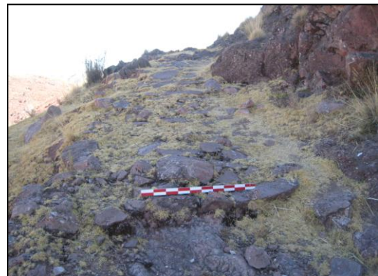
Foto N° 05: Escalinatas deterioradas en la subida de Chuqchukalla
