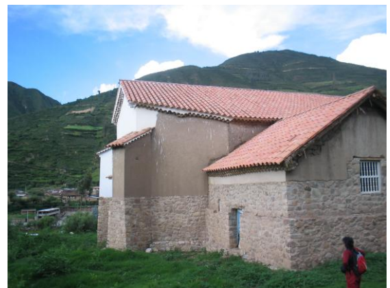
Después de intervención
