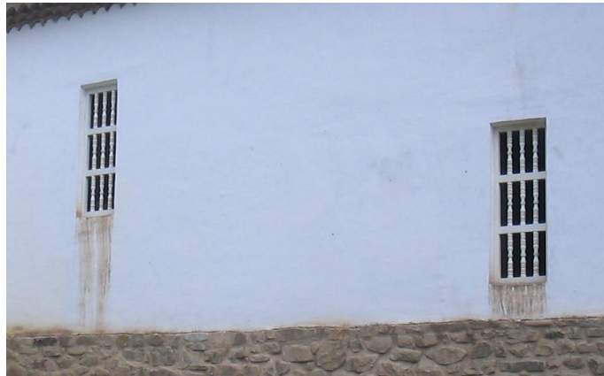
Después de intervención en marqueria de madera-vanos
