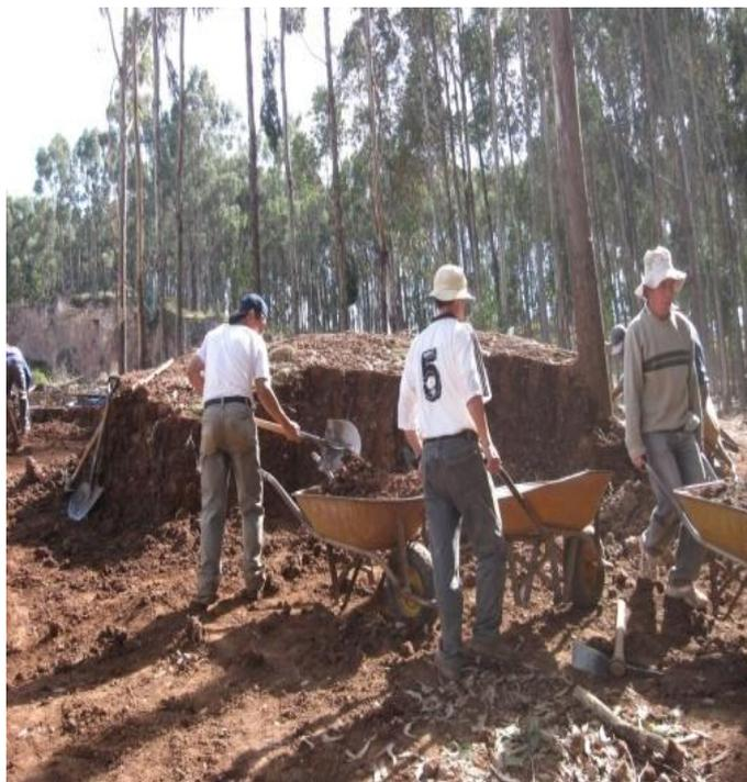
**EXCAVACION EXTENSIVA EN EL MURO DE CONTENCIÓN N° 10 DEL SUB SECTOR IV**
