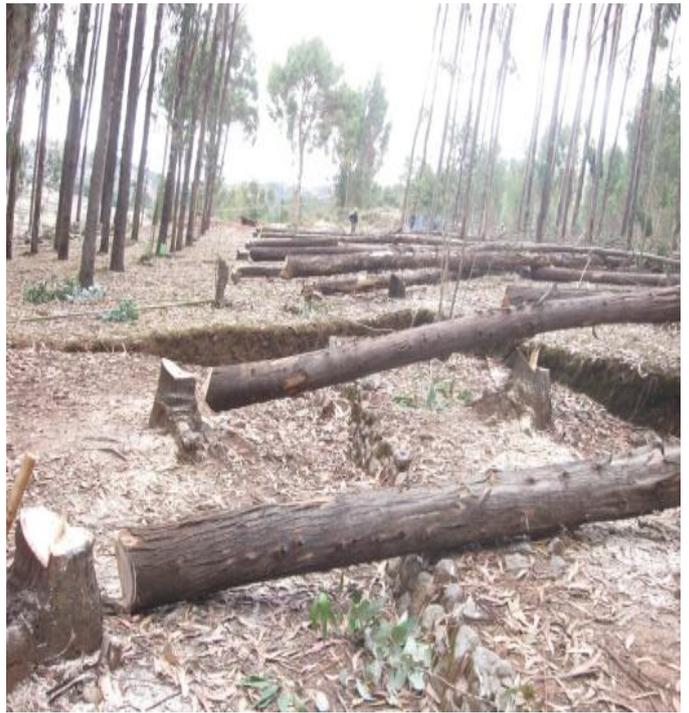
**EXTRACCION DE RAICES DEL NUCLEO DE MURO**
