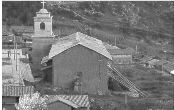
Fachada del muro Testero
