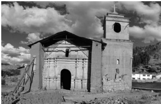
Fachada del Muro de Pies
