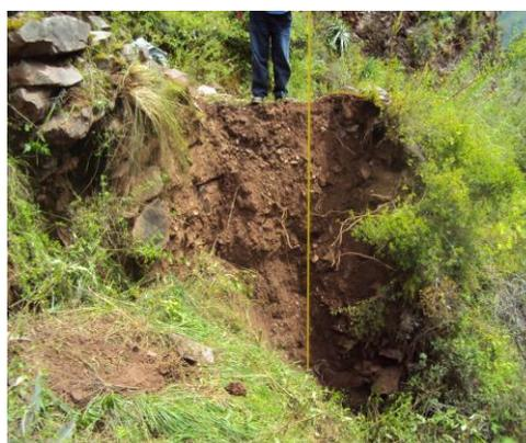
Sector de Lloquechayoq, donde se ha comprometido la plataforma del camino debido a deslizamientos
