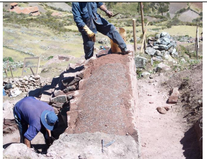
Una vez colocado el mortero se refuerza con gravilla.
