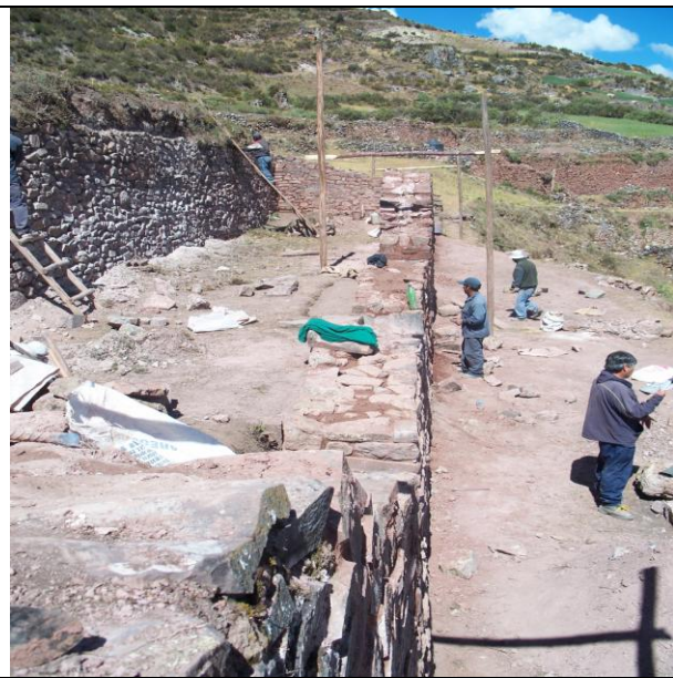
Vista panorámica de recinto en proceso de restauración y el desyerbe del muro posterior.
