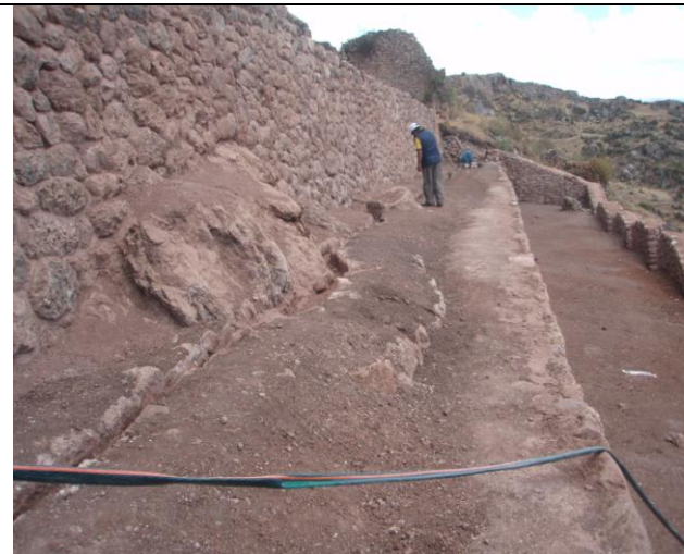
Vista del canal de drenaje conservando la topografía, la misma que esta ubicada después de cada recinto, la misma que desagua al canal del medio – gradas.
