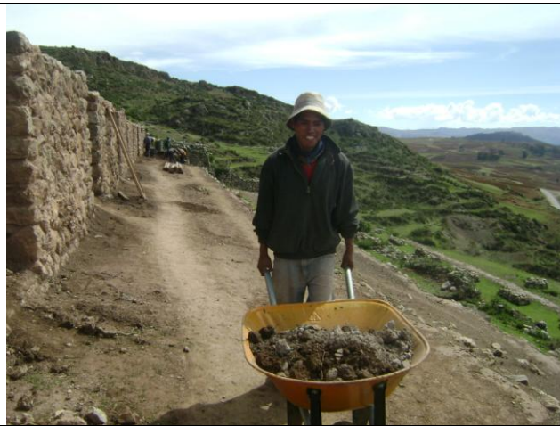
Limpieza del recinto una vez culminada la intervención.
