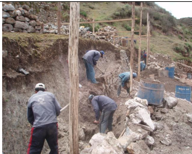
Desmontado de muro de contención No. 12, con armado de balizas y crucetas
