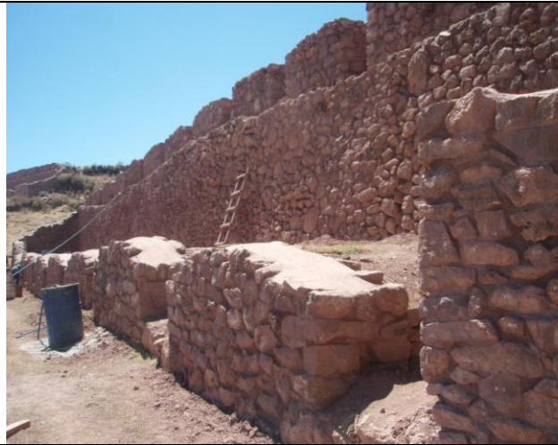
Vista del recinto 5 ya concluido.
