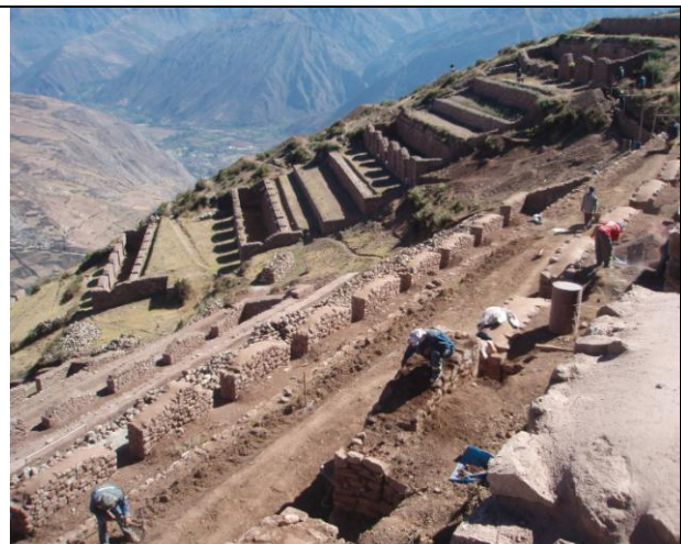
Vista panorámica de la parte alta mostrando el sector A y B, se coloca la cubertina d el parte frontal del recinto 5.
