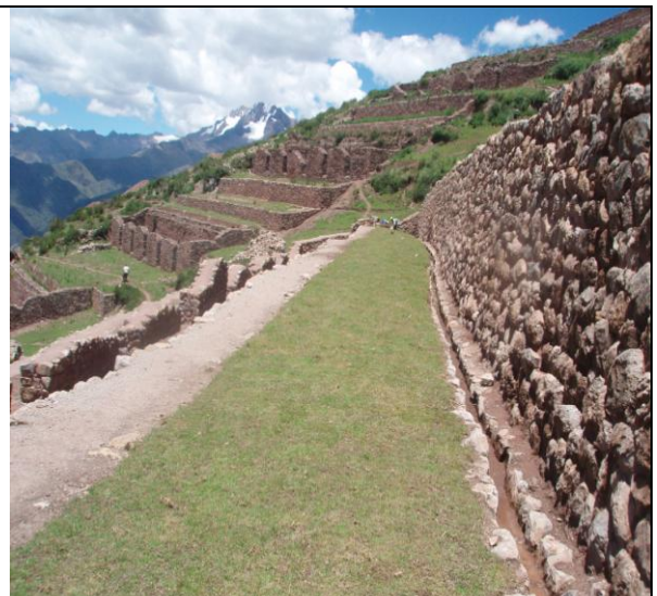
Este tratamiento de piso protege a los muros de la erosión que provocan las lluvias y el tiempo, haciendo que cumpla el canal el de drenar las aguas pluviales.
