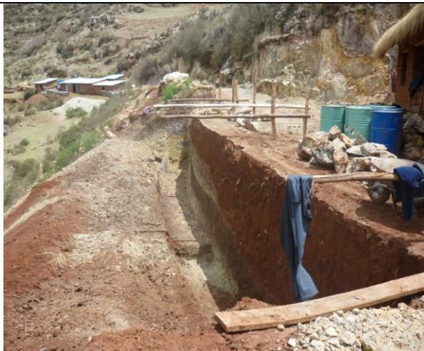
Muro de Contención en el centro de Interpretación, corte de talud
