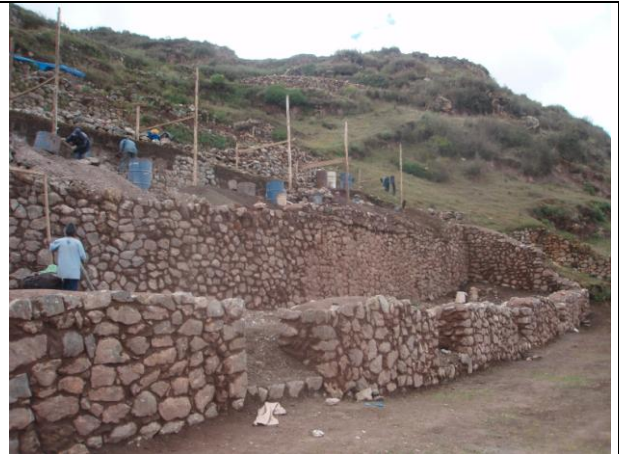
Restauración del recinto No. 7 del sector B, y personal obrero emboquillando el muro posterior
