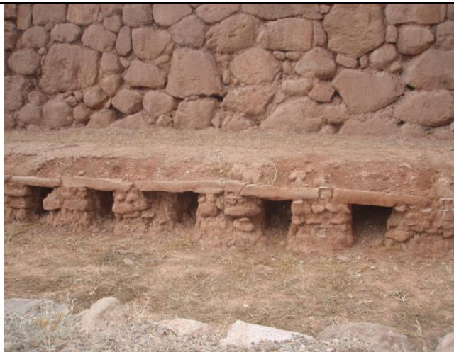
Sistema de ventilación que también existen en Machu Qolqa sin que ae haya encontrado evidencias de los Taques .
