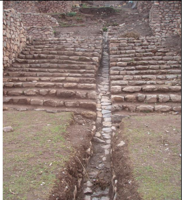
El mismo canal que tiene continuidad pasando por el muro de contención N°1 , se puede notar que ya discurrieron las aguas pluviales, el mismo que se conserva con todos sus elementos líticos.
