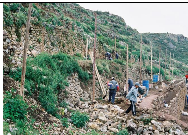
Recintos y muros de contención colapsados cubiertos de vegetación en el Sector "B"
