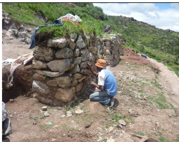
Reticulado y codificado de muro delantero del Recinto 8
