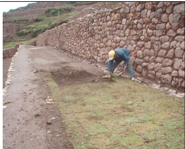
Tratamiento de piso del muro de contención No. 6
