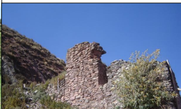
Foto N° 04.- Evidencia de ventana trapezoidal en paramentos laterales.
