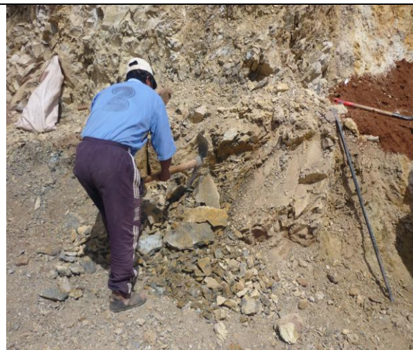
Limpieza del área de trabajo con la finalidad de facilitar el trabajo de restauración.
