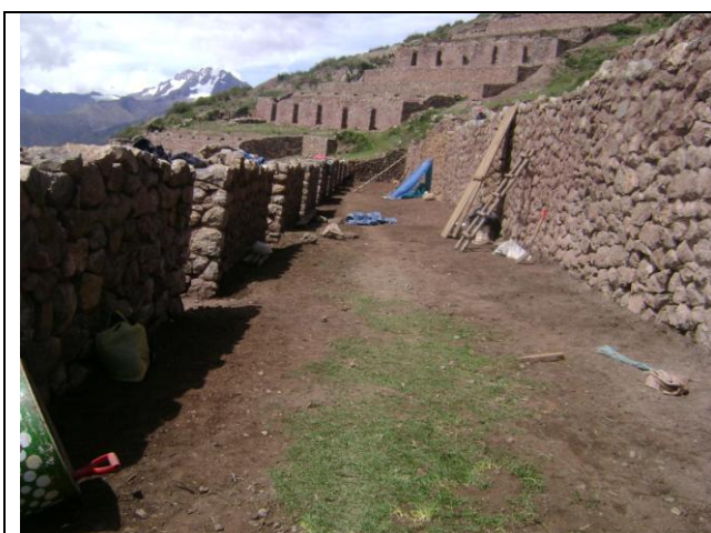
Recinto N° 2 del sector "B" una vez concluido se procede a la limpieza y emboquillado de los muros.
