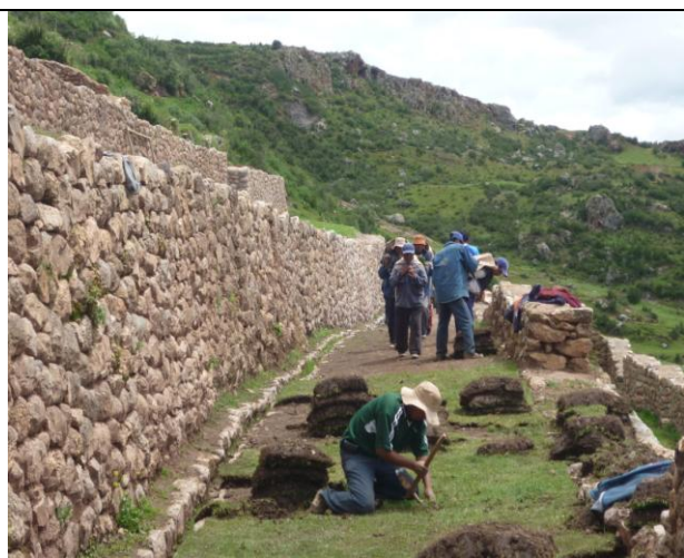
Tratamiento de piso en plataforma del sector B y traslado.
