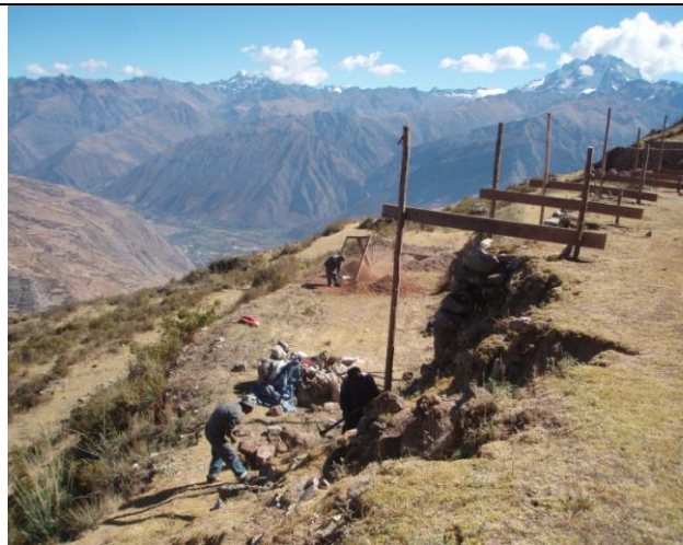
Desmontado del muro de contención N°1 una vez reticula y codificado y el armado de balizas para su intervención restaurativa.
