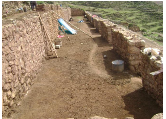
Vista del recinto N°2 del sector "B", ya concluida.
