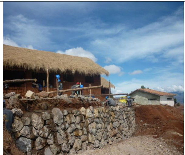
Muro de Contención , donde va estar ubicado el MIRADOR
