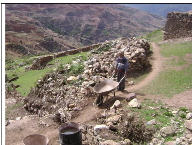
Recorrido para el traslado del material excedente en la obra.
