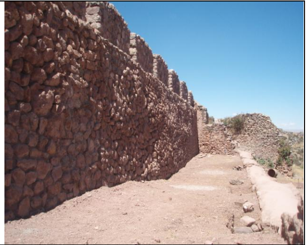
En la parte posterior del recinto se puede notar la calzadura, consolidación y recomposición con las respectivas pestañas.
