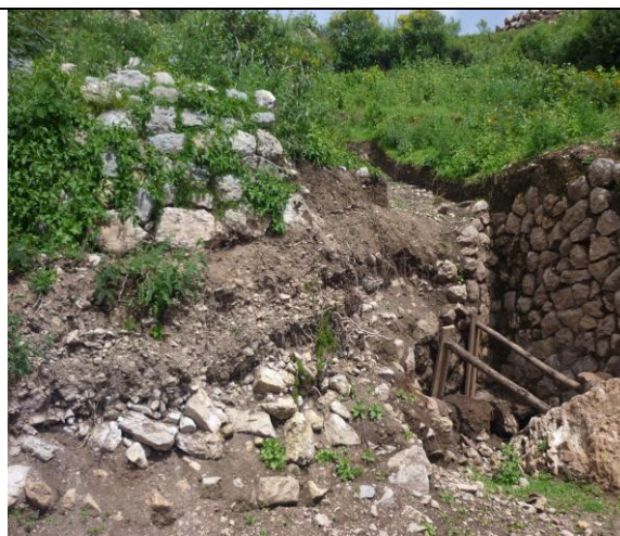
Se apuntala el muro para evitar que colapse - Recinto 8.
