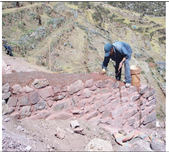
Muro lateral ya concluido se procede a colocar la cubertina respectiva.
