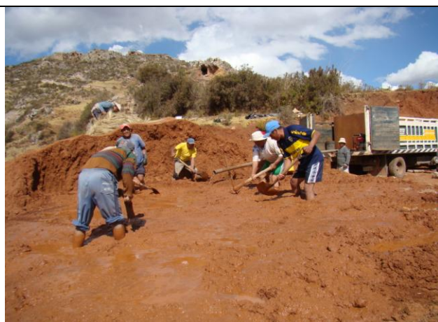
Preparado de mortero para la elaboración de adobes para la construcción de dicho ambiente.
