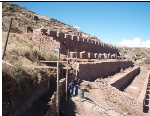
Recinto 5 del sector B siendo el mas alto de todos los recintos intervenidos, al costado izquierdo se hace recomposición de muro de contención.
