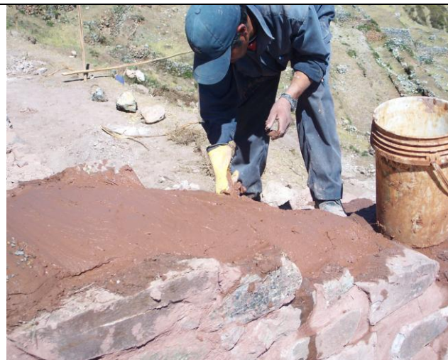
Después de la intervención colocado de cubertina.de protección de muro.
