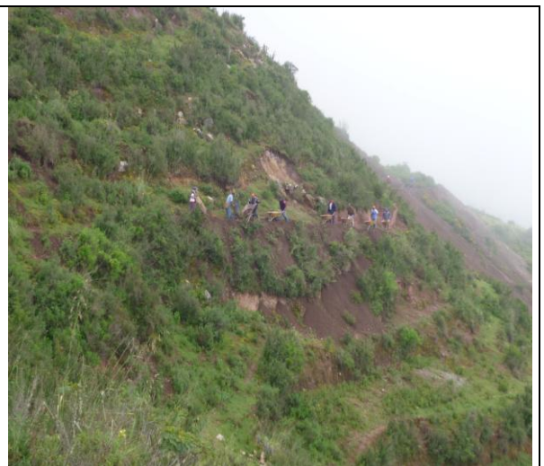
Recorrido que realiza el personal obrero para eliminar el material excedente en carretilla.
