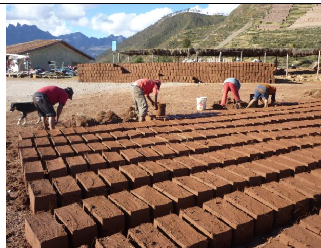
Se observa la elaboración de adobes para la construcción del Centro de Interpretación.
