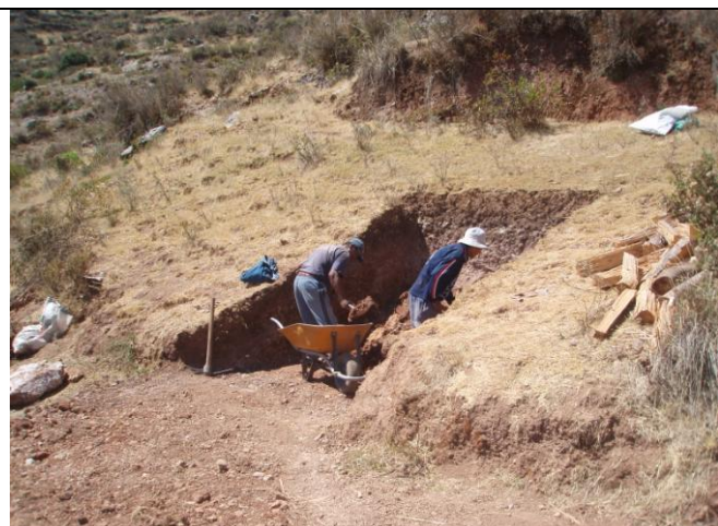
La ubicación del ambiente es al costado del campamento.
