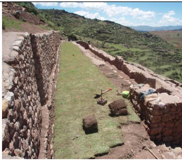
Tratamiento de piso en el muro de contención N°6 Plataforma.
