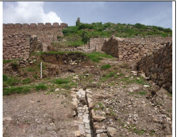
Excavación por seguimiento de la escalinata central del sector B.
