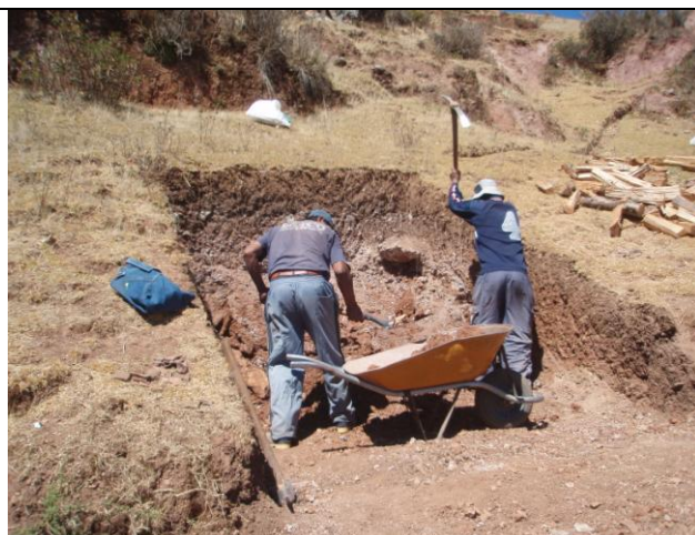
Apertura de zanjas para la construcción del ambiente para la Arqueologa de adobe con cubierta de calamina.
