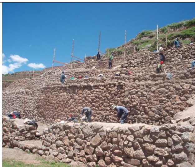
Culminación del muro de Contención N°12 y limpieza de los recintos Ns 6,7 del sector B.
