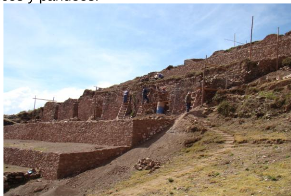
Foto N° 08.- Después de la intervención cambia el panorama de los recintos.
