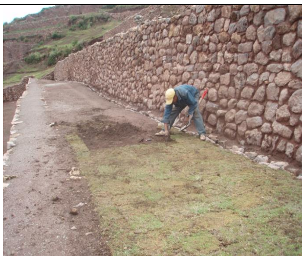
Preparado de pendiente antes de colocados de la grama.
