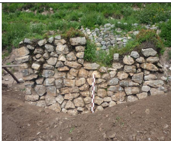
Muro saturado de raíces mostrando la separación de los elementos líticos.
