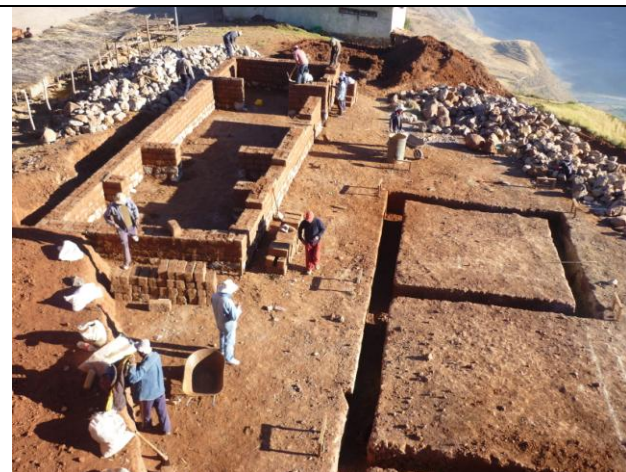
Excavación de zanjas para la cimentación y sobre cimentación
