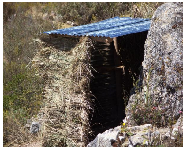
Letrina o silo para el personal obrero, así se evite el uso indebido de los matorrales del entorno.
