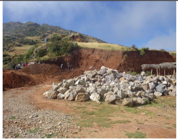
Ubicación del Centro de interpretación y los 80 m3 de piedra para ser utilizado en cimentación y sobre cimentación..
