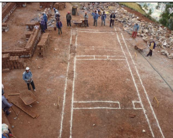
En esta vista se hace el replanteo y trazo del segundo ambiente del Centro de Interpretación.
