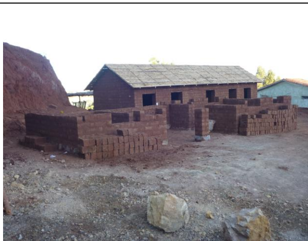
Techado del primer bloque del Centro de interpretación.
