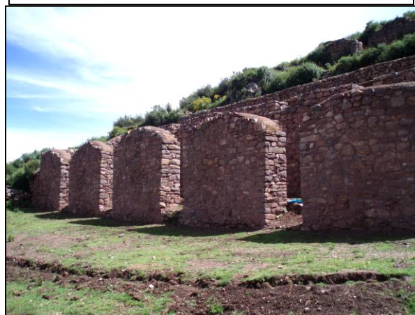
Foto N° 11.- Recintos intervenidos durante los años 2004 y 2005 por el PQÑ en el sector A
