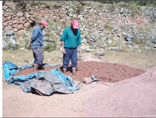
Preparado de mortero, los obreros sin uniforme ni botas para esta labor.
