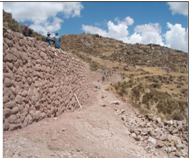
Muro de contención N° 1. Diferenciando Recomposición de Restitución, dad su magnitud y altura.
