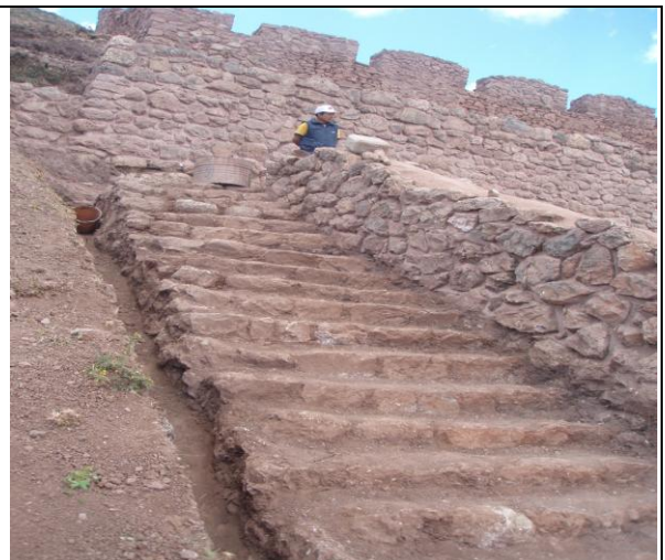
Estas gradas del sector B tienen un canal lateral la misma que esta conectada de la parte superior del recinto, estas gradas no han sido intervenidos sino tan solamente la limpieza, observándose que se encontraba en perfectas condiciones con todos sus elementos líticos.
