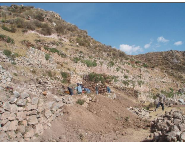
Trabajos de puesta en valor de la parte que corresponde al recinto 8 del sector "B".
