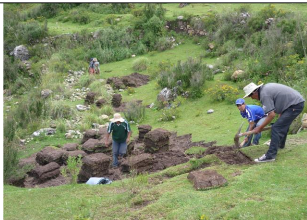
Extracción de grama para tratamiento de piso de los diferentes plataformas ya intervenidas.
