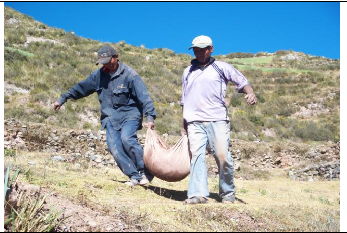
Traslado de mortero al lugar de trabajo en costalillos por dos obreros.
