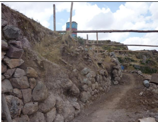
Excavación de zanjas para la cimentación y sobre cimentación
