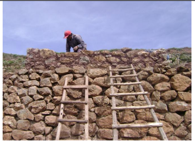
Utilización de escaleras para poder culminar el recinto, por la altura que es considerable.
