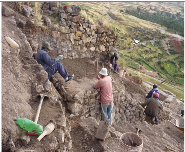
Desmontado de muro Reticulado y Codificado.
