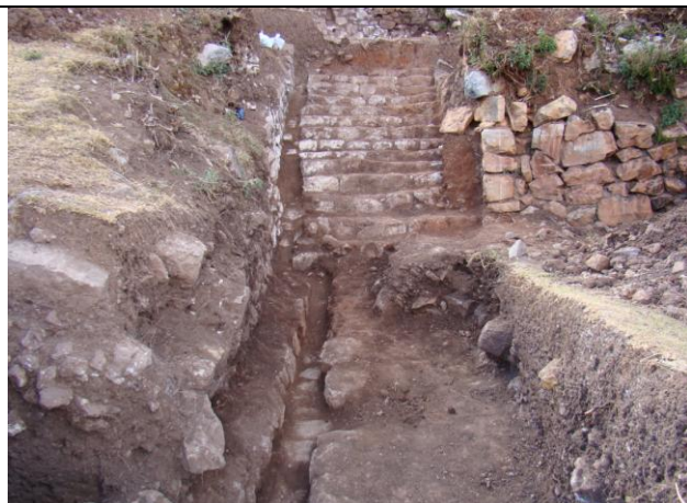
Vista de las escaleras que se encontraban soterradas.
