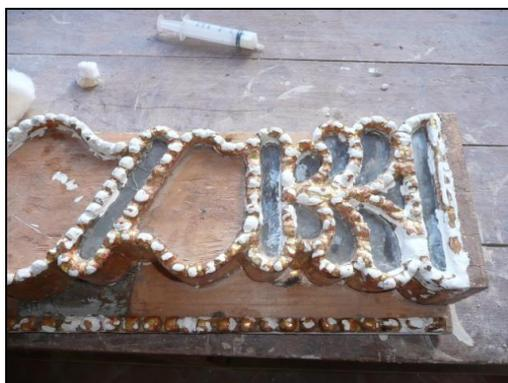
Fig. 5 Entizado de pilastra. Ambiente 204.
