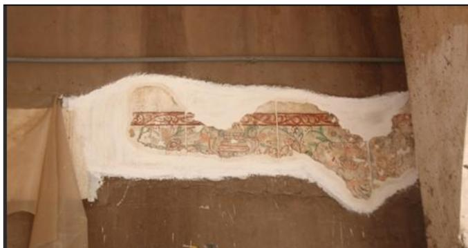
CONSOLIDACION PUNTUAL, REPELLADO, Y ENLUCIDO DEL AMBIENTE 120 – MURO “C”
