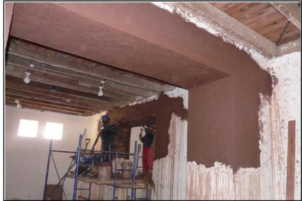
Embarre realizados en los muros y en los dinteles de los vanos 1,2,3 y 4 del primer nivel y en los vanos 7,8 y 9 del segundo nivel
