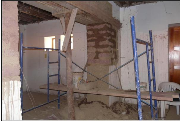
Calzadura de muros en los vanos 7,8 y 9 del segundo nivel. Se utilizo adobes de 0.60x0.15x0.30m
