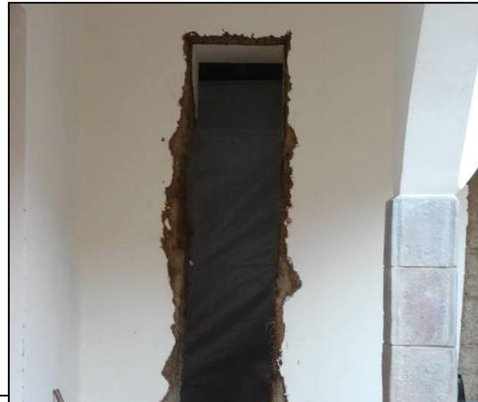
Vista del proceso de apertura de vano realizado en la sala 07, se aprovecho la ventana existente.
