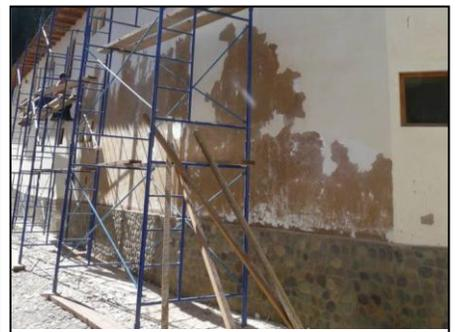
Vista de los trabajos de lijado y resanado de muros de la fachada exterior previo a la pintura. Estas partidas serán valorizadas hasta que se realice el pintado del muro.
