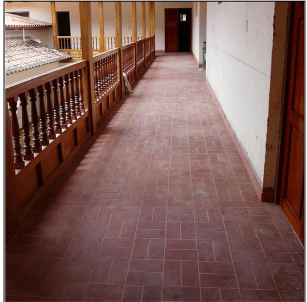
Colocación de piso cerámico tipo tableta colonial en las gradas y en el corredor del segundo nivel (lado norte y oeste).
