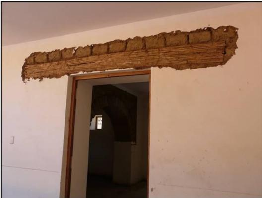
Vista de los trabajos de remoción de embarre en aquellas áreas donde se encontraba abombado o en mal estado. Parte superior de los vanos.
