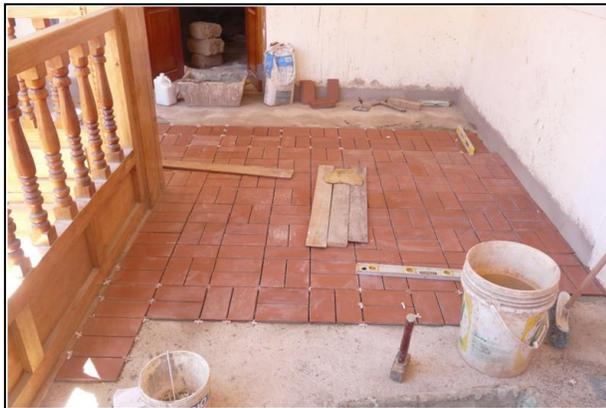
Colocación de piso cerámico tipo tableta colonial en el corredor del segundo nivel (lado este y norte)
