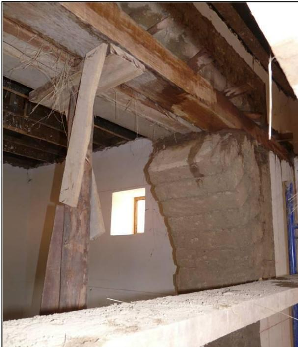
Colocación de dintel, se colocaron 3 piezas de madera en cada arco del segundo nivel 2 de 8"x6"x4.50m ubicados en los extremos y 01 pieza de rollizo desbastado de 6" colocado en medio del vano. Luego se procedió al apuntalamiento del dintel para proceder con el retiro de las dovelas del arco y posteriormente la calzadura de muros desde el arranque del arco hasta la parte superior del dintel.
