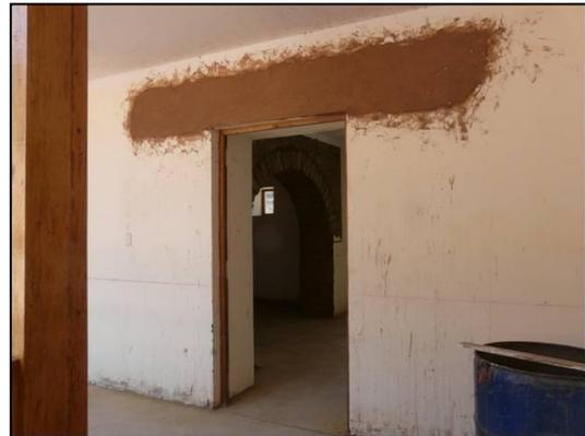
Vista de los trabajos de restitución de embarre en las zonas donde este se encontraba dañado. Vista de la parte superior del vano de acceso a la sala 09.
