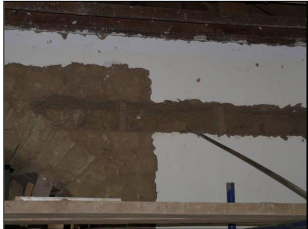
Apertura de cala para la colocación del dintel. Profundidad 45 cm por un lado y 20 cm por la otra cara, en el segundo nivel.
