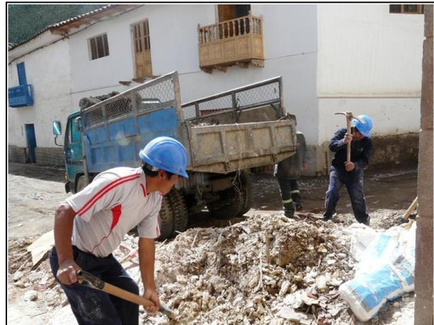
Vista de los trabajos de embarre en derrame de puerta del taller de conservación (sala 07). Vista de los trabajos de eliminación de desmonte en volquete facilitado por la municipalidad de Paucartambo.
