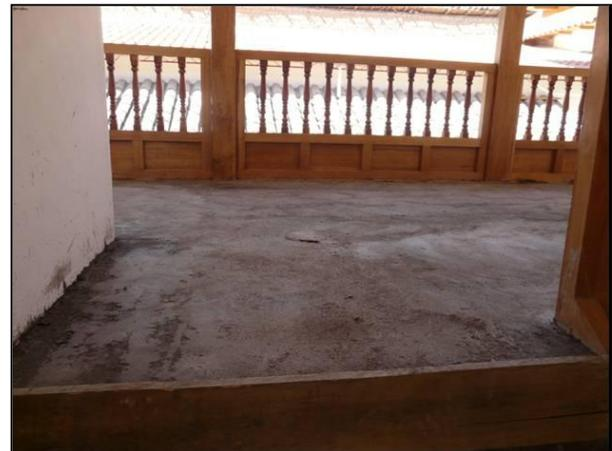
Vista de los trabajos de vaciado de contrapiso efectuados en el segundo nivel tanto en las salas de exhibición como en el corredor del segundo nivel. Previo a este trabajo se ha realizado el nivelado colocando guías o maestras.
