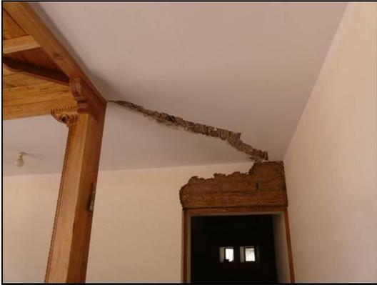
Vista de los trabajos de resane realizados en el cielorraso del corredor del segundo nivel. Primeramente se retiro las partes dañadas y luego se volvió a enlucir con yeso.
