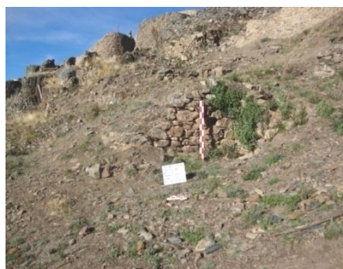
Vista del recinto antes de intervenir
