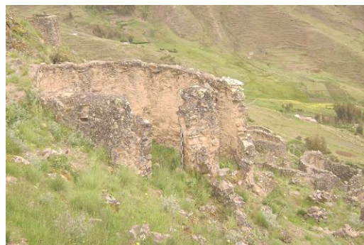
Detalle del estado actual en que se encuentra el recinto N°
