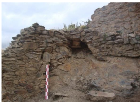
Vista del estado actual del paramento interior
