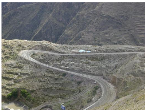
Vista de corte de carretera en la Z.A. de Ankasmarka, dividido en tres secciones
