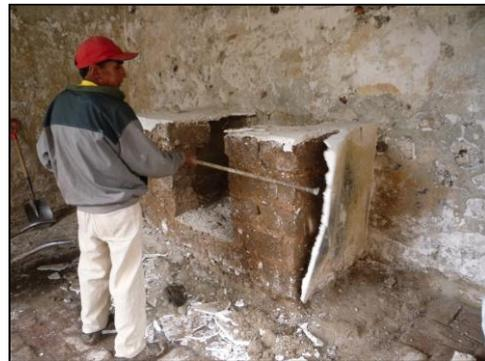
Se apertura zanjas de 2.20 mts de profundidad, para su restitución y calzadura de cimientos Amb, N°104 (Capilla Procesional)
