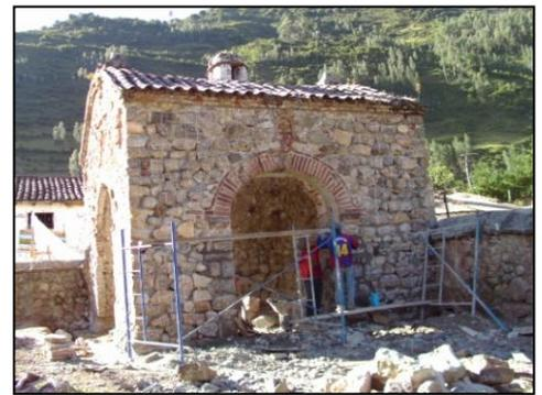
En el Amb. 104 (Capilla poza) se procedió al empedrado de este para luego vaciar el piso con C°S° Fc=175 Kg/cm2 E=0.05 m, sobre empedrado de E=0.15m.. así mismo se libera el mortero de las juntas de los muros.
