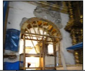
En el Muro de la Epístola exterior, se realiza trabajos de exploración e interpretación de muros de piedra, se viene realizando la liberación de emboquillados y la liberación de muros de piedra en los sectores donde se colocara las montantes para la evacuación de aguas pluviales.
