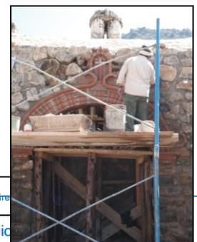
En el Amb. 104 (Capilla poza) se ejecuta las partidas de caladura y recomposición de los elementos ornamentales de ladrillo pastelero en base a las evidencias existentes. Se elimina el material excedente producto de estos trabajos.
