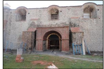
Los vanos de la nave tendrán ladrillo pastelero con un alero de 0.125 mtrs, ver detalle en planos, se realizarán calzaduras en muros por ambos lados, así como se intervendrá en cimientos y sobrecimientos, otra de las acciones serán las restituciones tal como se indica en hojas de metrados.
