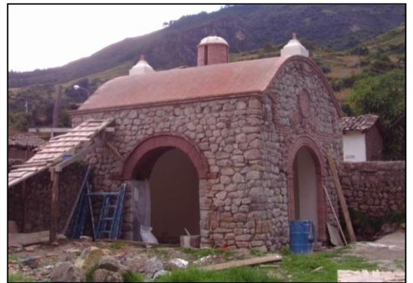
En el Amb. 105 (Capilla poza) se tienen una foto antes de la intervención y la otra después de la intervención, donde se puede notar que se recuperado todos sus elementos arquitectónicos como son las portadas de ladrillo pastelero de los dos accesos, la cubierta de bóveda de cañon corrido, la linterna que corona esta cubierta, en la parte inferior se tiene la evidencia del piso original de ladrillo pastelero de este ambiente.
