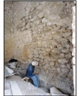
En el Amb. 101 (Capilla poza) se viene realizando las partidas con la caladura y recomposición de los elementos ornamentales de ladrillo pastelero en el muro Este, se libera el emboquillado de los muros de piedra y se procederá con la consolidación y calzadura de muros de piedra..
