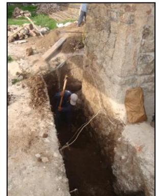
En los Amb. 101y 104 (Capilla poza), se continua con los trabajos de, apertura de zanjas para la Calzadura de cimientos, restitución de cimientos, consolidación de cimientos, para lo cual se utiliza piedra caliza, mortero cal hormigón cemento.
