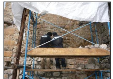
Se continua con los trabajos de calzadura, consolidación y Restitucion de Muros de piedra para lo cual se realiza primero la codificación de las unidades petreas, para luego intervenirlos, se utiliza mortero cal:hormigón, Cemento.
