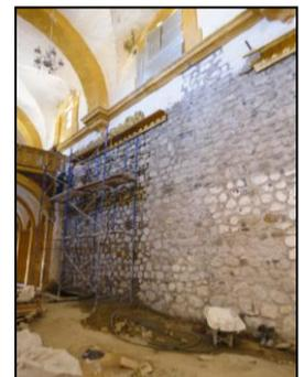
En la nave de la Iglesia en el muro del Evangelio se viene realizando las partidas de calas de exploracion en los muros de piedra, para luego proceder con la caladura y consolidación de los muros de piedra, se libera el recubrimiento de pintura látex de los muros de piedra.
