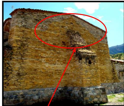
Se aprecia en la parte externa del muro testero, inclusive con piedra de color ocre amarillo notándose la base original del muro testero y altura de los muros portantes del primer templo.
