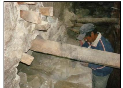
En el muro Testero se realiza trabajos de Calzadura, consolidación de muros de piedra, para lo cual se utiliza mortero Cal: Hormigón: cemento, en el interior de este muro hacia el sector del presbiterio presenta un arco de piedra y ladrillo pastelero por lo que se procedió a realizar el cerchado para luego realizar los trabajos de calzadura.
