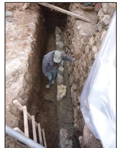
En los Amb. 101y 104 (Capilla poza), se continua con los trabajos de, apertura de zanjas para la Calzadura de cimientos, restitución de cimientos, consolidación de cimientos, para lo cual se utiliza piedra caliza, mortero cal hormigón cemento.
