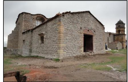
El presente año se ejecutó las partidas de calzaduras, consolidación, restitución de muros, así mismo se cambió los dinteles de los vanos de iluminación por encontrarse en mal estado de conservación, en los accesos se mantuvo los dinteles originales haciéndoles tratamientos con materiales químicos para evitar el deterioro por agentes biológicos.
