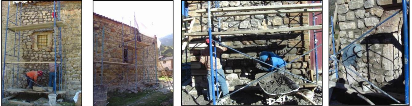
Se continua con la liberación de Emboquillados en los muros de piedra para luego proceder con el codificado de los paramentos del muro antes de realizar los trabajos de Calzadura, consolidación i/o restitución de elementos petreos del muro de piedra, este trabajo estas partidas se realizan previo a una exploración de los muros para poder determinar cual de las partidas se ejecutara..
