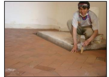
Amb. 105 (Capilla poza), se prosedio con la restitución de pisos originales de ladrillo pastelero asentados en palmera, se utilizo mortero CHormigon:cemento.
