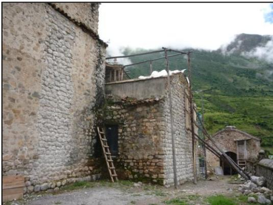
En el ambiente 110 (Sacristía), se continua con los trabajos de calzadura de muros de piedra con mortero Cal : Hormigón : Cemento, para lo cual se procede a liberar el emboquillado de las juntas y posteriormente se retícula y codifica el tramo a intervenir. Reemplazando las piezas que se encuentran en mal estado de conservación.
