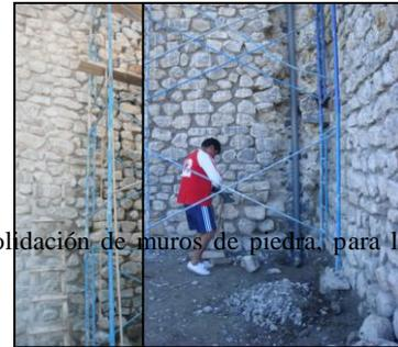
En el Ambiente 112 (Penitenciaria) se realiza trabajos de calzadura y consolidación de muros de piedra, para lo cual se utiliza mortero Cal: Hormigón: cemento.
