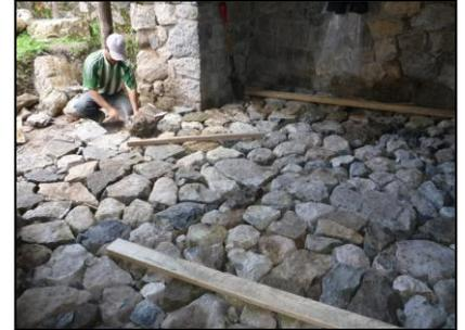
En el Amb. 112 (Penitenciaria) se procedió al empedrado de este para luego vaciar el piso con C°S° Fc=175 Kg/cm2 E=0.05 m, sobre empedrado de E=0.15m.
