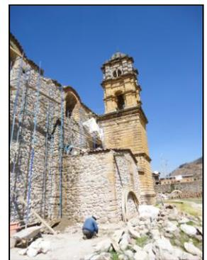
En el Muro del Evangelio exterior, se realiza trabajos de exploración e interpretación de muros de piedra, se viene realizando la liberación de emboquillados y la liberación de muros de piedra en los sectores donde se colocara las montantes para la evacuación de aguas pluviales. Así mismo se está calzando el muro de piedra a la altura del coro.
