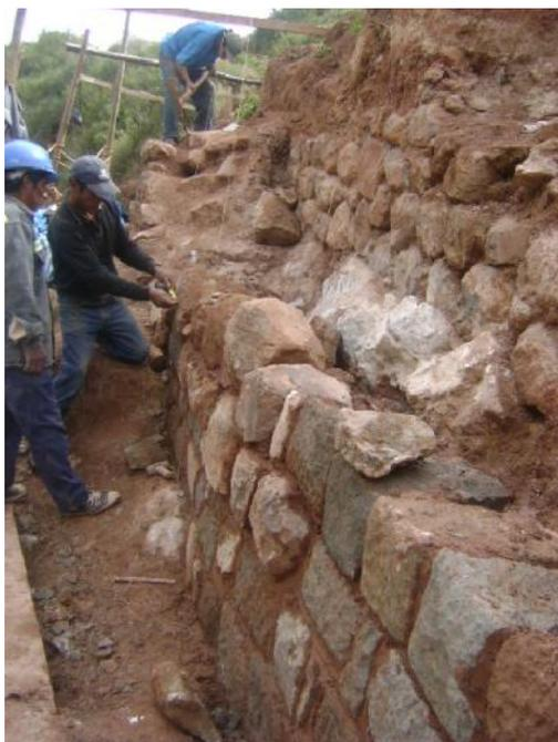
CALZADURA DE CIMENTOS (CON MORTERO DE ARCILLA- CAL)
