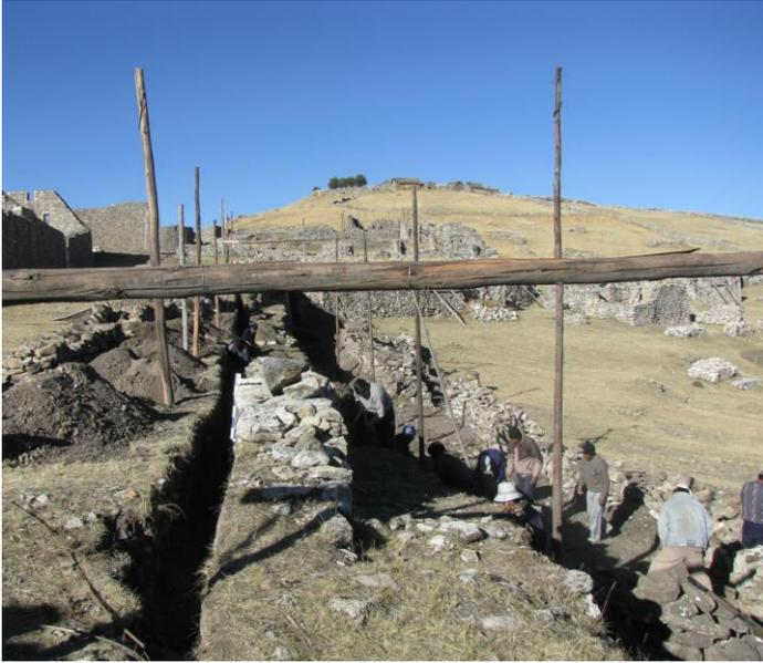
SE OBSERVA EL ARMADO DE BALIZAS Y CRUCETAS DE ROLLIZOS.
