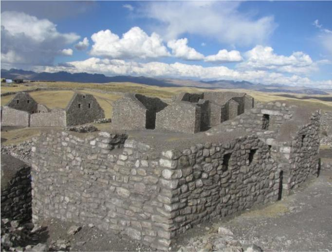
SE OBSERVA CUBERTINA DE PROTECCION EN LA CABECERA DE MURO CON MORTERO PREPARADO SECTOR TINKUQ.
