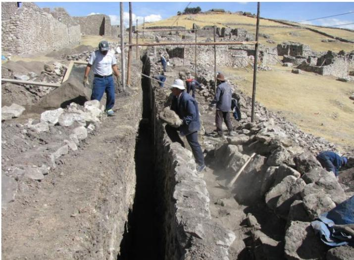
SE APRECIA EL PROCESO DE DESARMADO DE MURO RETICULADO PARA SU INTERVENCION
