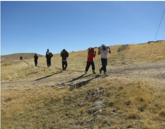
SE OBSEVA EL TRASLADO DE MATERIAL DE TIERRA SARANDEADO PARA EL PREPARADO DE MORTERO
