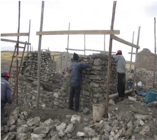
SE OBSERVA EL EMBOQUILLADO DE MURO CON MORTERO PREPARADO EN SECTOR TUPAQ
