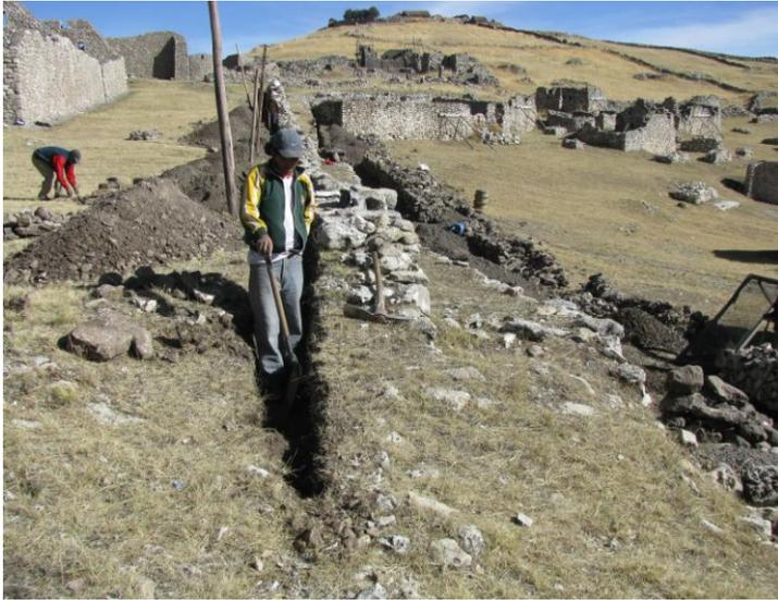
SE OBSERVA LA APERTURA DE EXCAVACION EXTENSIVA AMBOS LADOS DEL MURO ANTES DE SU INTERVENCION.
