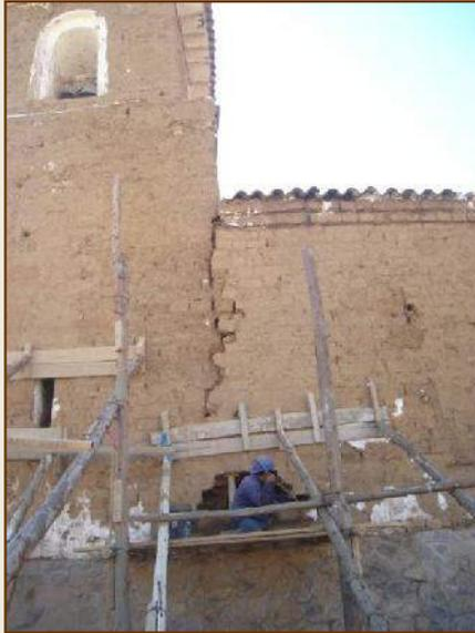
ARMADO DE ANDAMIAJE DE MADERA Y APUNTALAMIENTO DE MURO PARA INTERVENCION EN LA CALZADURA DE MURO DE ADOBE
