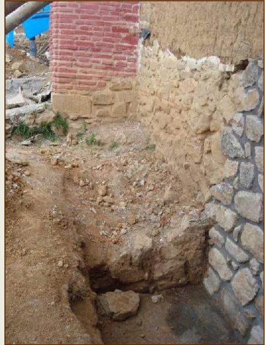
*FOTOS QUE NOS MUESTRAN LA LABOR DE CALZADURA YA CONCLUIDA EN EL LADO DEL EVANGELIO (COSTADO DE CONTRAFUERTE MEDIO), DONDE SE ENCONTRO COMO SE PUEDE APRECIAR EN LA FOTO SUPERIOR DERECHA VESTIGIO DE CIMENTACION . ABAJO , EXCAVACION QUE EVIDENCIA LA DIFERENCIA DE PROFUNDIDA DE CIMENTACION CONRESPECTO AL LADO DE CABECERA (1.75CM POR DEBAJO DEL TERRENO ACTUAL)*
