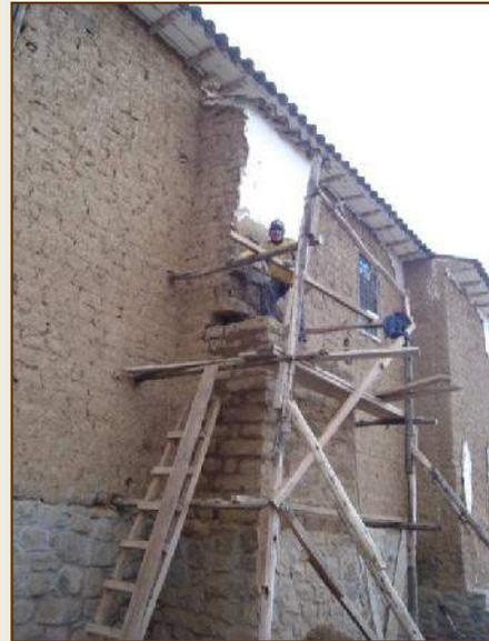
ARMADO DE ANDAMIAJE DE MADERA PARA INTERVENCION EN LA CALZADURA DE MURO DE ABOBE
