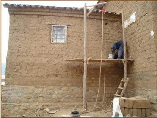
ARMADO DE ANDAMIAJE DE MADERA PARA LA REALIZACION DE CALZADURAS DE MURO
