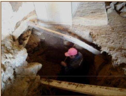
EXCAVACION DE ZANJAS Y LIBERACION DE SOBRECIMIENTO PARA REALIZAR LAS CALZADURAS
