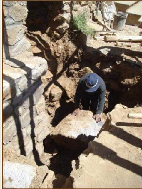
EXCAVACION DE ZANJAS Y LIBERACION DE SOBRECIMIENTO PARA REALIZAR LAS CALZADURAS
