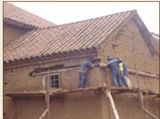
COLOCACION DE LLAVES POR LA PARTE FRONTAL Y LATERAL INFERIOR DEL MURO
