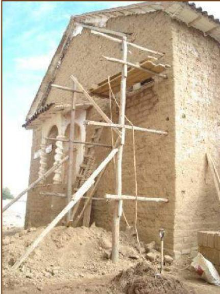
ARMADO DE ANDAMIAJE DE MADERA PARA INTERVENCION EN LA CALZADURA DE MURO DE ABOBE
