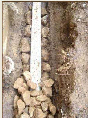
COLOCACION DE TUBERIAS Y RELLENO CON PIEDRA CASCADA DE 1/4 Y POSTERIORMENTE CON 1/2
