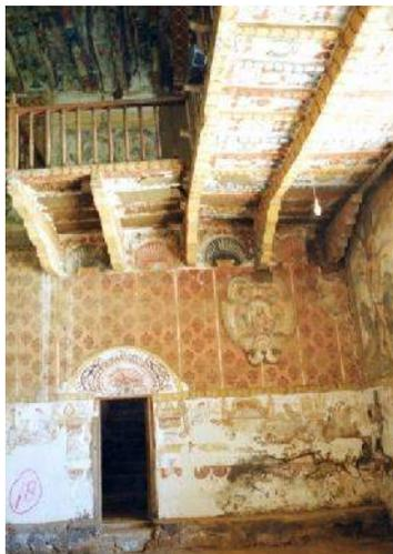
*Vistas del acceso a la caja de escaleras, se muestra modificación del vano. Se puede apreciar la forma del coro alto, y el sistema de entrepiso con vigas - tirante encajonadas y el tipo de soporte mediante ménsulas.*
