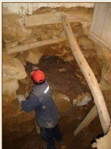
CALZADURAS DE CIMIENTOS Y SOBRECIMIENTO : CON PIEDRA CICLOPEO Y MORTERO DE HORMIGON – CAL – CEMENTO
