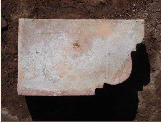
UNIDAD DE LADRILLO MODURADO QUE FUE LINERADO DE LA PORTADA, HEMOS ENCONTRADO 7 TIPOS DE UNIDADES DIFERENCIADAS, ALGUNAS DE LAS CUALES SE DEBERAN RESTITUIR POR SU EVIDENTE DETERIORO
