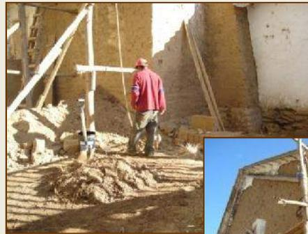
PREPARACION DE MORTERO DE BARRO - TRASLADO VERTICAL DE MATERIAL A OBRA
