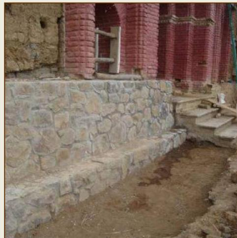
EMBOQUILLADO DE CALZADURAS CEMENTO – CAL – ARENA . RELLENO Y COMPACTADO CON MATERIAQL PROPIO.
