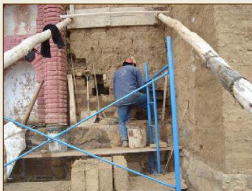
COLOCACION DE CUÑAS DE MADERA ROLLIZOPARA ASEGURAR LA ESTABILIDAD DE MURO
