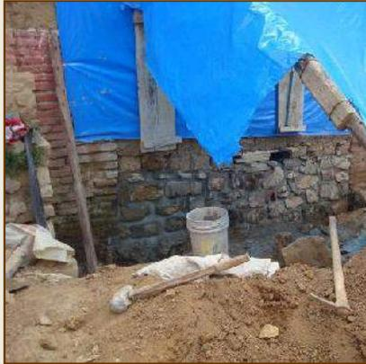
**LABORES DE CALZADURA, RECOMPOSICION Y EMBOQUILLADOS YA CONCLUIDAS**
