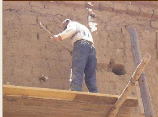
PERFORACION DEL MURO EXTERIOR PARA LA COLOCACION DE LA LLAVE
