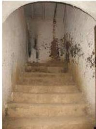
Espacio funcional recompuesto íntegramente para resolver la accesibilidad al Coro Alto y a la Torre, sus pisos y peldaños trabajados en tierra, no tienen consistencia y muestran desprendimientos.
