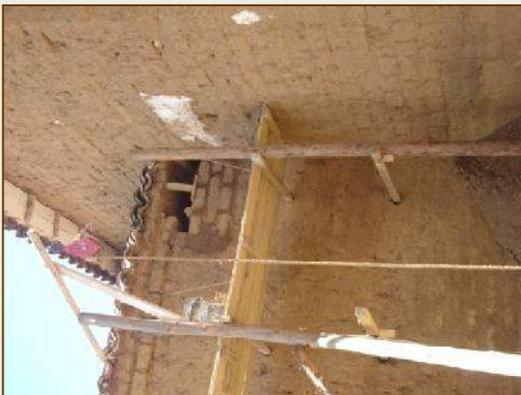
COLOCACION DE CUÑAS DE MADERA ROLLIZOS PARA ASEGURAR LA ESTABILIDAD DE MURO
