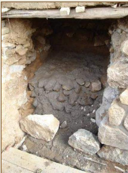
CALZADURAS DE CIMIENTO Y SOBRECIMIENTO : CON PIEDRA CICLOPEO Y MORTERO DE HORMIGON – CAL – CEMENTO
