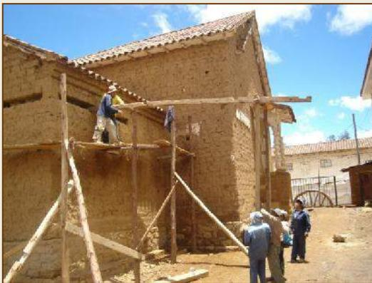
COLOCACION DE LLAVES POR LA PARTE LATERAL POSTERIOR DEL MURO
