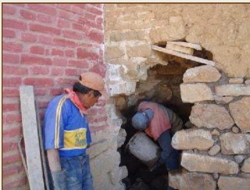
CALZADURAS DE CIMIENTO : CON PREVIA EXCAVACION SE HACE LA COLOCACION DEL MORTERO DE HORMIGON – CAL
