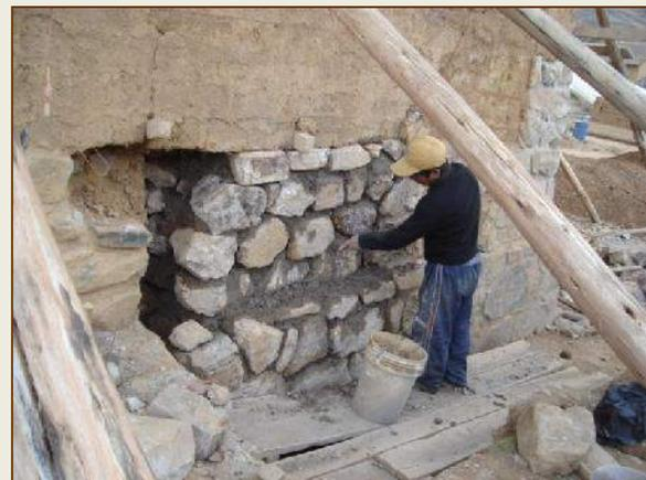
LIMPIEZA DE CALZADURAS PARA LA REALIZACION DE EMBOQUILLADO: MORTERO ARENA – CAL – CEMENTO
