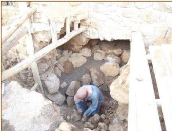
CALZADURAS DE CIMIENTOS Y SOBRECIMIENTO : CON PIEDRA CICLOPEO Y MORTERO DE HORMIGON – CAL – CEMENTO
