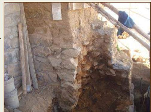
EXCAVACION DE CIMENTOS, PARA REALIZAR LAS CALZADURAS
