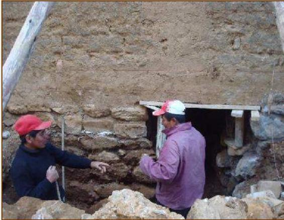
*LABORES DE RECOMPOSICION DE SOBRECIMIENTOS EN EL SECTOR DEL MURO TESTERO, APERURANDO UNA CAL DE 0.95 DE ANCHO QUE INGRESA EN LA SECCION DE MURO EN 1.20M, SOBREPASANDO EL ELE DEL NUCLEO.*
