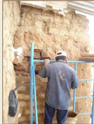
ARMADO DE ANDAMIAJE METALICOS PARA LA REALIZACION DE CALZADURAS DE MURO
