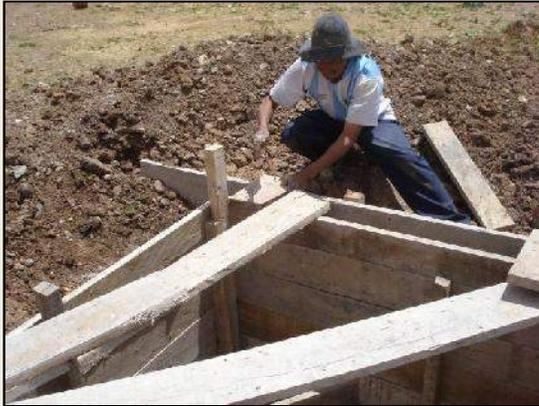
ENCOFRADO PARA POZA DE CAL, UBICADA SOBRE LA PISCINA DE CONCRETO.
