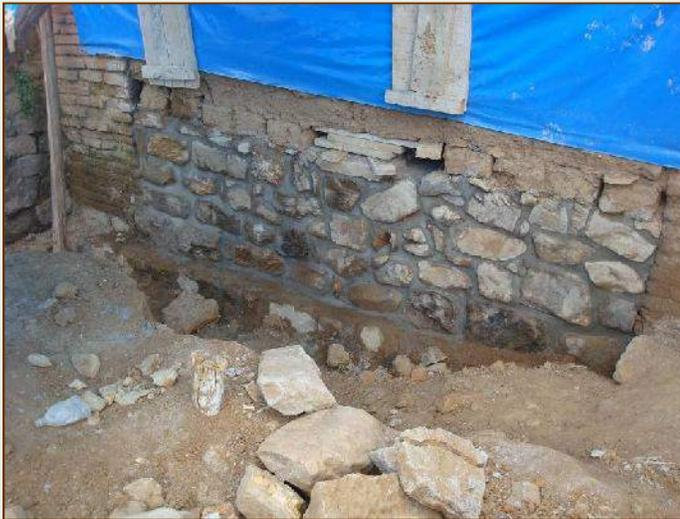
*DETALLE DE CALZADURA REALIZADA EN EL LADO DEL EVANGELIO (POR DEBAJO DE PORTADA TAPIADA ENCONTRADA EN LOS PROCESOS DE LIBERACION DE EMBARRE), ASI MISMO SE PUEDE APRECIAR EL DE TALLE DE RESTITUCION DE ZARPA DE SECCION TRAPEZOIDAL, QUE PRESENTA 20 CM DE DESFASE CON RESPECTO AL ALINEAMIENTO VERTICAL DEL MURO Y 30 CM SOBRE LA BASE DEL MISMO*
