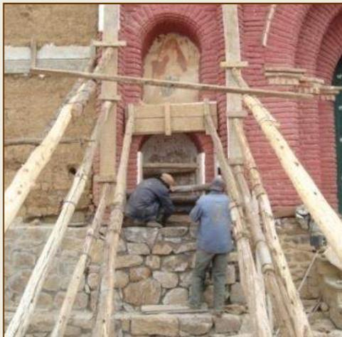
CALZADURAS DE CIMIENTOS Y SOBRECIMIENTO : CON PIEDRA CICLOPEO Y MORTERO DE HORMIGON – CAL – CEMENTO
