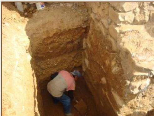
EXCAVACION DE ZANJAS PARA LA REALIZACION DE CALZADURAS DE CIMENTO
