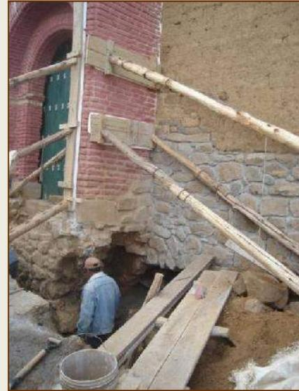
EXCAVACION DE ZANJAS Y LIBERACION DE SOBRECIMIENTO PARA REALIZAR LAS CALZADURAS
