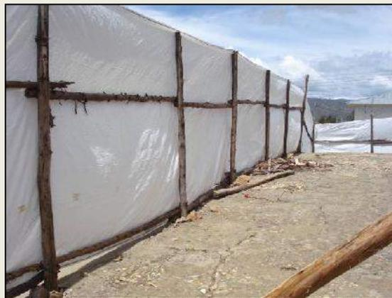
PARA ESTE MES SE CONLUYO EL COLOCADO DEL CERCO PROVISIONAL DE 2.80M DE ALTURA, EL ESPACIAMIENTO DE PUNTALES ES DE 2.5M APROX Y EL CERRAMIENTO CON ARPILLERA EN AQUELLOS TRAMOS DONDE NO EXISTIA PRESENCIA DE MURO CON MATERIAL NOBLE.
