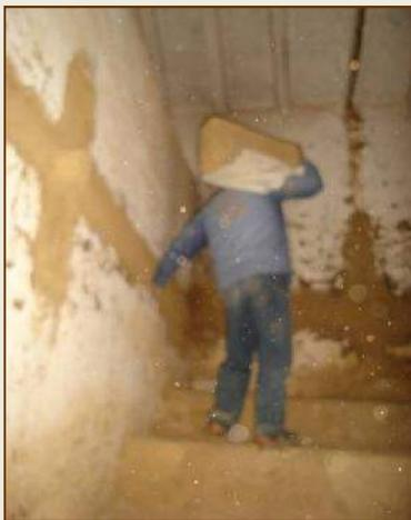
CALZADURAS DE CIMIENTOS : CON PIEDRA CICLOPEO Y MORTERO DE HORMIGON – CAL – CEMENTO
