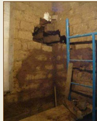
LIMPIEZA DE CALZADURAS Y DE EMBOQUILLADO : MORTERO ARENA – CAL – CEMENTO
