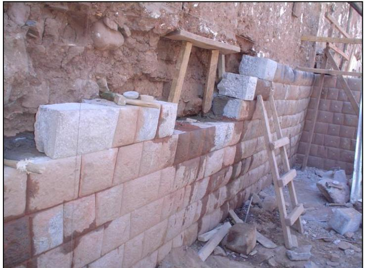
DESARMADO DEL MURO, PARA POSTERIORMENTE REALIZAR EL TRABAJO DE RECOMPOSICION DE ESTRUCTURAS DE MURO INKA, OBSERSE MURO ORIGINAL INKA CON SU ARRANQUE
