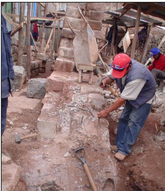
DEMOLICION DE ESTRUCTURAS DE CONCRETO, CIMIENTOS DE CONCRETO EN LA FACHADA DEL SECTOR III.
