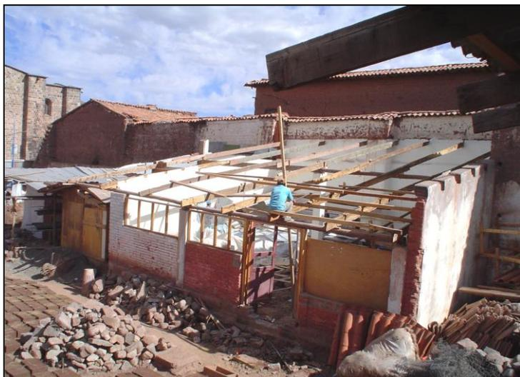
DESSARMADO DE LA CUBIERTA Y PARTE DEL ENTABLADO DEL AMBIENTE QUE CORRSPONDE AL ARCHIVO DEL INC. ESTO ESTA UBICADO DENTRO DEL SECTOR III.
