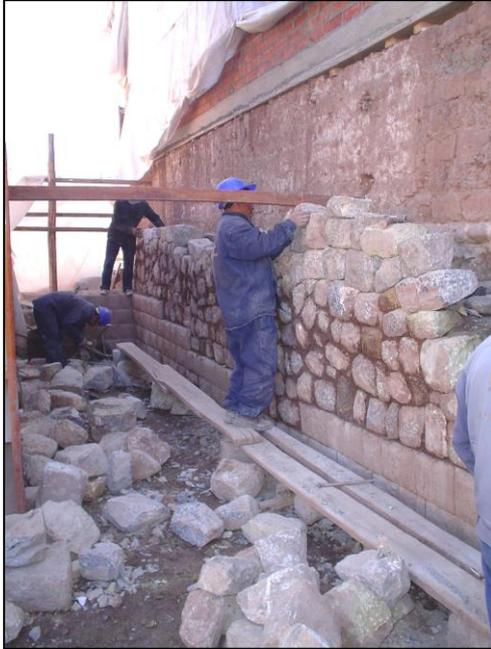
CONSTRUCCION DEL MURO DE APAREJO RUSTICO CON PIEDRA CALIZA PARALELA A LA PROPIEDAD DEL SR. BARRIONUEVO DENTRO DEL SECTOR III.
