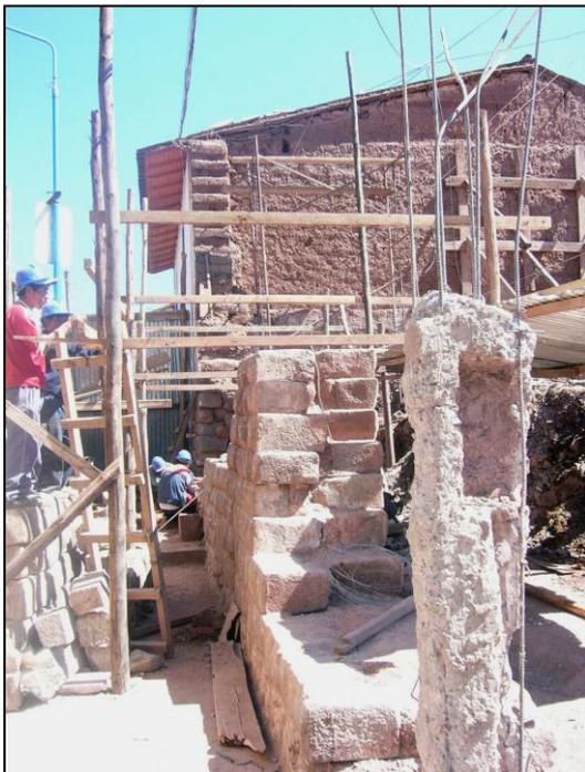
COLOCACION DE BALIZAS PARA LA RESTITUCION DE MUROS INKAS EN LA FACHADA HACIA LA PLAZOLETA DE SANTO DOMINGO
