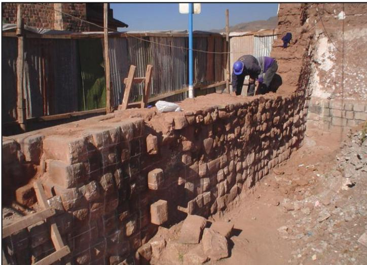
DESARMADO DE MURO REARMADO EN LA EPOCA DE LA COLONIA, CON LA UTILIZACION DE MATERIAL LITICO INKA.
