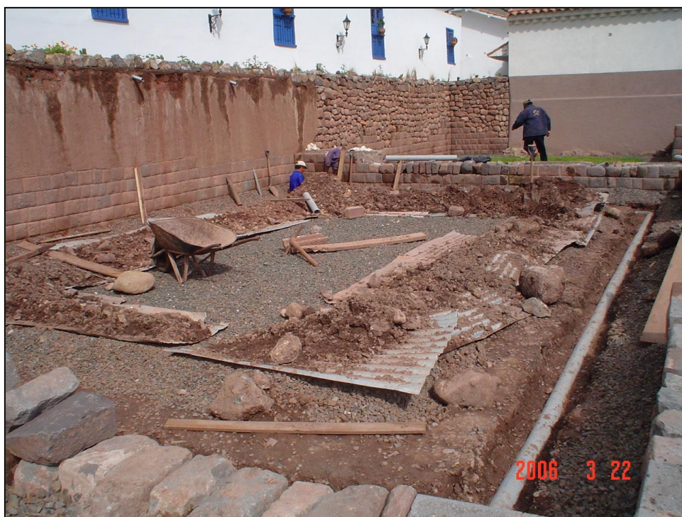
CONSTRUCCION DE DRENES PARA EVACUACION DE AGUAS POLUVIALES, DENTRO DE LOS RECINTOS 8,10, DENTRO DEL SECTOR III.
