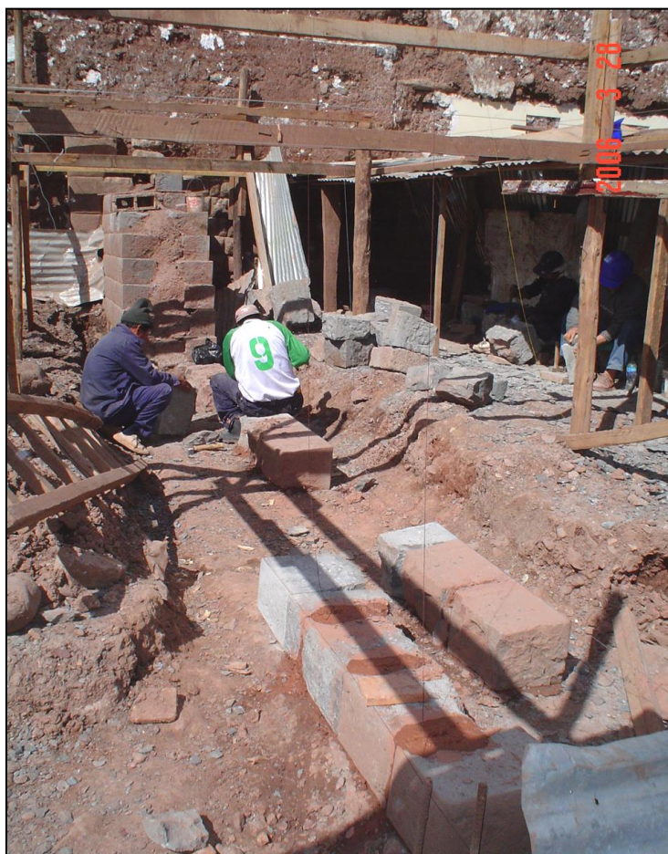
RESTITUCIÓN DE MURO DE APAREJO RÚSTICO SECTOR III.
