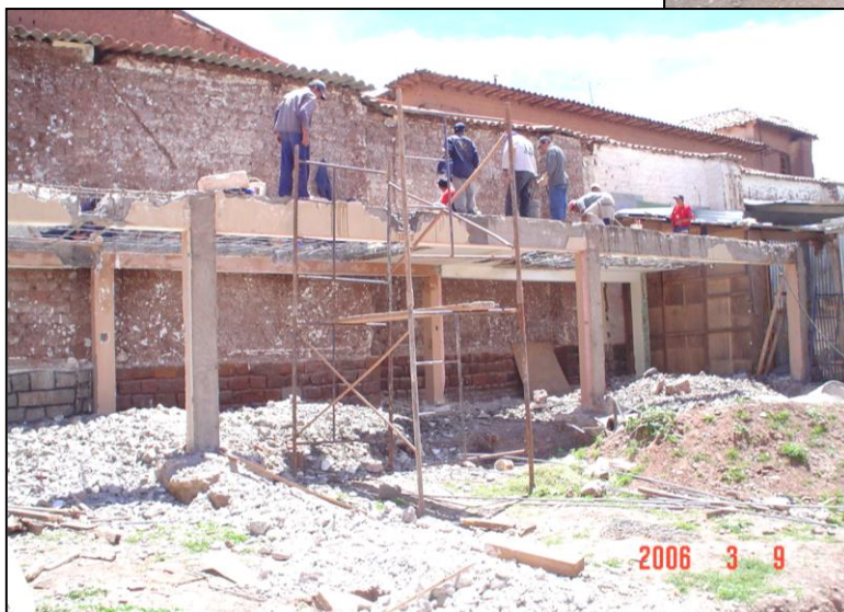
DEMOLICION DE ESTRUCTURAS DE CONCRETO UBICADOS EN EL SECTOR III.
