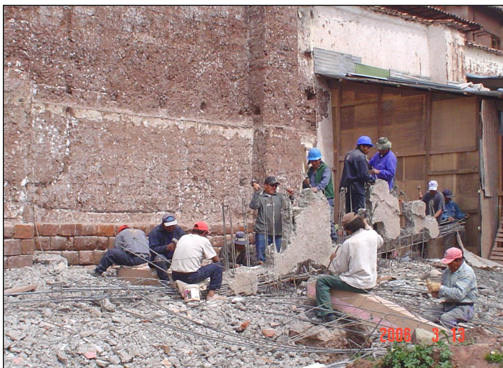
DEMOLICION DE ZAPATAS COLUMNAS Y ESTRUCTURAS DE CONCRETO UBICADOS EN EL SECTOR III.
