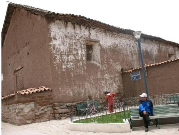
**EL MURO DE LA EPÍSTOLA:** Hacia el lado derecho de la estructura, posee dos vanos de acceso en arco de medio punto y presenta un vano de iluminación en arco de medio punto, ahora tapiado, dejando tan solo una ventana rectangular. Tiene dos contrafuertes y hacia la parte posterior adosado al muro se ubica la sacristía ya
