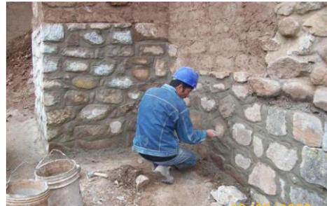
Método de Ejecución.- Se realizo el sellado de las juntas por un mortero mejorado de cal: arena, el mortero a utilizar es ser conformado por una mezcla cal: arena en proporción 1:3 con un
