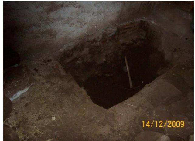
EXCAVACION DE ZANJA, PARA CALZADURA DE CIMENTO DEL MURO EVANGELIO, SECTOR PRESBITERIO DEL TEMPLO.
