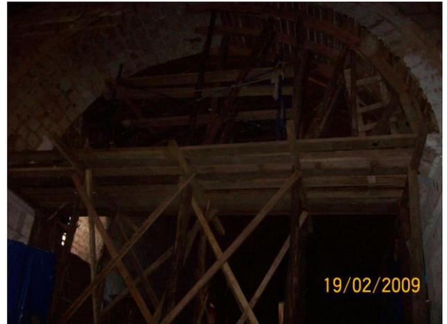
CIMBRADO DE ARCO TORAL, CON MADERA CORRIENTE Y ROLLIZOS DE EUCALIPTO.
