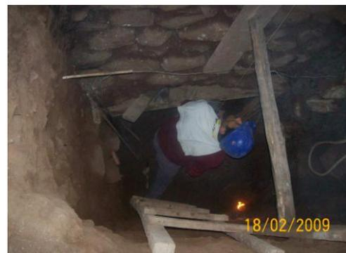
EXCAVACION DE ZANJA Y LIBERACION DE CIMIENTO DE PIEDRA Y TIERRA DE BASE DEL MURO DE LA EPISTOLA.
