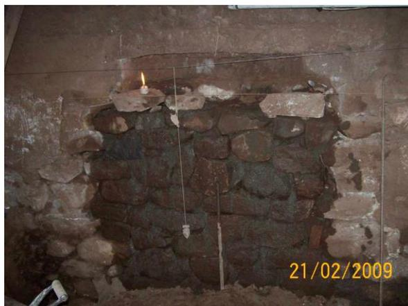
CALZADURA DE SOBRECIMIENTO, CON PIEDRA Y MORTERO DE CAL CEMENTO, EN INTERIOR DEL MURO DE EPISTOLA
