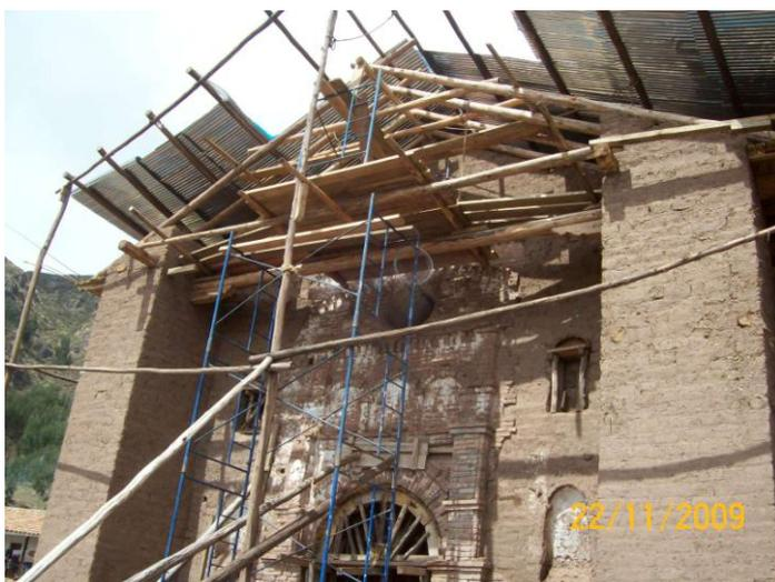
ARMADO DE ANDAMIO METALICO Y PLATAFORMA DE MADERA PARA RESTITUCION DE ESTRUCTURA DE TECHO EN SECTOR DE NARTEX.
