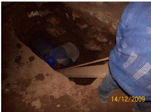
EXCAVACION DE ZANJA PARA CALZADURA DE CIMENTO DEL MURO EPISTOLA, EN SECTOR PRESBITERIO DEL TEMPLO.
