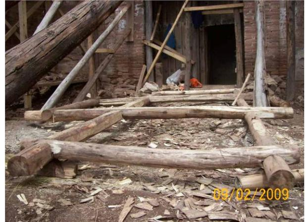
ARMADO EN SECO DE LLAVE EN "T", PREVIO AZUELADO DE ROLLIZOS DE EUCALIPTO Y TRATAMIENTO CON PRESERVANTE DE MADERA.
