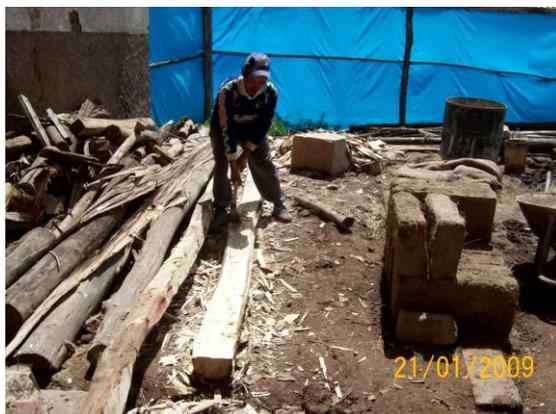
PREPARADO DE ROLLIZOS DE EUCALIPTO PARA COLOCACION DE LLAVES EN MUROS DE ADOBE, AZUELADO Y DESBASTADO.
