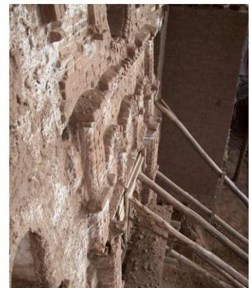
el interior del templo siendo el desplome de 45 cm en una altura de 6.50 mtrs. Dicho desplome se da partir del segundo, tercer cuerpo y astial del muro de pies. El primer cuerpo se encuentra erosionado las bases de los ladrillos, siendo necesario la consolidación y restitución de piezas deterioradas,
