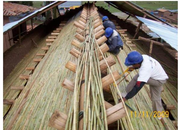
ENCARRIZADO DE FALDON CON CINTAS Y CARRIZO DE PRIMERA, FIJADOS EN ESTRUCTURA DE LOS PARES
