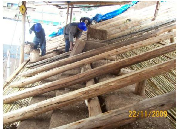
COLOCACION DDE SOLERA ARROCABE EN CABECERA MURO ADOBE, PARA FIJAR LOS SOBREPARES.
