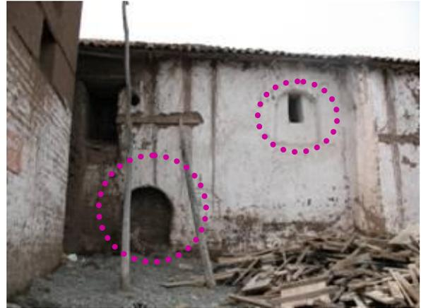
Hacia la izquierda de esta fachada, se aprecia un elemento de composición lítica fabricado de manera muy precaria; posiblemente un contrafuerte de piedra, con características morfológicas diferentes a las del podio, de pequeña altura mas baja y con estructuración diferente, que por su conformación y las particularidades de su entorno inmediato podría haberse colocado como un elemento de contención para evitar un posible desplome del muro.
