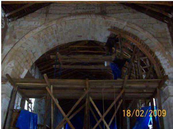
ARMADO DE PLATAFORMA DE MADERA PARA TRABAJO DE CIMBRADO DE ARCO TORAL
