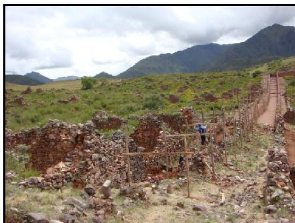
**Método de ejecución.-**Las crucetas o balizas se colocaron antes de desarmarse las estructuras a intervenirse y a una altura suficiente, por encima de las cabeceras los muros, luego se ha corrido 3 niveles de alambre N° 16 en forma horizontal, a las que se amarraron a determinadas distancias alambre de similares dimensiones
