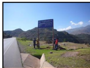
**Método de ejecución.-** Esta Partida se ejecuto utilizando brocha, thinner, pintura esmalte de color blanco, pintura esmalte de color azul ultramar y sobre la plancha metálica galvanizada según
