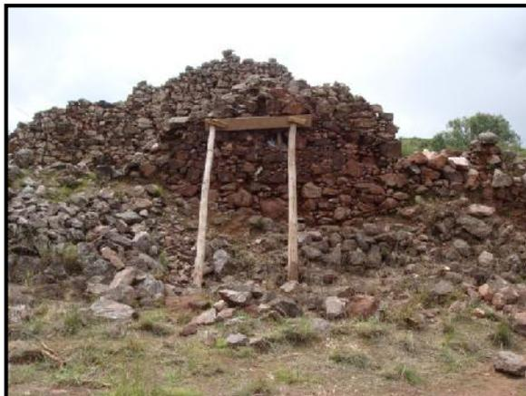
**Método y ejecución.-** Se aplico puntales de rollizo de eucalipto de 5"x 3 m. y de 5"x 4 m. y zapatas de madera corriente de 1 1/2"x8"x10.00
