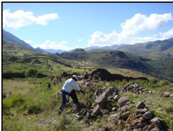
**Método de ejecución.-** Esta labor se ha efectuado mediante medios mecánicos como machetes y segaderas, con la finalidad de limpiar los paramentos de muro para fines de reticulado y codificado y posterior intervención física. Es necesario mencionar que antes del proceso de intervención estos paramentos se encontraban completamente cubiertos de arbustos y maleza, los que fueron retirados a fin de evitar su deterioro en el núcleo de muro.
