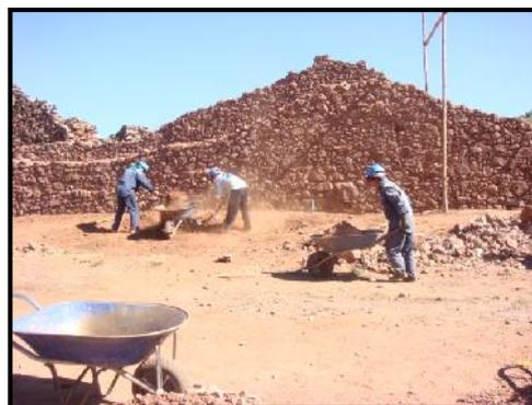
**Método de ejecución.-**Esta partida se ejecuta con la ayuda de instrumentos manuales consistentes en palas y buguies.
