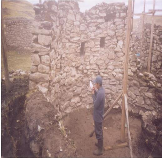
SE OBSERVA EL RETICULADO Y CODIFICADO DEL MURO MAS EL DIBUJO GRAFICO.
