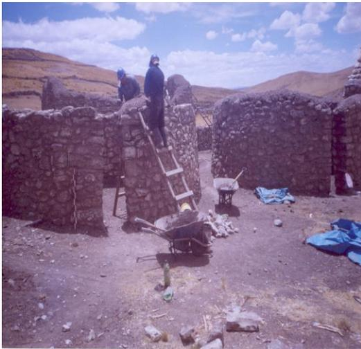
**SE APRECIA EL PROCESO DE TRAJO DE CUBERTINA DE PROTECCION EN LA CABERCERA DE LOS MUROS.**
