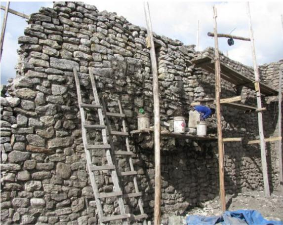
**SE OBSERVA EL PROCESO DE TRABAJO EMBOQUILLADO DEL MURO.**
