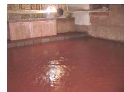
**Foto (212-213-214-215)** Restitución de ladrillo pastelero y fraguado en las capillas centrales del evangelio y epístola.
