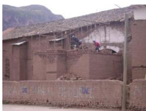
**Foto (71-72)** Vistas de los trabajos de restitución de muros de adobe en las capillas de la co sacristía y capilla central.
