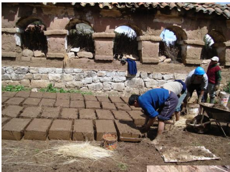
ELABORACION DE ADOBE DE 0.60x0.30x0.15: de acuerdo a las especificaciones técnicas.
