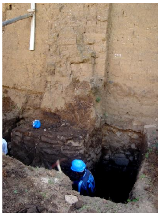
EXCAVACION DE ZANJAS PARA CALZADURA DE CIMENTACIONES : esta partida se ha aplicado en el muro de pies y exteriores del Templo
