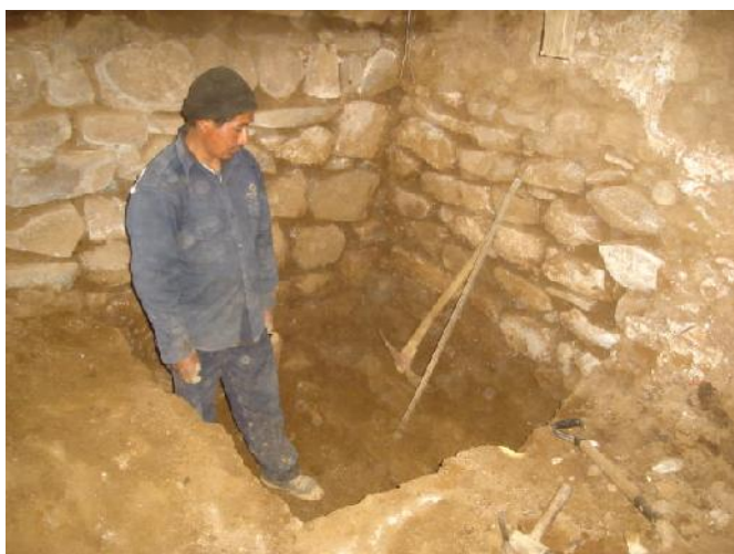
EXCAVACION DE ZANJAS PARA CALZADURA DE CIMENTOS CON ENTIBADO: Se realiza en el interior de la Nave, muro del evangelio, Epístola, y el muro Testero para la calzadura de las cimentaciones.
