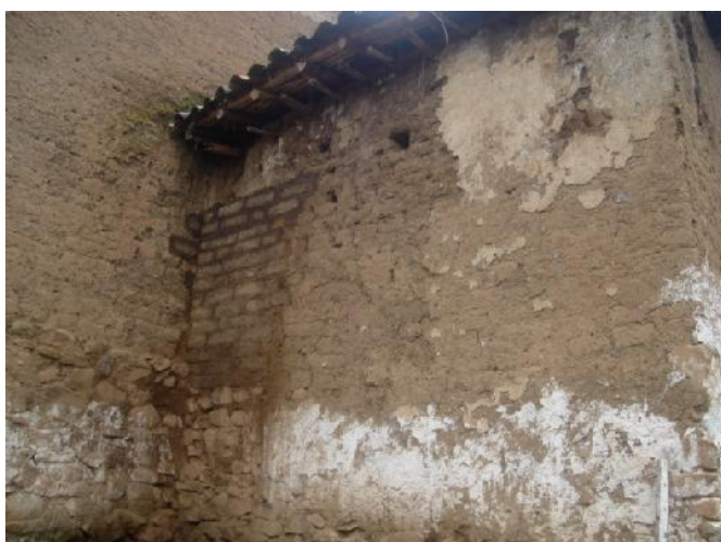
CALZADURA DE MUROS DE ADOBE: se ha realizado en los muros exteriores de la capilla de acceso al Coro y el CF04. restitución con adobes nuevos.
