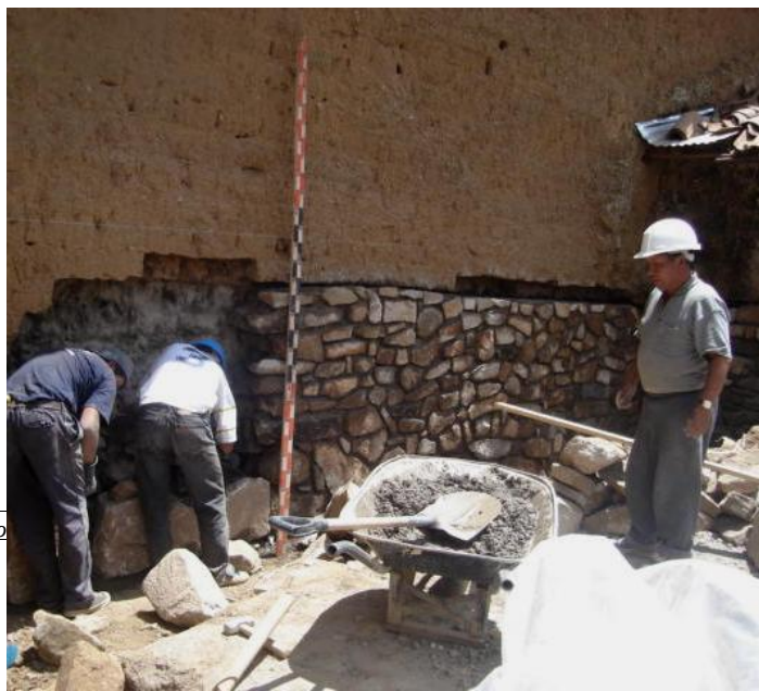
CALZADURA DE CIMENTOS CORRIDOS DE PIEDRA (Mortero=Cemento-cal-arena) en el interior y exterior de la Nave, muro de epístola y evangelio e interiores del Presbiterio.
