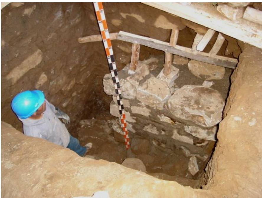
CALZADURA DE CIMENTOS DE PIEDRA (Mortero=Cemento-cal-arena) en el interior de la Nave, lado Evangelio y Epístola e interiores de Sacristía.
