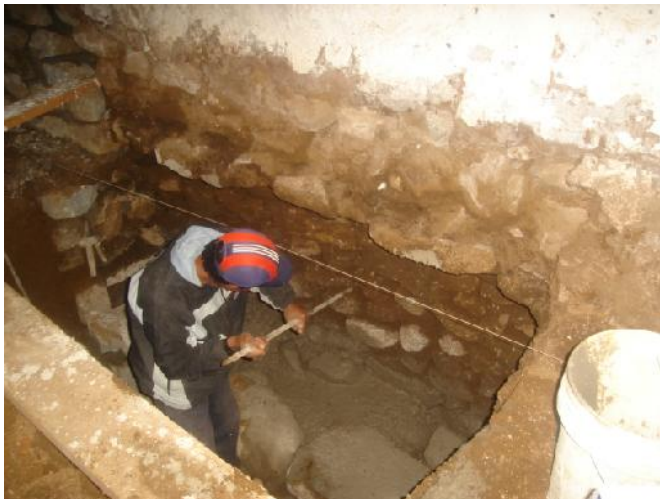
EXCAVACION DE ZANJAS PARA CALZADURA DE CIMIENTOS CON ENTIBADO: Para calzadura de cimentaciones en el sector de la Nave interior muro del Evangelio.
