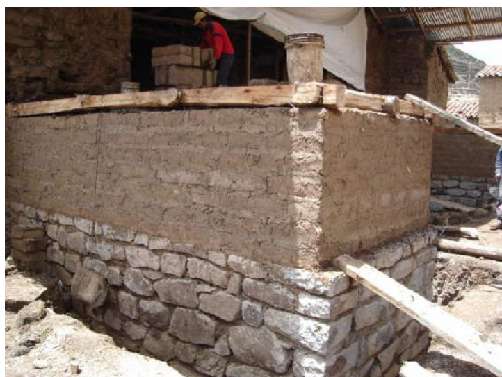
RESTITUCION DE MUROS DE ADOBE (0.60x0.30x0.15), se ha realizado en el muro testero del templo, con un ancho promedio de 2.00 metros.
