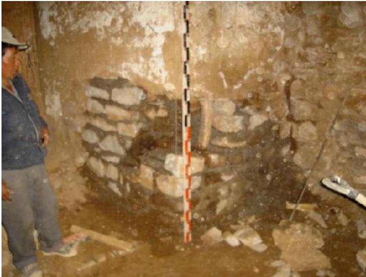
CALZADURA DE SOBRECIMENTOS DE PIEDRA (Mortero=Cemento-cal-arena) en el interior de la Nave, lado Evangelio y Epístola e interiores de Sacristía.
