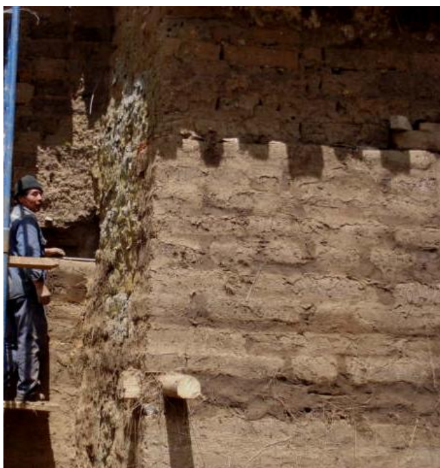
COLOCACION DE LLAVES DE MADERA EN "L" DE 6"x 4.00 m. (E = 1.20 m) esta partida se ha aplicado en el muro en los contrafuertes ubicados en los exteriores del muro del Evangelio y la capilla de Coro.
