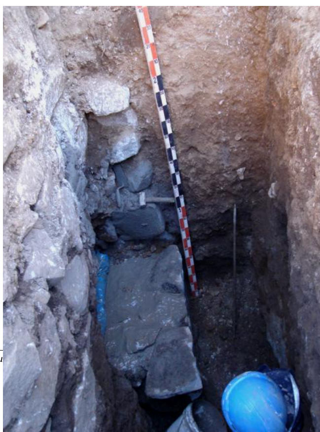
CALZADURA DECIMIENTOS CORRIDOS DE PIEDRA (Mortero=Cemento-cal-arena) en el interior y exterior de la Nave, muro de epístola y evangelio e interiores de sacristía.
