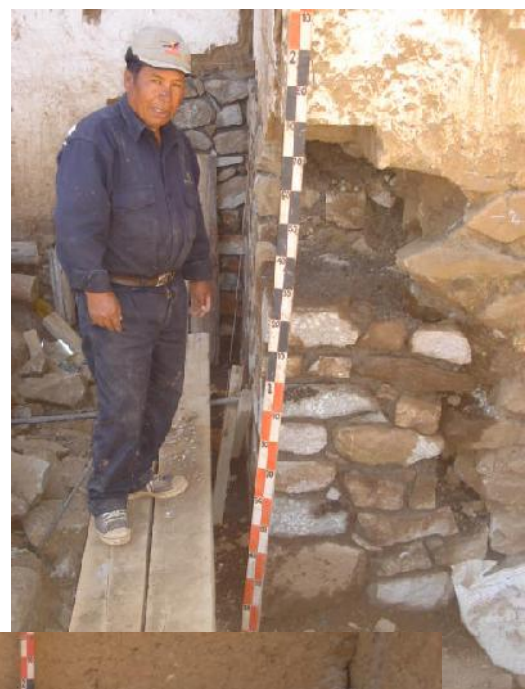
CALZADU RA DE SOBRECIMENTOS DE PIEDRA (Mortero=Cemento-cal-arena) en el exterior de la Nave, lado Evangelio y Epístola e interiores de Sacristía.
