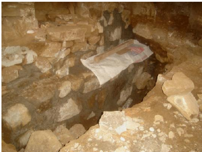
CALZADURA DECIMIENTOS CORRIDOS DE PIEDRA : en el sector de la Nave interior muro del Evangelio, la altura varia entre 1.2 a 2.00m. de altura.
