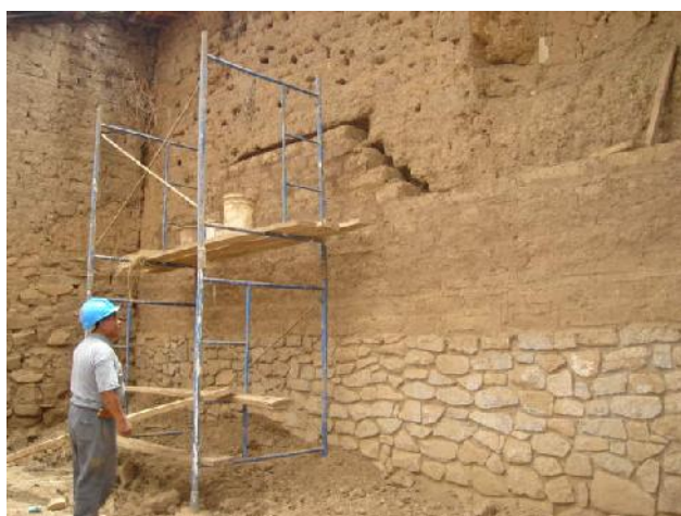
CALZADURA DE MUROS DE ADOBE, esta partida se ha realizado en los exteriores del muro del Evangelio, y contrafuertes.
