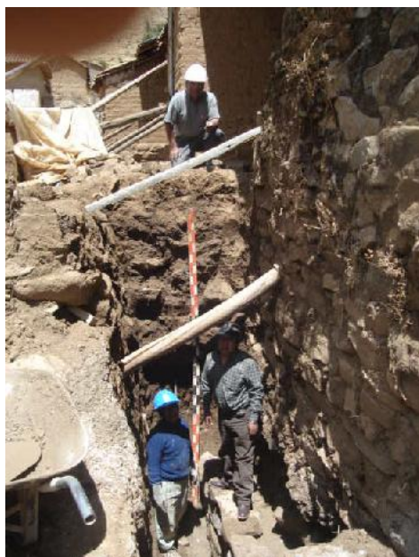
CALZADURA DE CIMENTOS CORRIDOS DE PIEDRA (Mortero=Cemento-cal-arena) en el interior y exterior de la Nave, muro de epístola y evangelio e interiores del Presbiterio.
