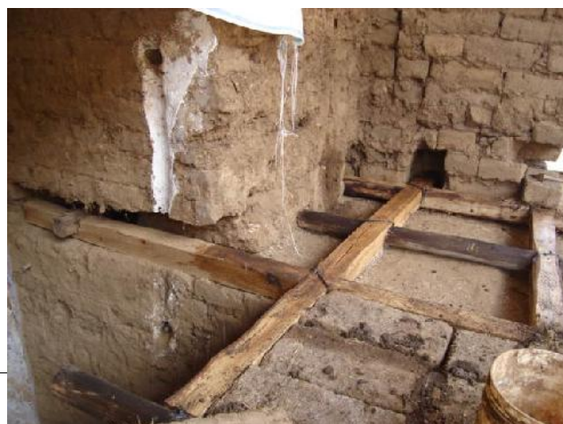
COLOCACION DE LLAVES DE MADERA EN "T" DE 8" X 5.00 m. (E = 1.80 m): esta partida se ha aplicado en el muro Testero del Templo
