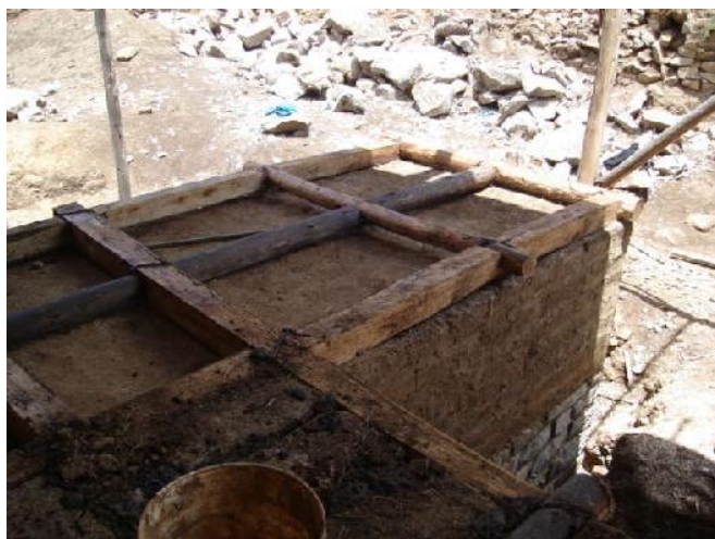
COLOCACION DE LLAVES DE MADERA EN "L" DE 6"x 4.00 m. (E = 1.20 m.) esta partida se ha aplicado en el muro Testero del Templo y en los contrafuertes ubicados en los exteriores del muro del Evangelio.
