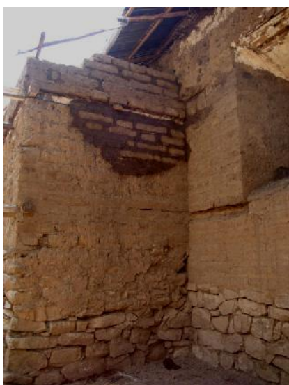
COLOCACION DE LLAVES DE MADERA EN "T" DE 8" X 5.00 m. ( E = 1.80 m): esta partida se ha aplicado en el muro Testero del Templo
