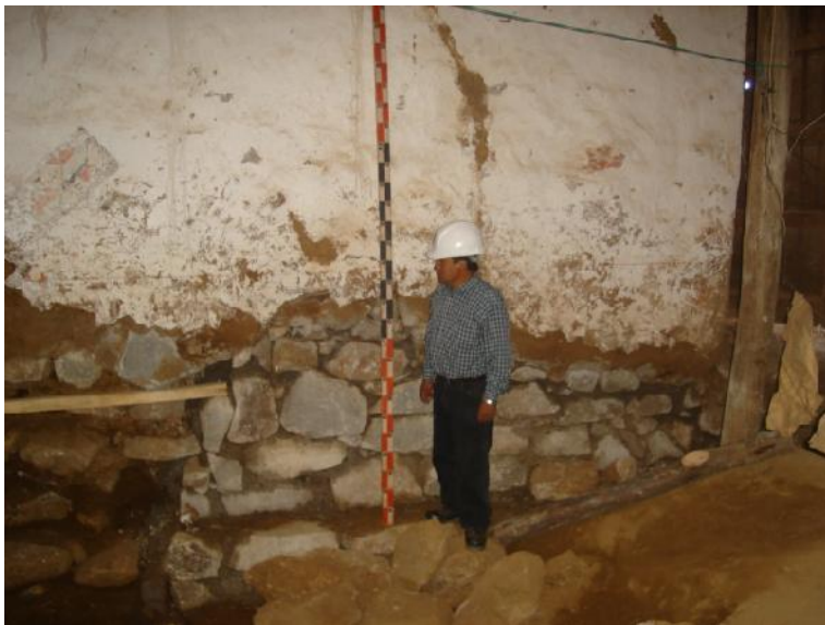
CALZADURA DE SOBRECIMENTOS DE PIEDRA (Mortero=Cemento-cal-arena) en el interior de la Nave, lado Evangelio y Epístola .
