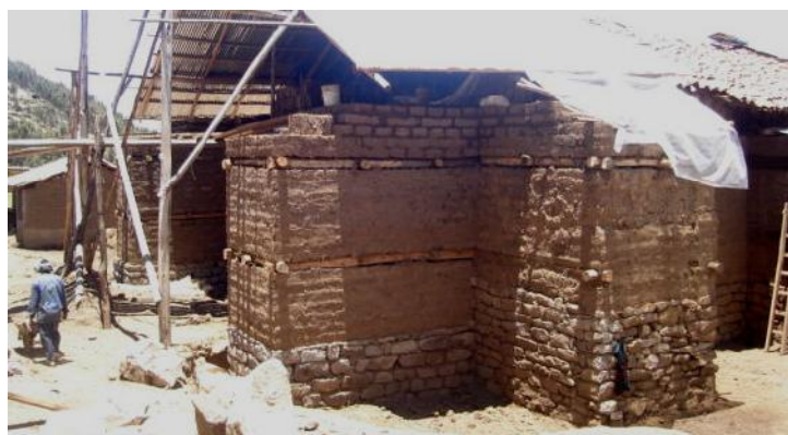
COLOCACION DE LLAVES DE MADERA EN "L" DE 6"x 4.00 m. ( E = 1.20 m.) esta partida se ha aplicado en el muro Testero del Templo y en los contrafuertes ubicados en los exteriores del muro del Evangelio.
