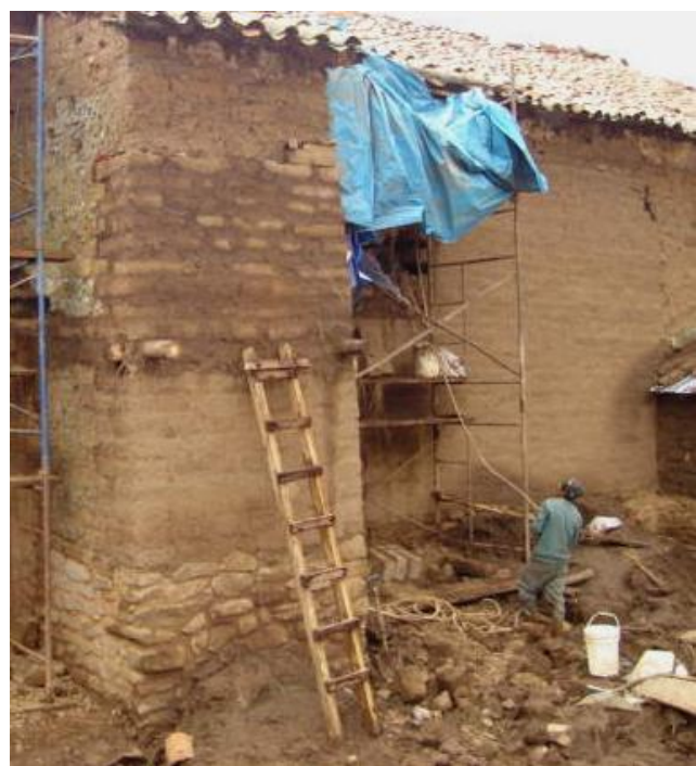
COLOCACION DE LLAVES DE MADERA EN "T" DE 8" X 5.00 m. ( E = 1.80 m): esta partida se ha aplicado en el muro exterior del muro de evangelio del Templo
