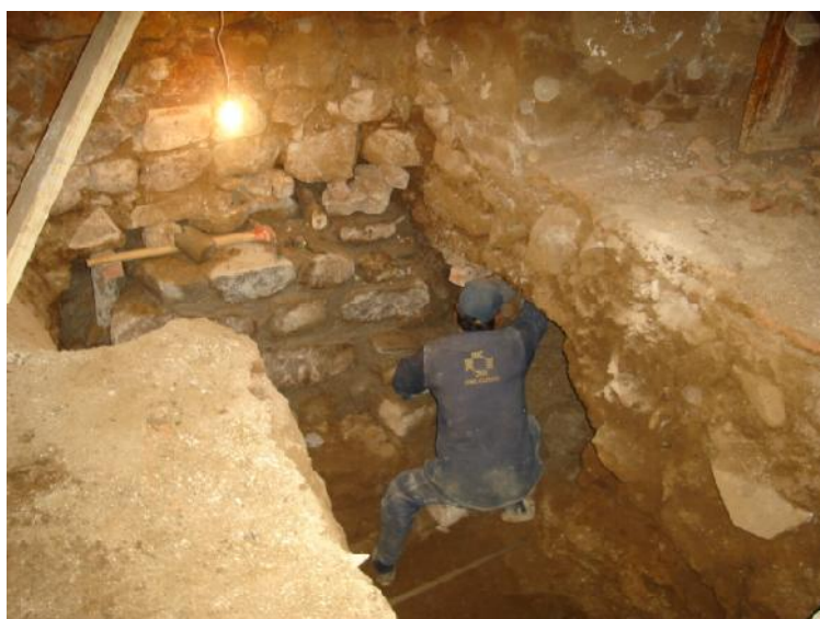
CALZADURA DECIMIENTOS CORRIDOS DE PIEDRA (Mortero=Cemento-cal-arena) en el interior de la Nave, muro de epístola e interiores de sacristía.
