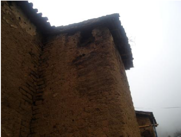
LIBERACION DE MUROS DE ADOBE: En los sectores de la Capilla de acceso al Coro, y Contrafuerte 04 (CF 04) muros exteriores.
