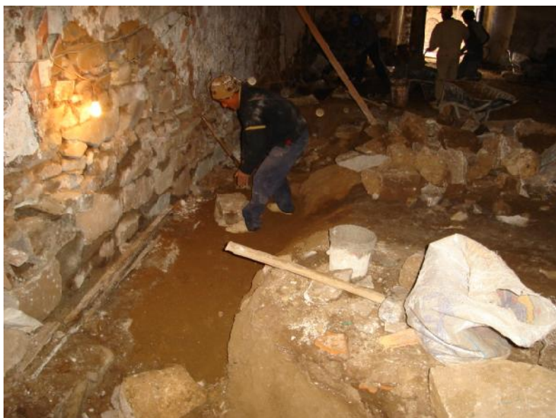
RELLENO CON MATERIAL PROPIO: Utilizando pison de mano, después de realizar la calzadura de cimientos corridos de piedra en el interior de la Nave, muro del epístola.
