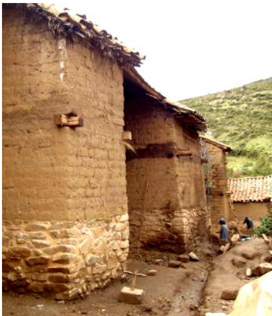
CONSOLIDACION DE SOBRECIMENTOS DE PIEDRA, Aplicado en los muros exteriores del Muro de Evangelio.
