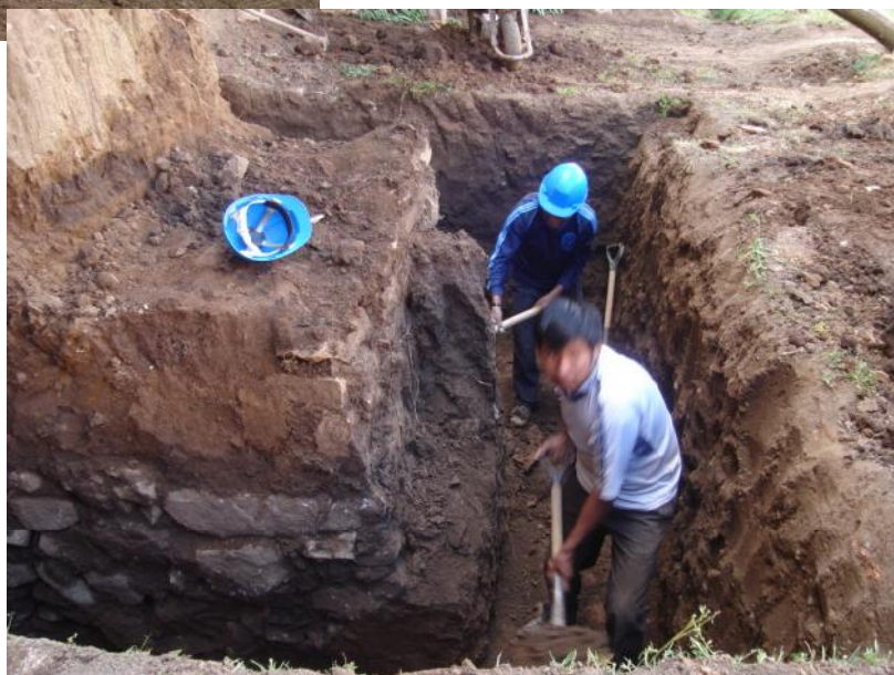
EXCAVACION DE ZANJAS PARA CALZADURA DE CIMENTOS CON ENTIBADO: Se realiza en el interior de la Nave, muro del evangelio, para la calzadura de las cimentaciones.
