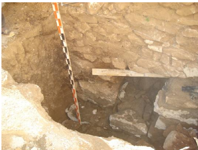
CALZADU RA DE SOBRECIMENTOS DE PIEDRA (Mortero=Cemento-cal-arena) en el exterior de la Nave, lado Evangelio y Epístola e interiores de Sacristía.
