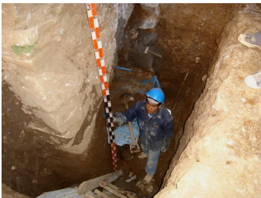
En algunos tramos se ha realizado la excavación de zanjas para calzaduras hasta más de 3.00 metros de altura.
