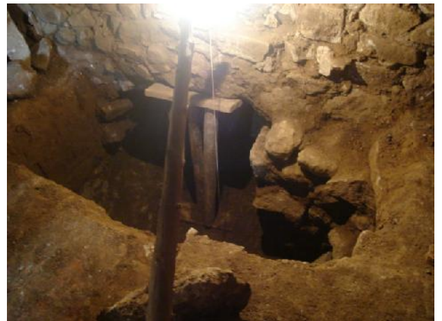
EXCAVACION DE ZANJAS PARA CALZADURA DE CIMIENTOS CON ENTIBADO: Para calzadura de cimentaciones en el sector de la Nave interior muro del Evangelio.
