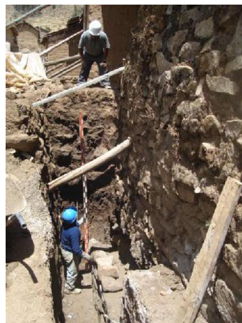
CALZADURA DE CIMENTOS CORRIDOS DE PIEDRA (Mortero=Cemento-cal-arena) en el interior y exterior de la Nave, muro de epístola y evangelio e interiores del Presbiterio.
