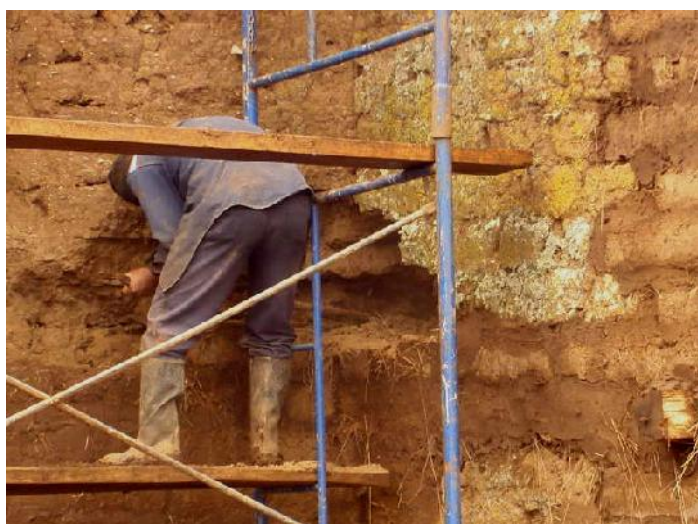
LIBERACION DE MUROS DE ADOBE : Esta partida se ha realizado en el muro exterior Evangelio para la calzadura de muros de adobe.
