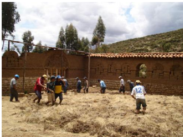
ELABORACION DE ADOBE DE 0.60x0.30x0.15, para realizar los trabajos de calzaduras y restitución de muros de adobe en el muro testero y exteriores del muro de evangelio.
