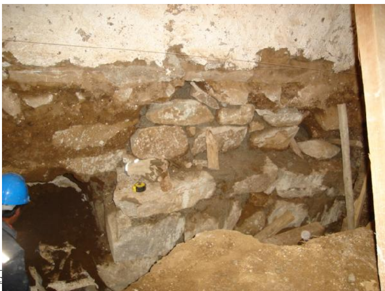
CALZADURA DE SOBRECIMENTOS DE PIEDRA (Mortero=Cemento-cal-arena) en el interior de la Nave, muro de epístola e interiores de Sacristía.
