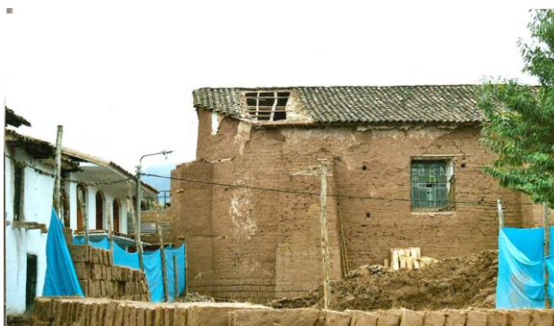
ETAPA DE EXPLORACION DE LA CUBIERTA Y LIBERACION DE EMBARRES EXTERIORES: MURO DEL EVANGELIO Y SECTOR DEL TESTERO.
