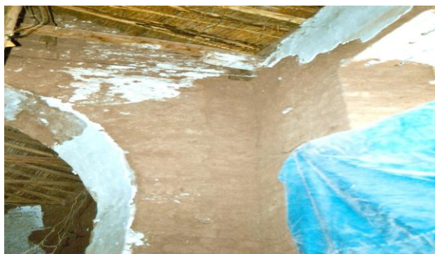
FASE DE EXPLORACION DE MUROS : RETIRO DE EMBARRE A EFECTO DE VERIFICAR EL ESTADO DE CONSERVACIÓN DE LA MISMA
