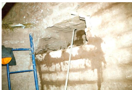
FASE DE CALZADURA DE LOS MUROS DE ADOBE DE 1.50 M DE SECCION.
