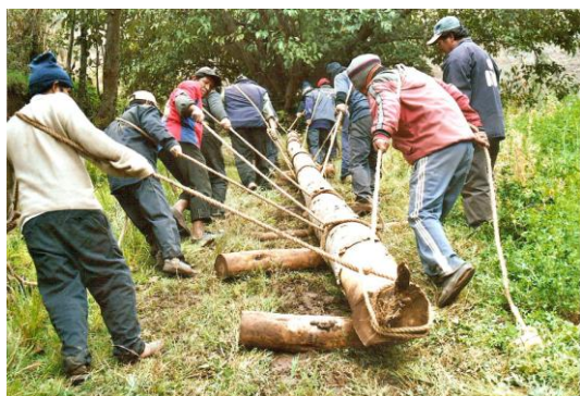
TRANSPORTE DE ROLLIZOS DE 8" X 12.50 PARA SU UTILIZACIÓN COMO TIRANTES EN LA CUBIERTA DEL PRESBITERIO Y LA NAVE, SECTOR DEL CORO.
