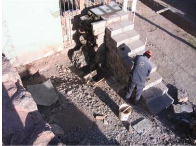
ASENTADO DE PASOS PARA ESCALINATA Y CONSTRUCCION DE MURO BASE.
