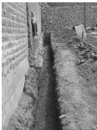
ZANJADO PARA TENDIDO ELECTRICO SUBTERRANEO
