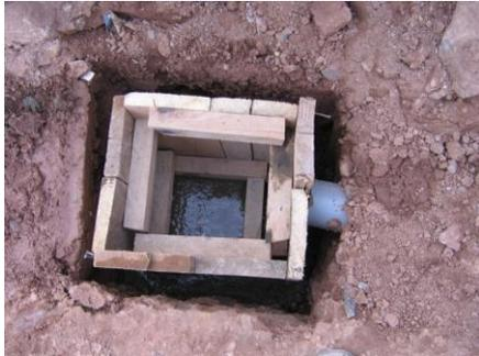
ENCOFRADO DE CAJA DESARENADORA
