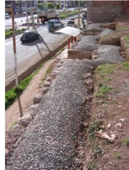
Consolidación de muros de contención de aparejo simple
