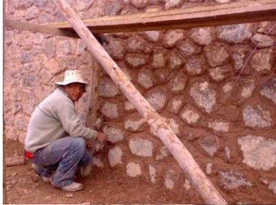
CONSOLIDACION Y EMBOQUILLADO DE MUROS.
