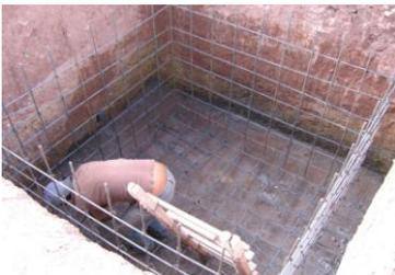
RESERVORIO DE 3 M3 ARMADO DE ACERO
