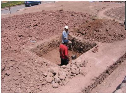
EXCAVACION MANUAL Para construcción de reservorio.
