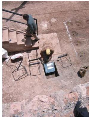
INSTALACION Y COLOCACION DE REFLECTOR Y REJILLA METALICA EN CAJA DE C°
