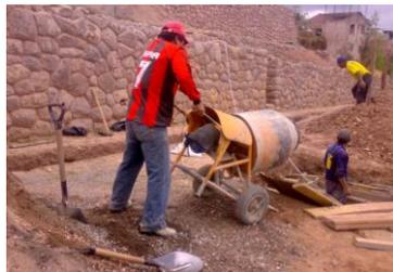
RESERVORIO DE 3 M3 VACIADO CON MEZCLADORA
