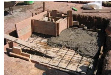
RESERVORIO DE 3 M3 VACIADO TAPA
