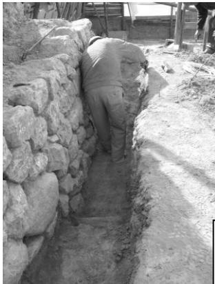
EXCAVACION EN LA BASE DEL MURO A RECOMPONER
