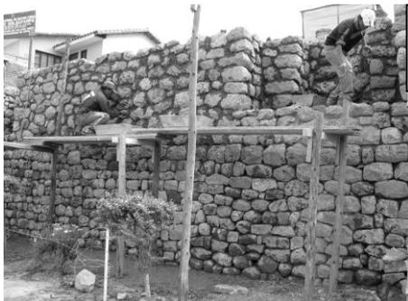
ARMADO DE ANDAMIO Y PROCESO DE EMBOQUILLADO
