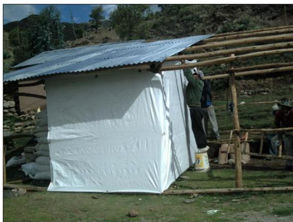
Arriba izq. y der. cobertura provisional de cabeceras de muro para su protección con plástico triple ancho, tierra y paja
