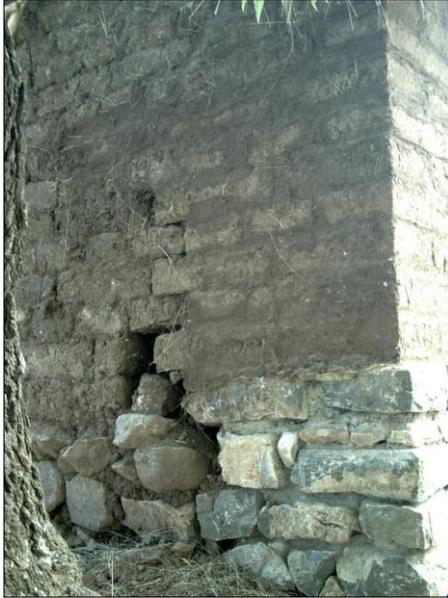
Calzadura de muro de adobes en esq. de muros del evangelio y de pies (izquierda y abajo)
