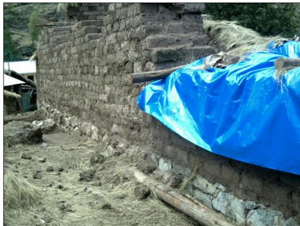
Cobertura de muros y pilas de adobe con plástico y arpillera y con paja
