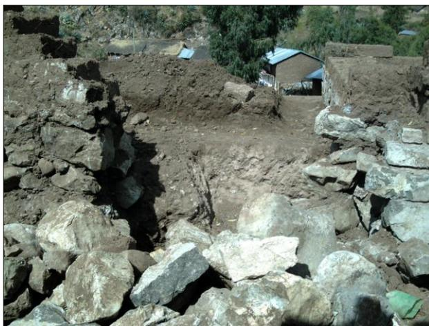
Calzadura de muro de adobe muro de pies
