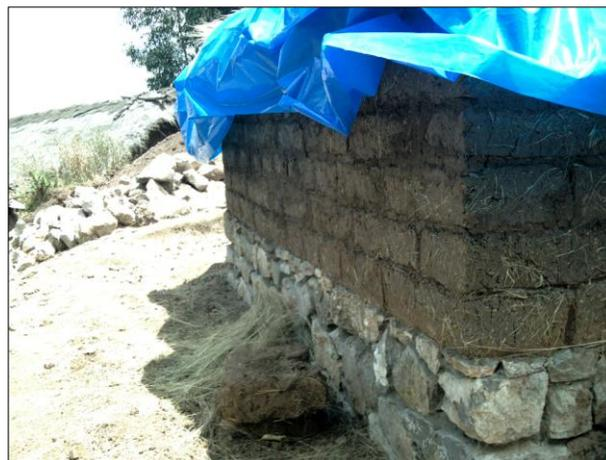
Restitución de las primeras hiladas de los muros de la torre exenta
