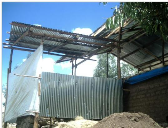
Arriba y abajo colocación de cerco perimétrico y provisional para la protección de la capilla elaborado con arpillera y planchas de calamina; además de cubierta provisional con planchas de calamina y estructura de rollizos de eucalipto.
