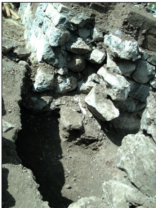
Liberación y desmontaje de cimientos y sobrecimientos muros del evangelio (abajo) y de la epístola (izquierda), con liberación de muro de adobe
