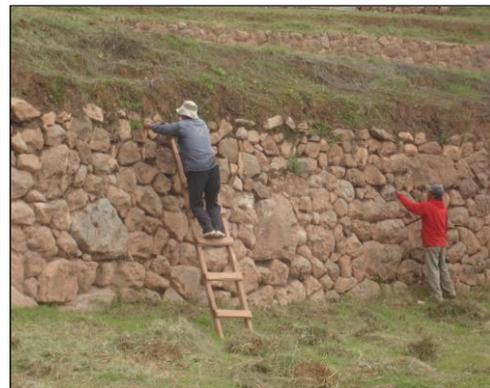
Fotos N° 03, 04 observando la partida eliminación de maleza y arbustos en paramento
