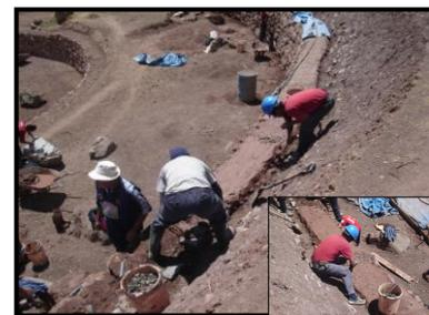
aguas pluviales al núcleo del muro. La preparación de la mezcla, incluye cal, arcilla y tierra bien cernida en una proporción de tierra (3), arcilla (2) a la mezcla final se le agrega arena como elemento cohesionante colocándose el mortero en una altura de no mayor de 0,10m recubriendo la totalidad de la cabecera. Estos trabajos se efectuaron en toda la zona intervenida como son los andenes del 1er al 4to así como en el Canal Inka, Esta labor
