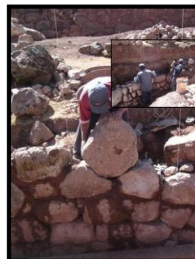
En este sentido, la restitución de muros se ciñó estrictamente a la acción física de volver a colocar o encimar, hilada por hilada, aquellos elementos colapsados de la estructura, y que se hallan generalmente al pie de los muros de los andenes sin añadir ninguna otra pieza lítica para completar la totalidad de ellas. Es decir que la intervención concluyó en el momento que se colocó el último elemento lítico existente en las inmediaciones del muro o estructura.
