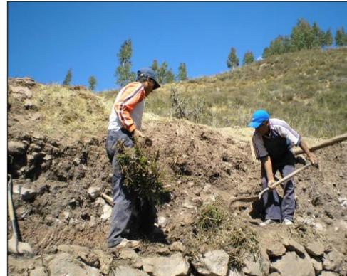
Fotos N° 13,14 Se realizan trabajos de la partida eliminación de Raíces regulares.
