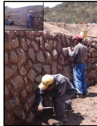
**Métodos de ejecución.-** Consistió en colocar mortero de una mezcla de arcilla, tierra, cal y gigantón; que fue colocado en los espacios vacíos garantizando su estabilidad y permanencia de los muros intervenidos.
