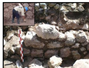
contención, están en un estado de grave deterioro, habiendo desaparecido casi en su totalidad poniendo por ende en proceso de colapso el muro entero (se aplicó generalmente en la base de los andenes). Se aplicó una mezcla preparada de cal, arcilla, tierra, en la siguiente proporción 01:03:0 en los espacios limpiados previamente de mortero intemperizado, antiguo y cansado. Esta mezcla no cubrió las piezas líticas arquitectónicas componentes del aparejo. Esta partida comprendió:
