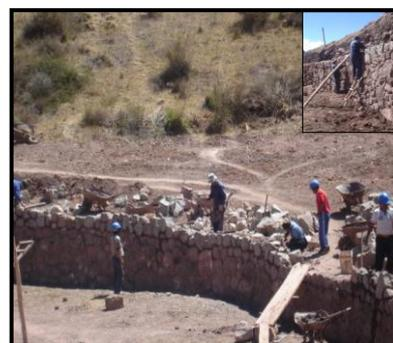
nuevos usos) , la intervención de “restitución de muros y/o estructuras ” debe conceptuarse como la acción de “devolver a la estructura aquellos elementos que se encuentran en sus inmediaciones y de cuya ubicación se tiene certeza” es decir, que aquellos elementos colapsados por diferentes causas, deben volver a construir realmente parte de las estructuras y
