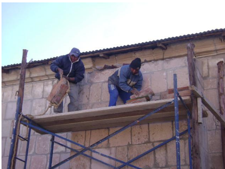
Liberación de la tejas del contrafuerte.
