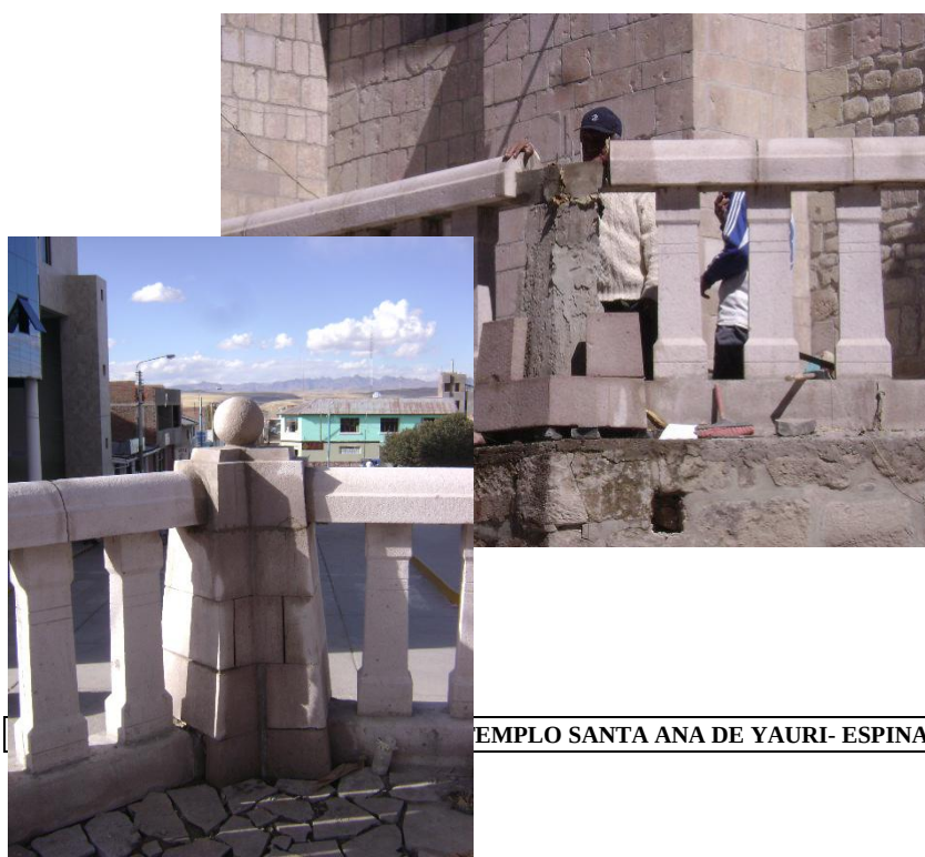
Vista d la colocacion de la tapa del la barda, y la columna de concreto lista para ser enchapada (enchapado de la columna en la foto inferior)
