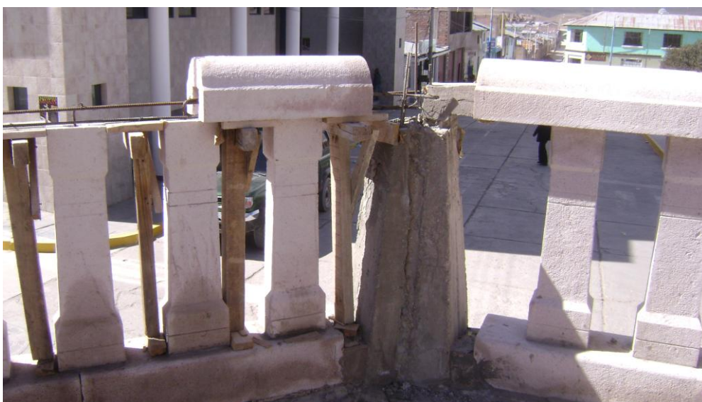
Vista d la colocacion de la tapa del la barda, y la columna de concreto lista para ser enchapada (enchapado de la columna en la foto inferior)
