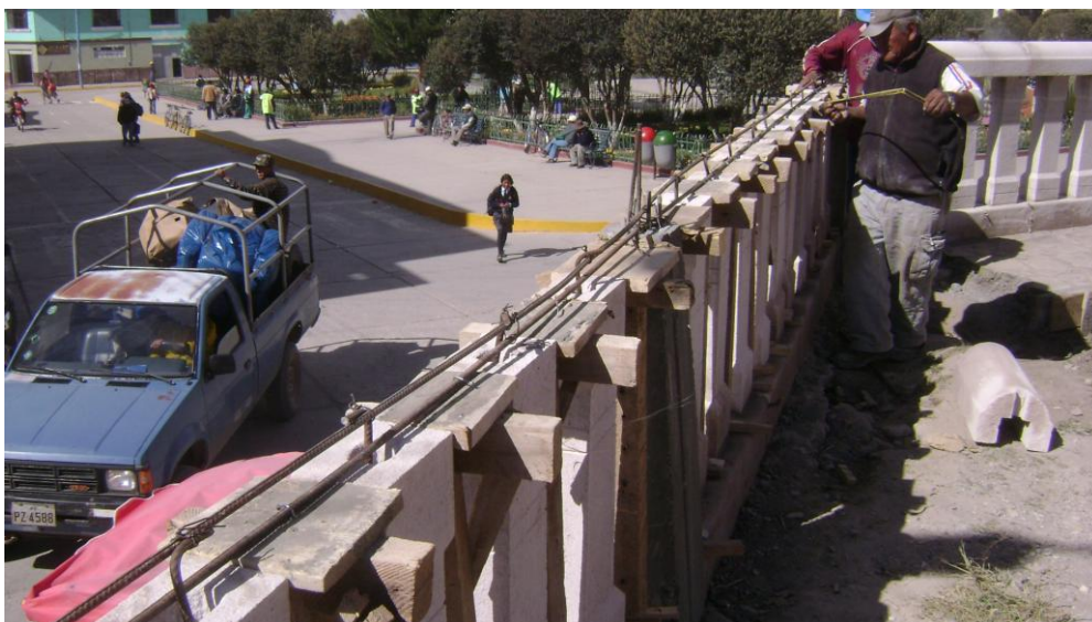
detalle del armado y encofrado de la balastrada de la barda
