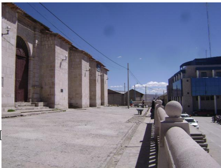
Vista del atrio terminada el empedrado del canto rodado y la vereda
