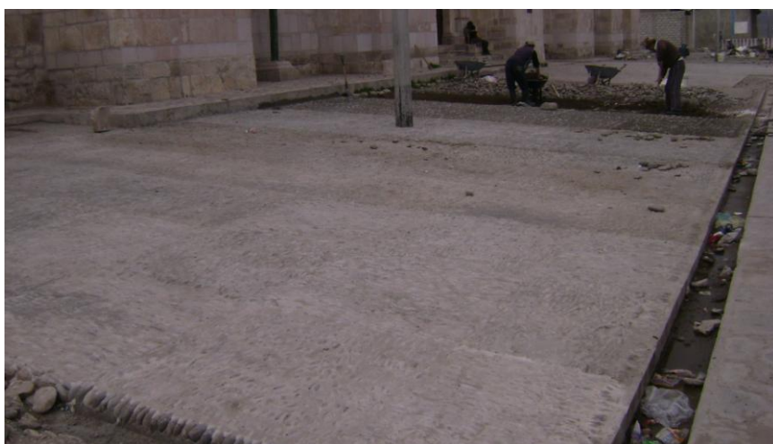
Vista del emboquillado del empedrado del atrio
