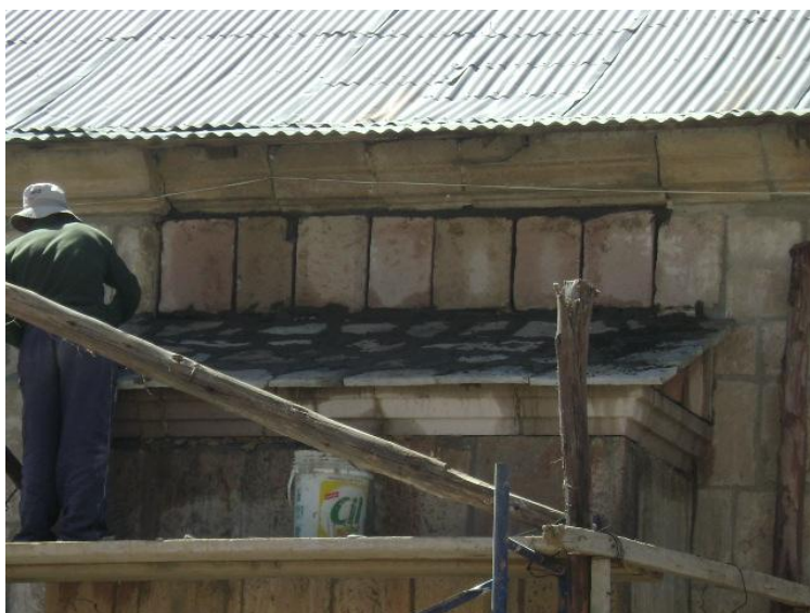
Colocación de la laja 3 En el contra fuerte
