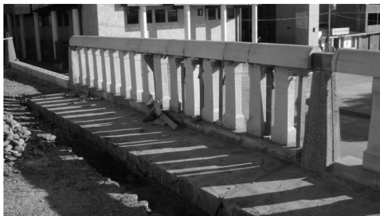
Vista de los trabajos de vereda adyacente a la barda de atrio, y el canal de evacuación de aguas pluviales
