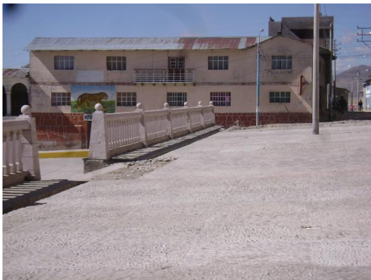
Vista terminada de empedrado de canto rodado en el atrio.
