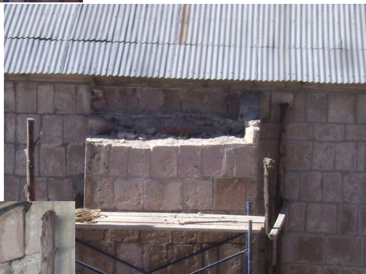
Vista de la liberación de sillar en el contrafuerte
