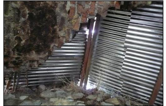
Se realiza trabajos de proteccion, como cubierta provicional de calamina, apuntalamiento de claves en los oculos de la torre Cusco.
