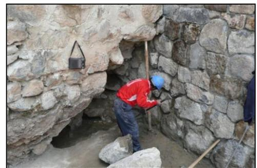
Se realiza trabajos de calzaduras de Sobrecimientos en el muro testero y en el contrafuerte del mismo, con mortero Cemento:Hormigón:Cal.
