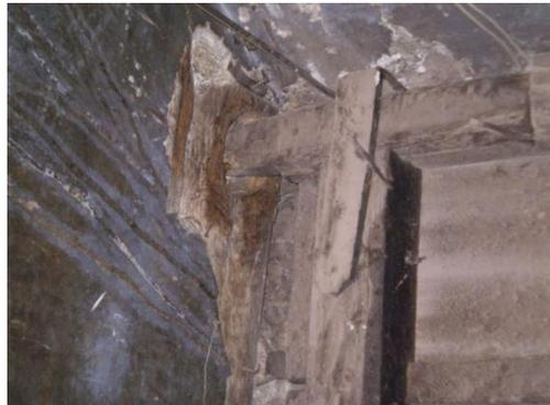
La realización del desmontaje, en el caso de los elementos de madera tallados se ha realizado con el cuidado necesario y reemplazado los elementos muy deteriorados que ya no prestan garantía y a todos se les sometió a tratamiento especializado para mayor y mejor resistencia.
