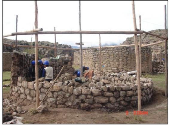
SECTOR IV R-8 TRABAJOS DE RECOMPOSICION DE MUROS Y EMBOQUILLADO
