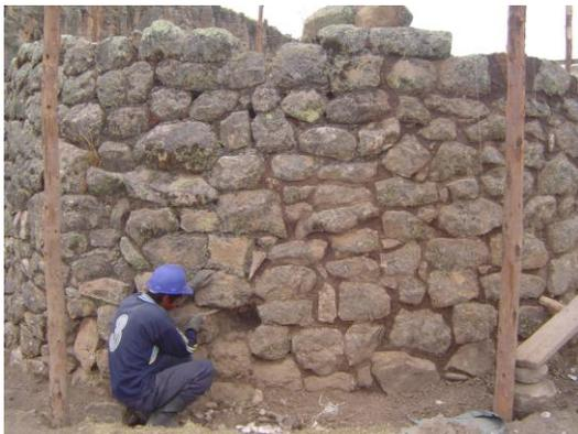
Sector I-B Calzadura y consolidación de muros
