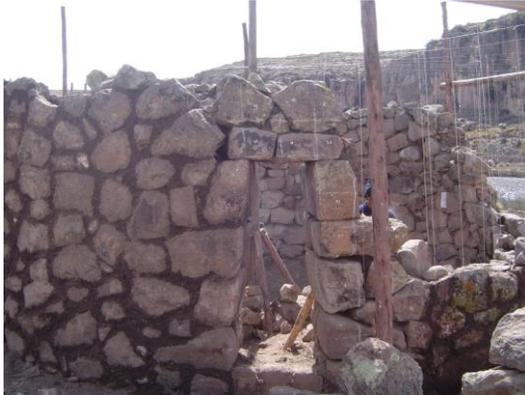
Sector I-B Calzadura y consolidación de muros
