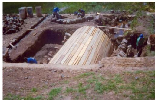
Foto N.45. 46.- Entablándose loa siembra del molino para su armado
