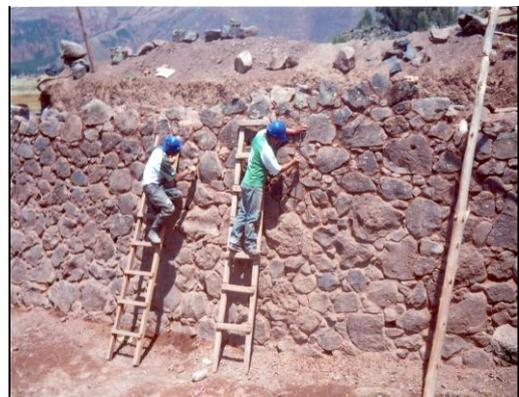
Foto N.-12 Emboquillado de juntas
