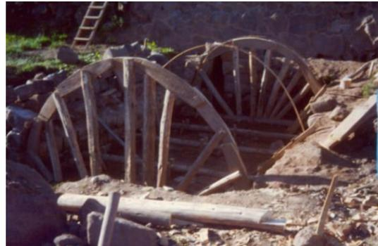
Foto N. 43.- 44.-Observando se el armado de la ciembra de la bóveda del molino de chullamallki
