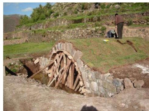
Foto N.47.- Se Observa el armado en seco
