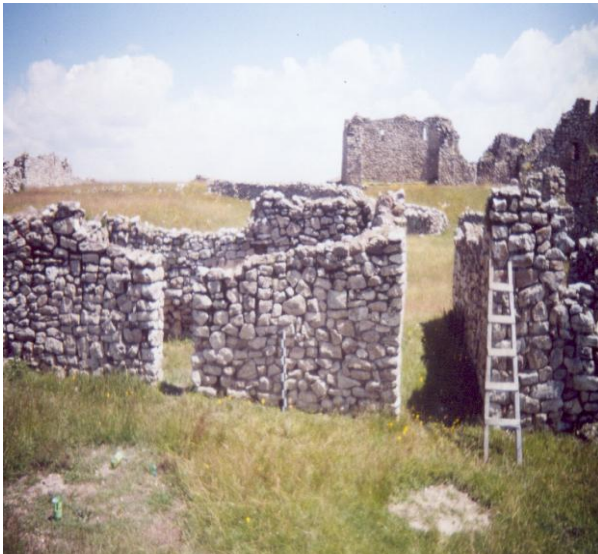
SE OBSERVA ANTES DE SU INTERVENCION EN EL SECTOR TINKUQ R
