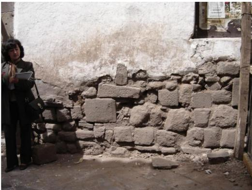
La **crujía frontal** responde a una estructura de filiación colonial cuya cimentación ha sido lograda con piedra y complementada con adobes, tiene dos niveles, y ostenta al menos cuatro ambientes tanto en el primer nivel como en el segundo nivel. En el segundo nivel de esta crujía, las **cubiertas** han sido tratadas con cielos rasos, al estilo neoclásico, esto indica la adecuación a las nuevas tendencias neoclásicas en el Cusco.
