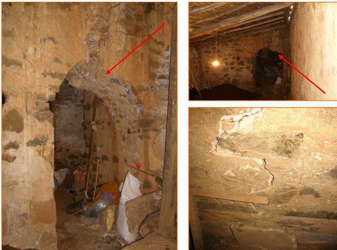
Muestras del desfase en el muro a partir del agrietamiento longitudinal.
