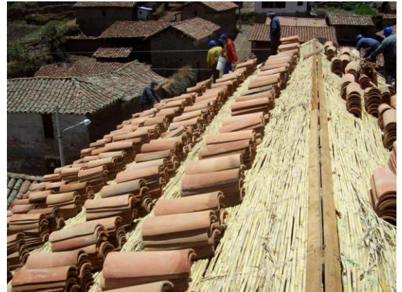
Disposición de tejas en el techo, antes del asentado.
