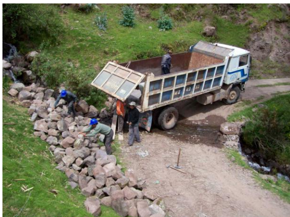
Trabajos de acopio y carguio de piedra en volquete de distrito de Acos.
