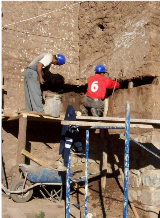
Liberación de muro de adobes para colocación de llave en L , en encuentro de contrafuerte y muro de pies.
