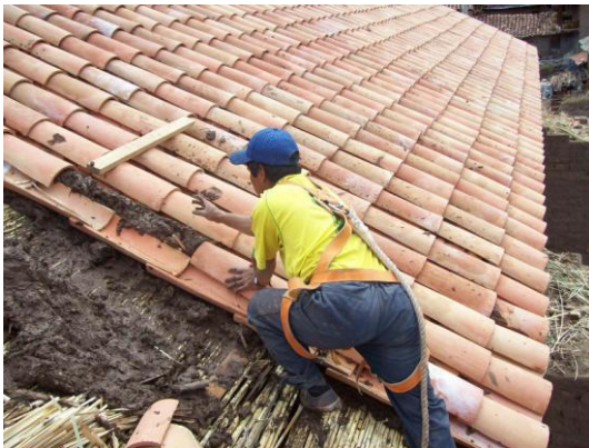
Colocación de teja sobre torta de barro en techo de sector de presbiterio
