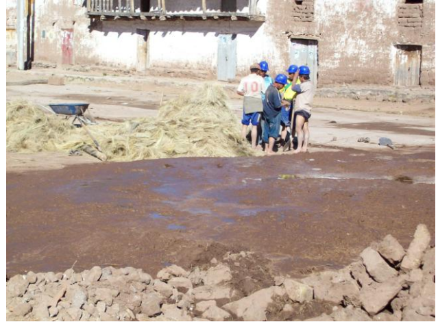
Preparación del barro para elaboración de adobes.
