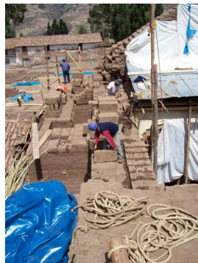
Restitución de contrafuertes de adobe en lado epístola sector sotocoro
