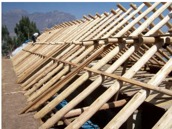
Proceso de colocación de pares y nudillos
