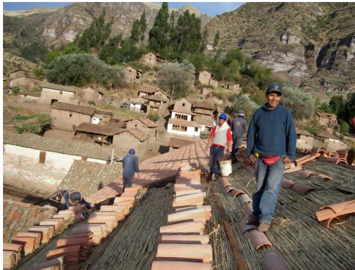
Proceso de restitución de cobertura de teja en techo del templo, sector nave.
