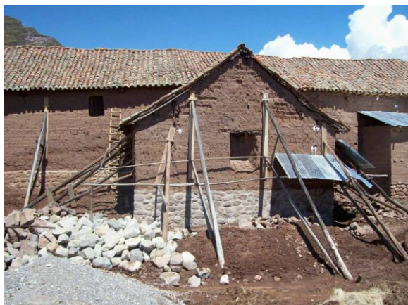
Calzadura de sobrecimientos con mortero de cal cemento en exterior de muro testero.
