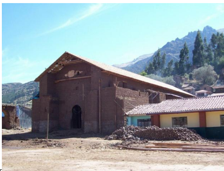
Vista de elevación principal del templo, después de finalización de trabajos de restitución de cobertura de teja.
