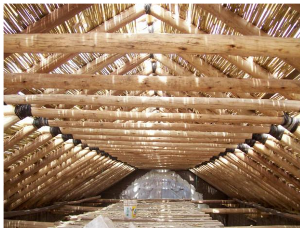
Vista del interior del techo par y nudillo
