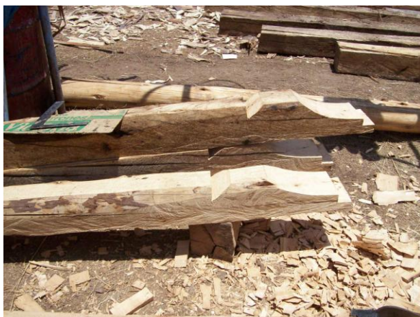
Restitución de ménsulas en madera aliso, según evidencia encontrada
