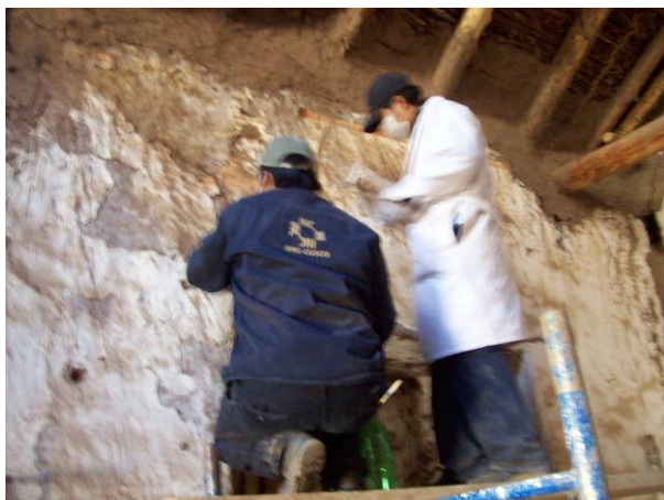
Trabajos de limpieza superficial y liberación de recubrimientos de pintura mural
