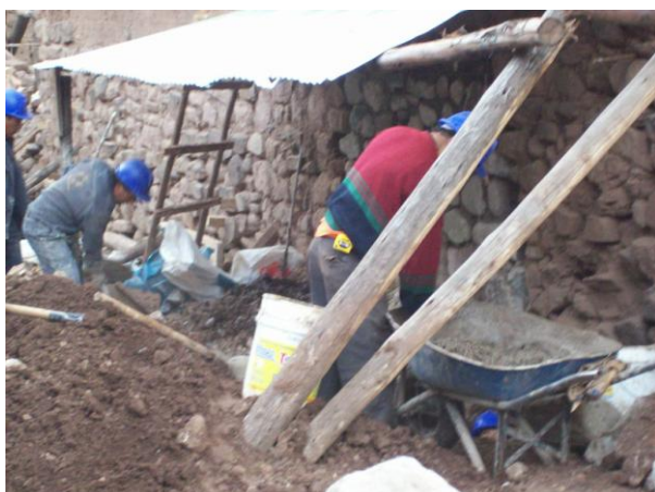
Trabajos de calzaduras de sobrecimientos en exterior de muro testero sector presbiterio
