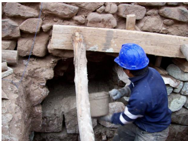
Trabajos de calzadura de cimientos con mortero de cal cemento.
