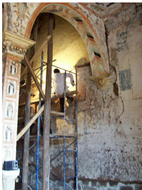
Trabajos de consolidación, limpieza profunda de pintura mural. En sector de nave lado epístola.
