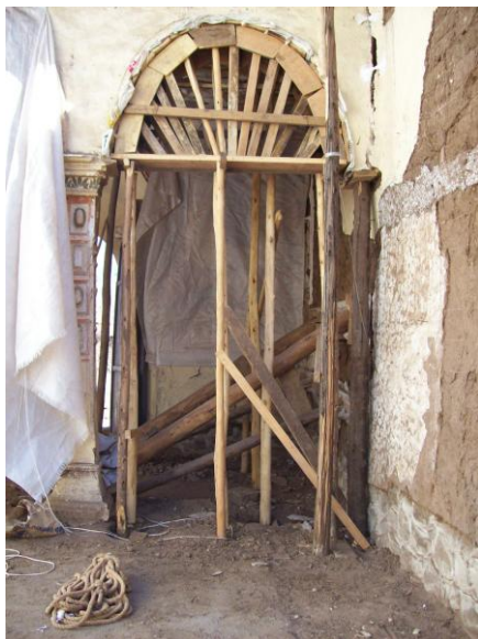
Cimbrado de arquería del sector de sotocoro, con madera corriente y revoque de eucalipto.
