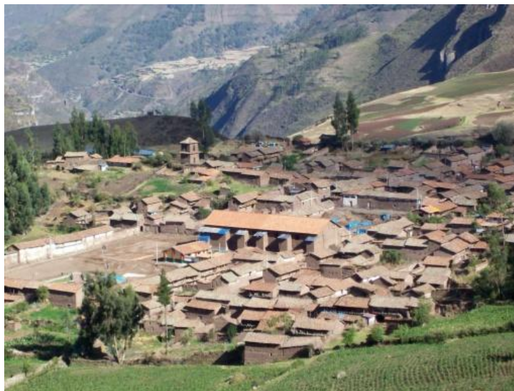
Vista panorámica del templo, después de trabajos de techado.
