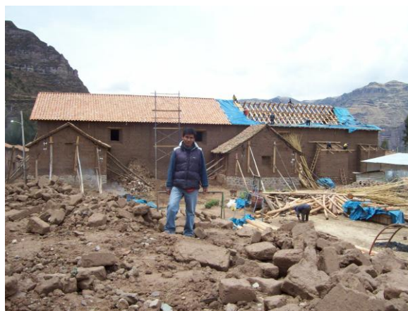
Vista exterior del avance físico de los trabajos de obra.
