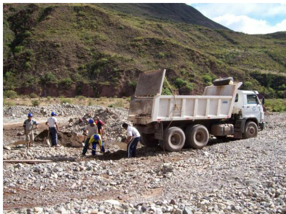
Trabajos de acopio y hormigón en volquete de INC- Cusco.
