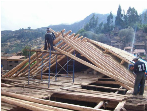
Proceso de colocación de pare y nudillos
