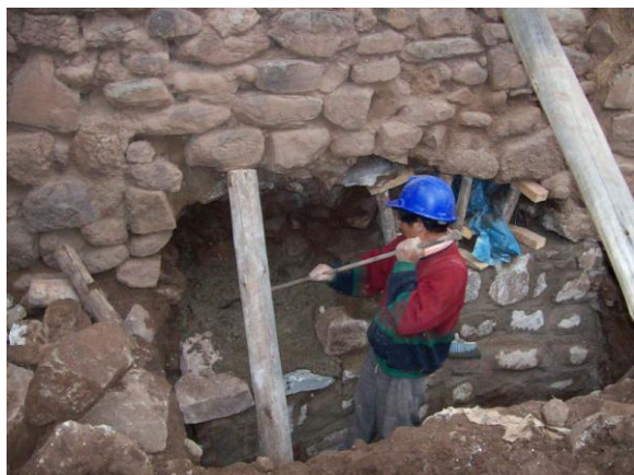
Trabajos de calzaduras de cimientos con piedra y mortero de cal cemento en exterior de muro testero.
