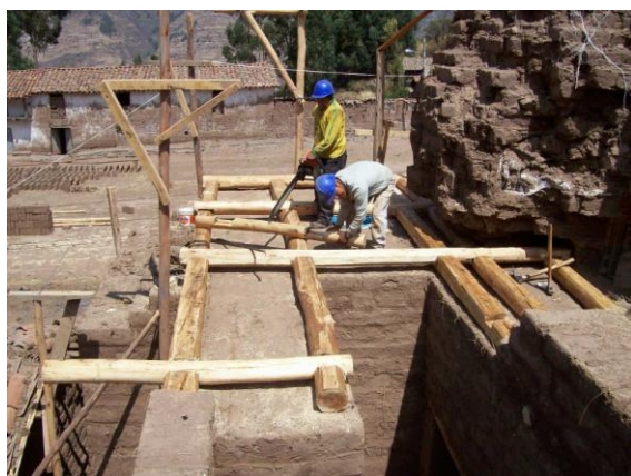
Restitución de llaves en contrafuerte de adobe, lado epístola sector coro.
