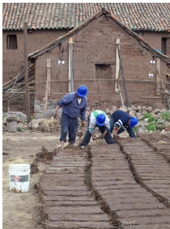
Preparación de barro, para elaboración de adobes.
