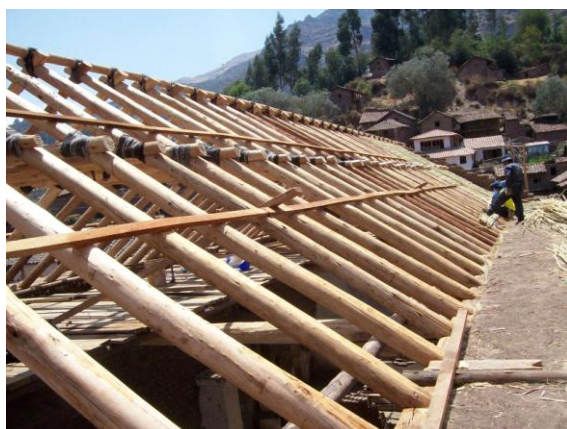
Restitución de correas en el entretecho de par y nudillo
