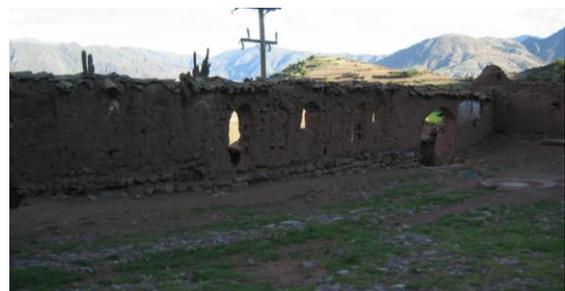
Ambos extremos de la plaza en el Hurin y el Hanan. Estos accesos están compuestos por arcos de medio punto de adobe, el primer arco de acceso está colapsado está conformado por arcos de medio punto aprox. de 0.70cmt. De ancho que constituyen un elemento singular propio de esas épocas.
