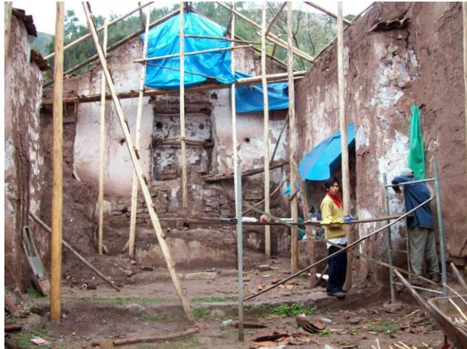
Armado de estructuras de rollizos de eucalipto en el interior del templo para cobertura provisional.
