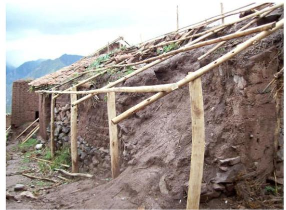
Armado de estructura provisional con rollizos de eucalipto para protección de las lluvias.
