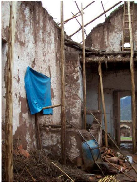
Plantado de pies derechos de rollizos de eucalipto adyacentes al muro de la pistola para cobertura provisional.
