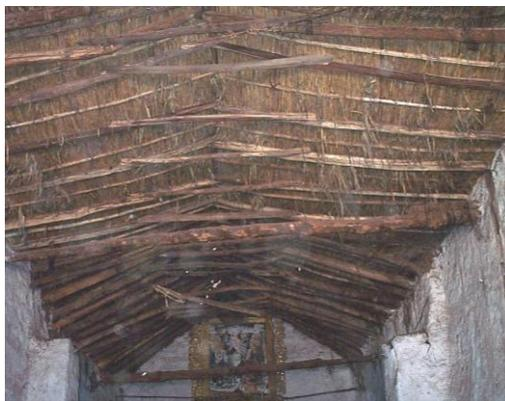
La cobertura del monumento, de acuerdo a las evidencias encontradas y fotos anteriores se observa que está construida en su estructura bajo el sistema de par y nudillo de madera rolliza, sobre la que se han colocado sobrepares, luego un entramado con Kur-Kur, torta de barro y finalmente la teja cerámica colonial. Así también los tirantes colocados a largo tramos de distancia también de palo rollizo.
