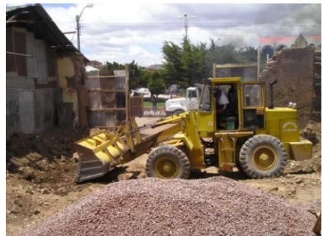
**Fotog. 046 y 047 :** Labores de eliminación de material excedente producto de demolición de Construcciones precarias hacia el lado del atrio lateral del Evangelio próximo a la
