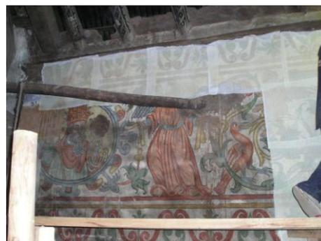
**Fotog. 168 y 169 :** Proceso de veladura o aplicación de gasa sobre superficies de muro con capa áreas a ser desmontadas.
