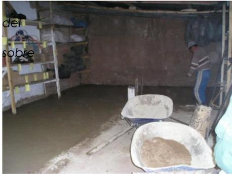
**Fotog. 077 :** Vista del interior del almacén de obra INC, vaciado de falso piso de concreto Empedrado.
