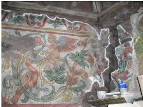
**Fotog. 160 y 161 :** *Vista de aplicación de repellado y nivelación de lagunas, sector de muro testero o trapezoidal posterior al retablo mayor.*
