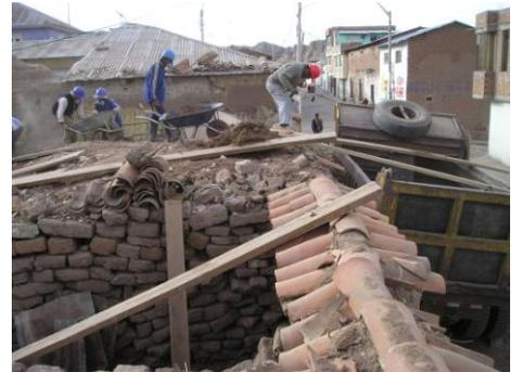
**Fotog. 048 y 049 :** Labores de eliminación de material excedente del sector atrio posterior, Utilizando volquete de servicio particular.
