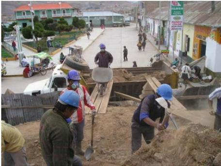
**Fotog. 050 :** Labores de eliminación de material excedente con bugui (desmote) del atrio principal al volquete para su eliminación.
