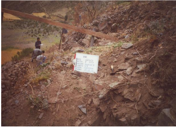
SI. 5E muro cont3. Unidad 9 Vista donde Muestra la superficie
