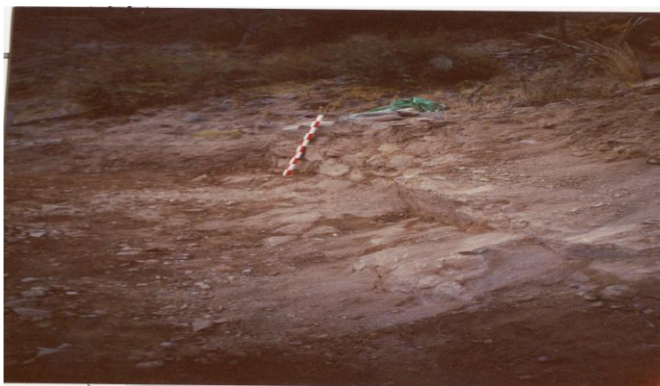
Vista donde se muestra la roca intemperizada desprendida Donde se encontraba asentado el muro el muro originando el colapso
