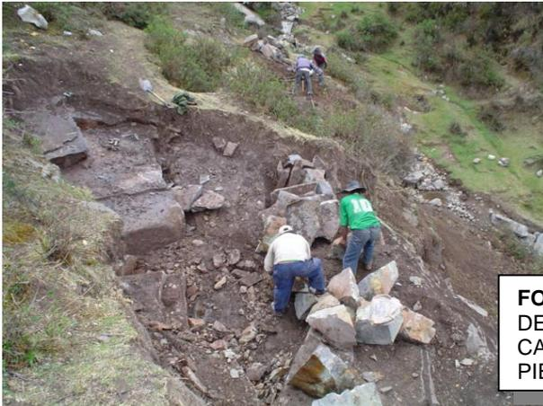
**FOTO Nº 21 TRABAJOS DE LIMPIEZA Y DESQUINCHE EN FORMA MANUAL EN CANTERA PARA LA EXTRACCIÓN DE PIEDRA.**
