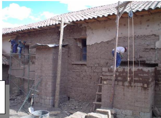
**FOTO Nº 18** ARMADO DE POLEA PARA REALIZAR TRABAJOS POR ENCIMA DEL NIVEL DEL PISO TERMINADO.
