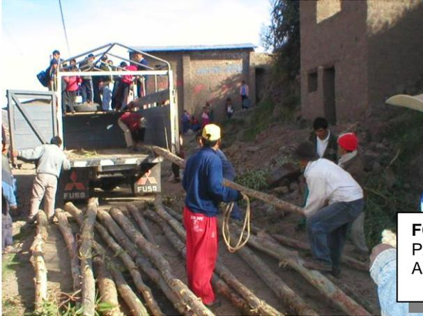
**FOTO N° 23** TRASLADO DE ROLLIZOS PARA REALIZAR TRABAJOS DE APUNTALAMIENTOS EN OBRA.
