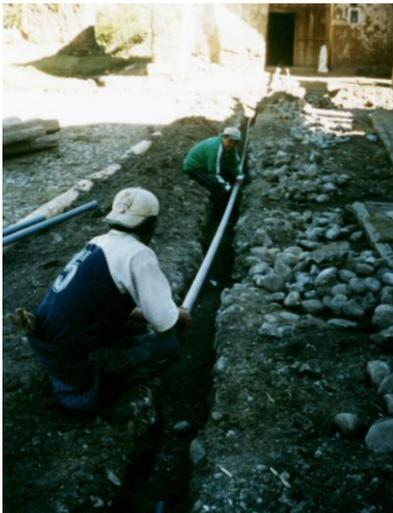
FOTO N° 15 INSTALACION PROVICIONAL DE TUBERIA PARA EL APROVICIONAMIENTO DE AGUA EN OBRA.
