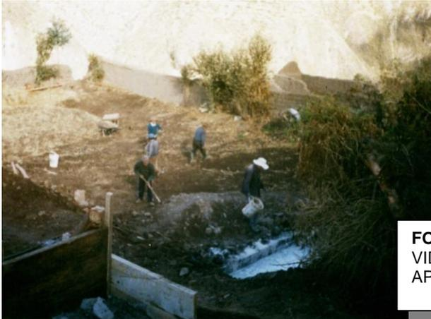
**FOTO Nº 16** TRASLADO DE AGUA EN VIDONES AL POZO DE CAL PARA EL APAGADO DE LA CAL
