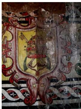
Se realizó trabajos de limpieza de pintura mural hacia el muro testero, liberando pintura corriente la se encontraba sobre la pintura mural original.
