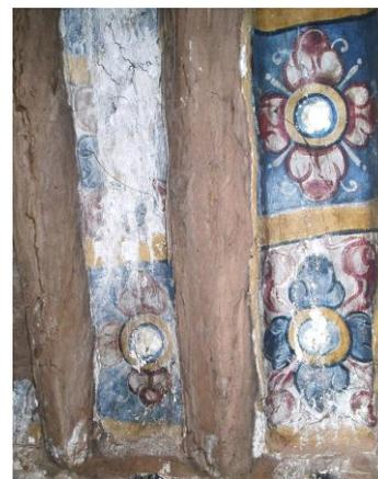
Se realizó la liberación de los lienzos que se encontraban hacia el muro de la epístola parte superior; dicho proceso nos llevo a encontrar pintura mural a la altura de la cabecera del muro; esta pintura requiere de intervención en limpieza y estaco para completar la calzadura de muros puesto que presenta fisuras a intervenir. En el resto de los sectores requiere consolidación.
