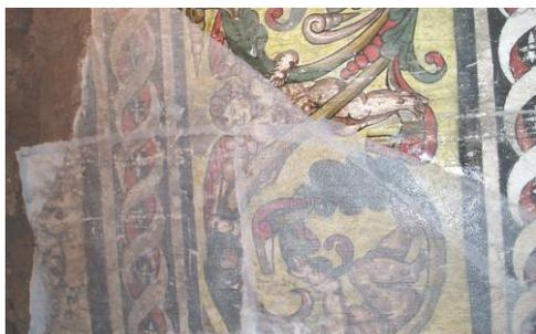
Hacia la cabecera del muro testero y de sectores donde de acuerdo a lo proyectado para la colocación de llaves, afectaba la integridad, se procedió a realizar el estaco de la pintura mural.
